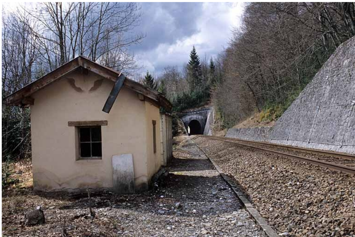
Vue d'ensemble, depuis le nord. Tunnel de Sous la Côte à l'arrière-plan. 39, La Rixouse, lieudit : Bois Joura et Cotats
