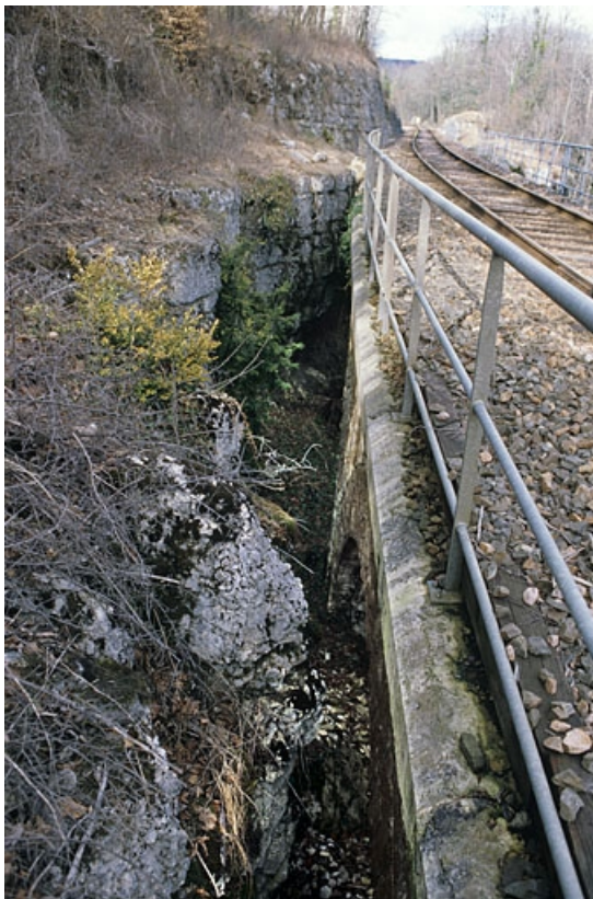
Ravine et élévation postérieure (ouest), vue en enfilade.
