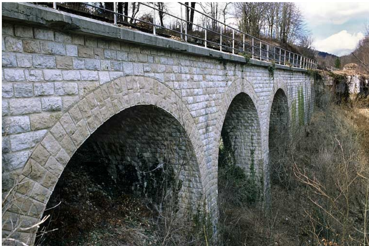
Vue d'ensemble en enfilade, depuis le côté La Cluse (sud).
