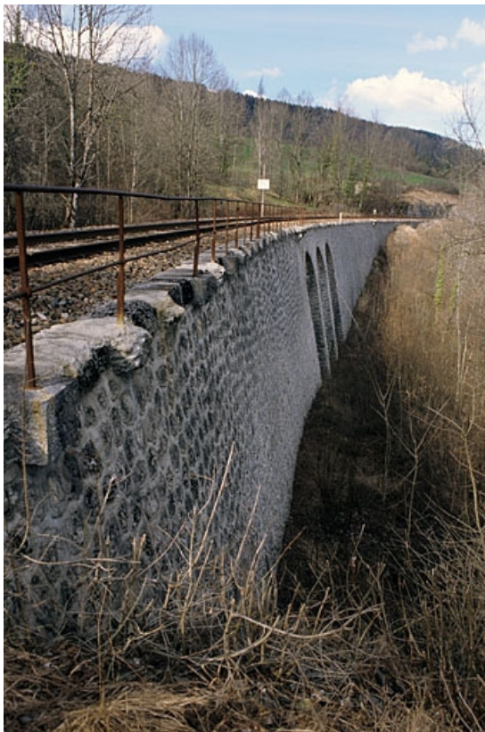
Vue d'ensemble en enfilade, depuis le côté La Cluse (sud).
