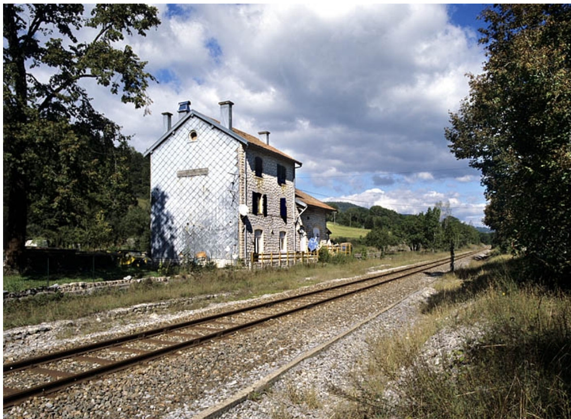
Vue d'ensemble, depuis le sud (façade postérieure).
