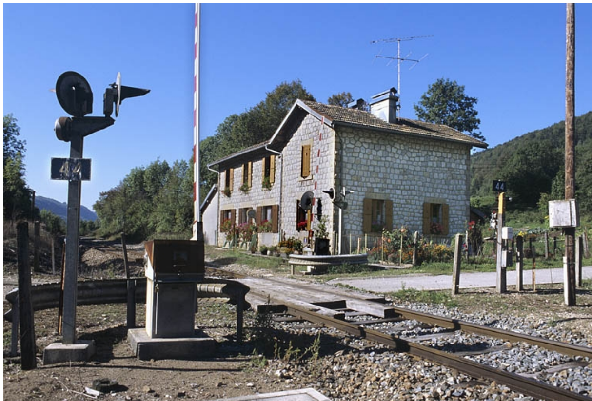
Vue d'ensemble, depuis le nord-est. 39, Lézat rue de la Gare
