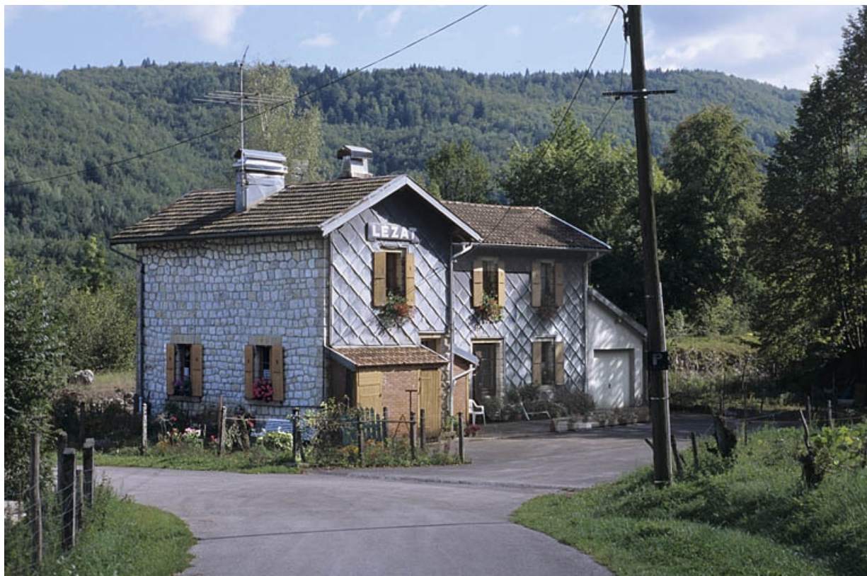
Façades antérieure et latérale gauche.
