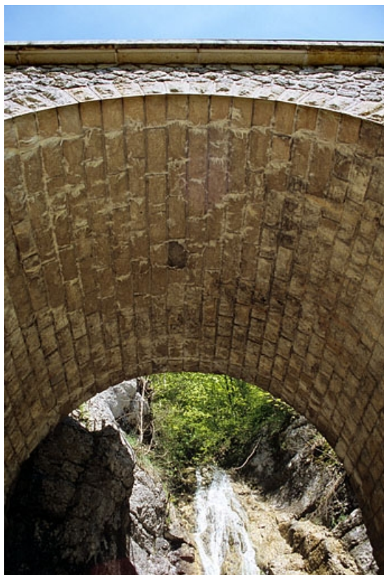
Viaduc : arche, vue du dessous.
