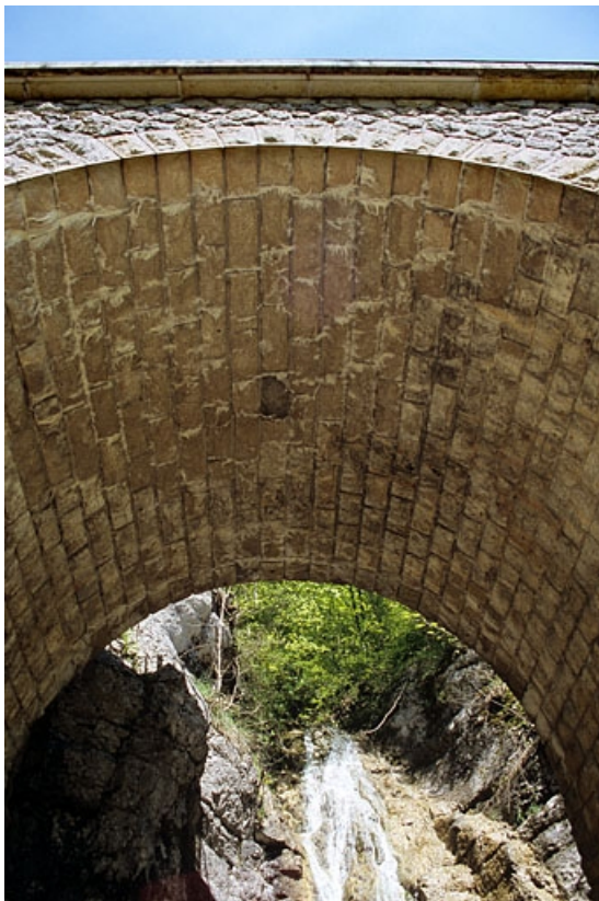
Viaduc : arche, vue du dessous.
