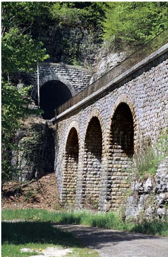
Viaduc et tunnel, depuis le chemin départemental n° 126 à l'est (côté Andelot-en-Montagne). 39, Lézat C.D. 126, lieudit : les Mouillés
