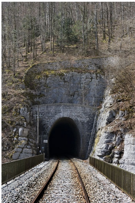
Tunnel : tête côté Andelot-en-Montagne (est). 39, Lézat C.D. 126, lieudit : les Mouillés
