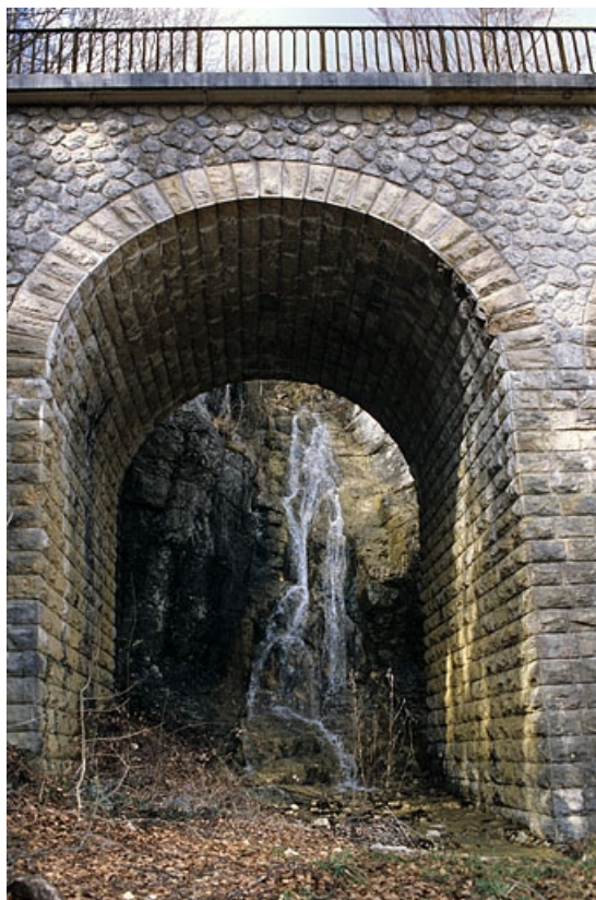
Viaduc : arche, montrant le ruisseau de la Culée.
