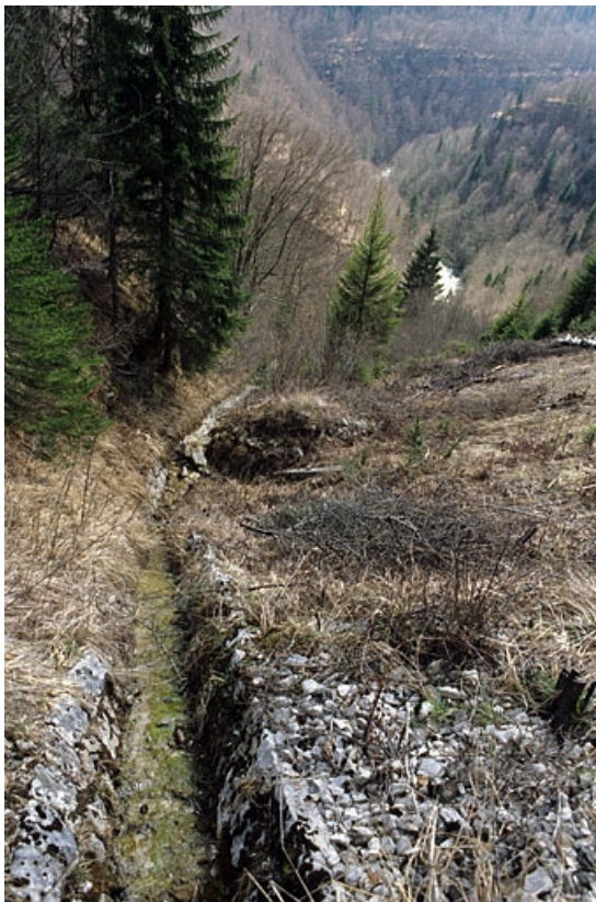
Tunnel : rigole d'évacuation d'eau de la tête côté La Cluse.
