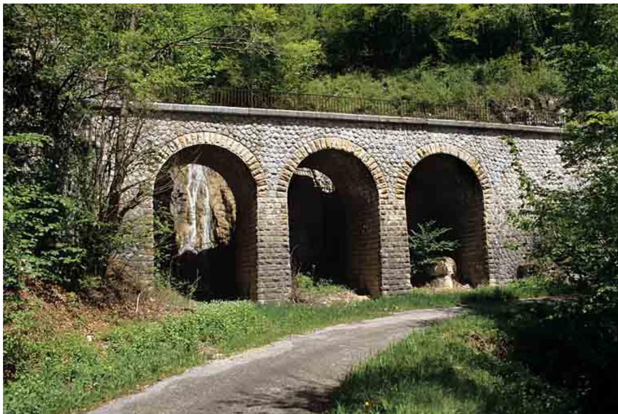
Viaduc, vu de trois quarts gauche.
