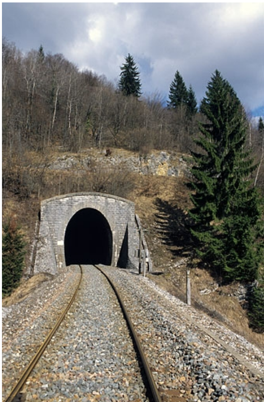
Tunnel : tête côté La Cluse (ouest).
