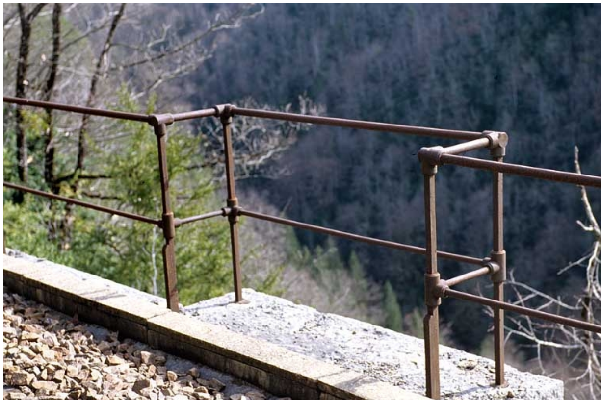
Mur : garde-corps métallique d'un refuge.
