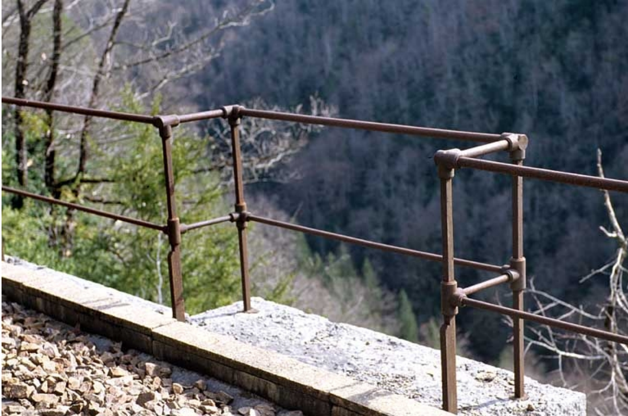
Mur : garde-corps métallique d'un refuge. 39, Lézat C.D. 126, lieudit : les Mouillés
