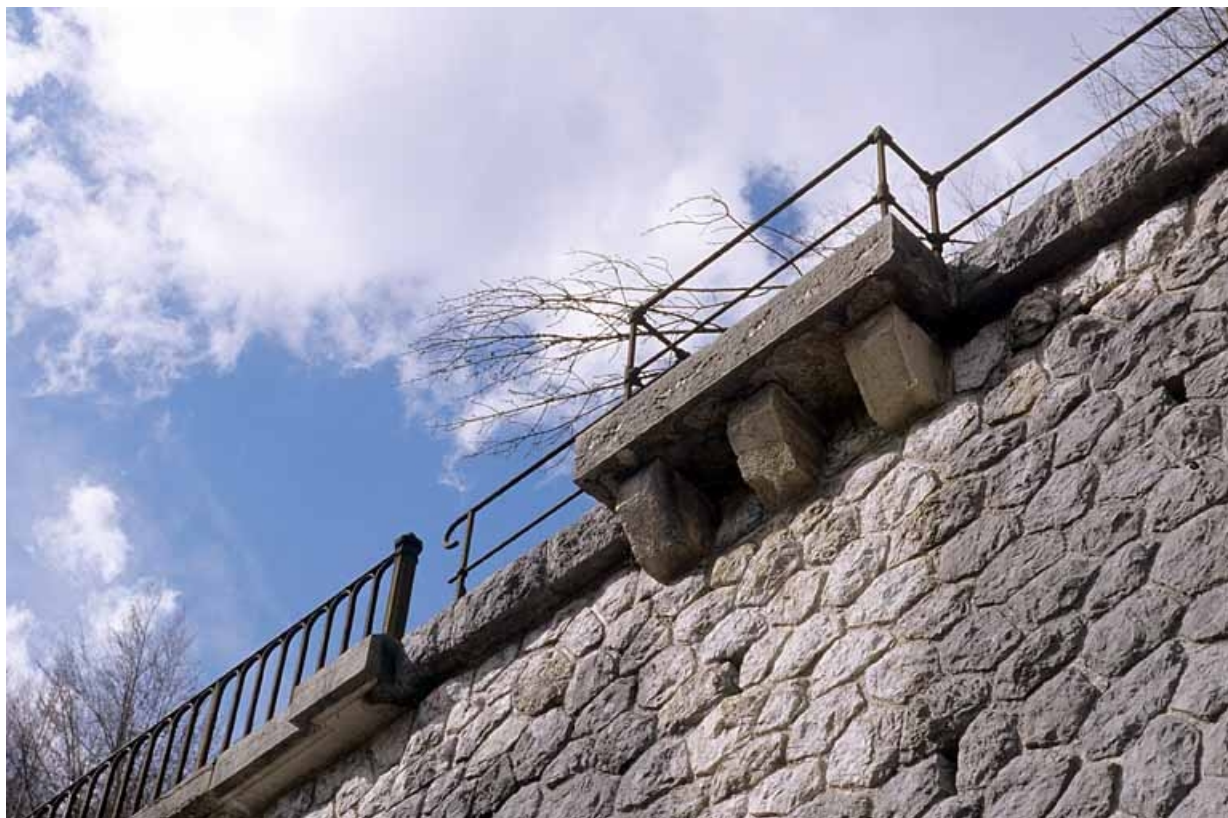
Garde-corps métalliques du mur (à droite) et du viaduc (à gauche), vus depuis la route.
