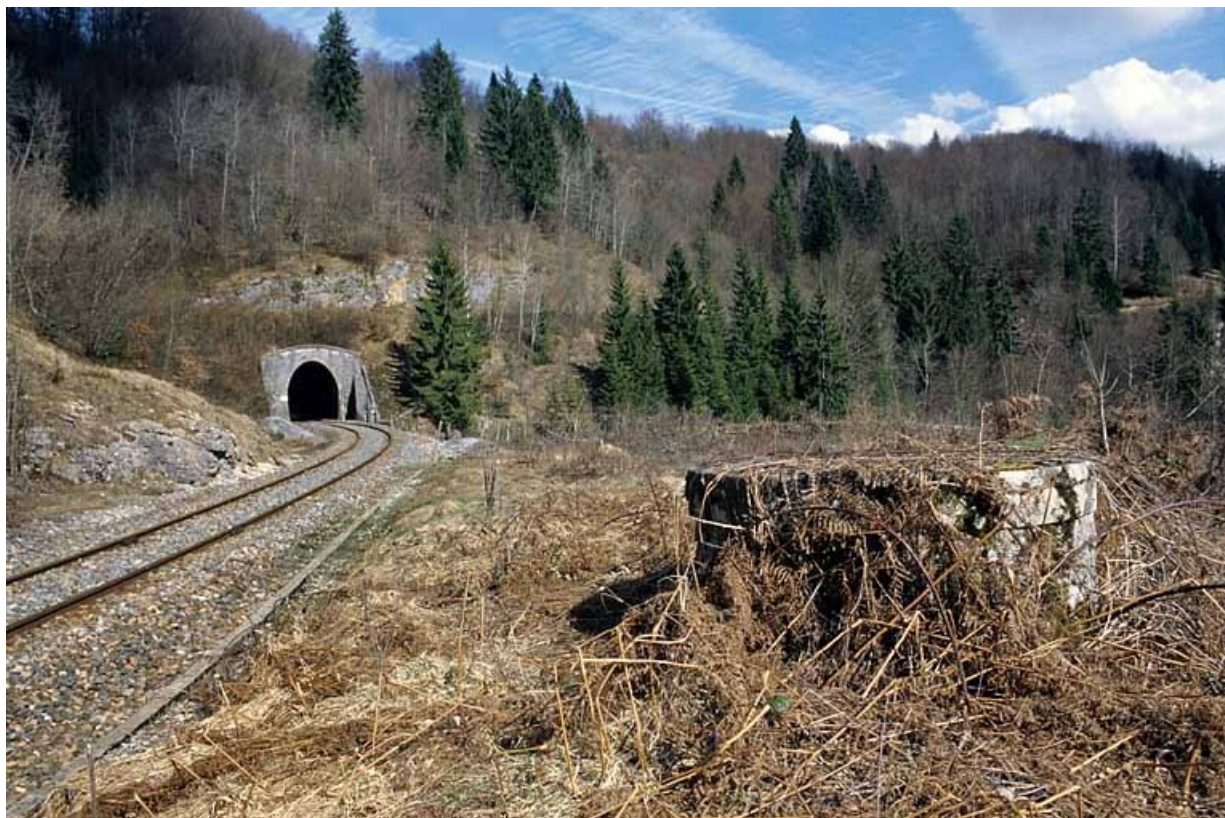
Au premier plan, puits de la maison de garde-barrière n° 42 (détruite).
