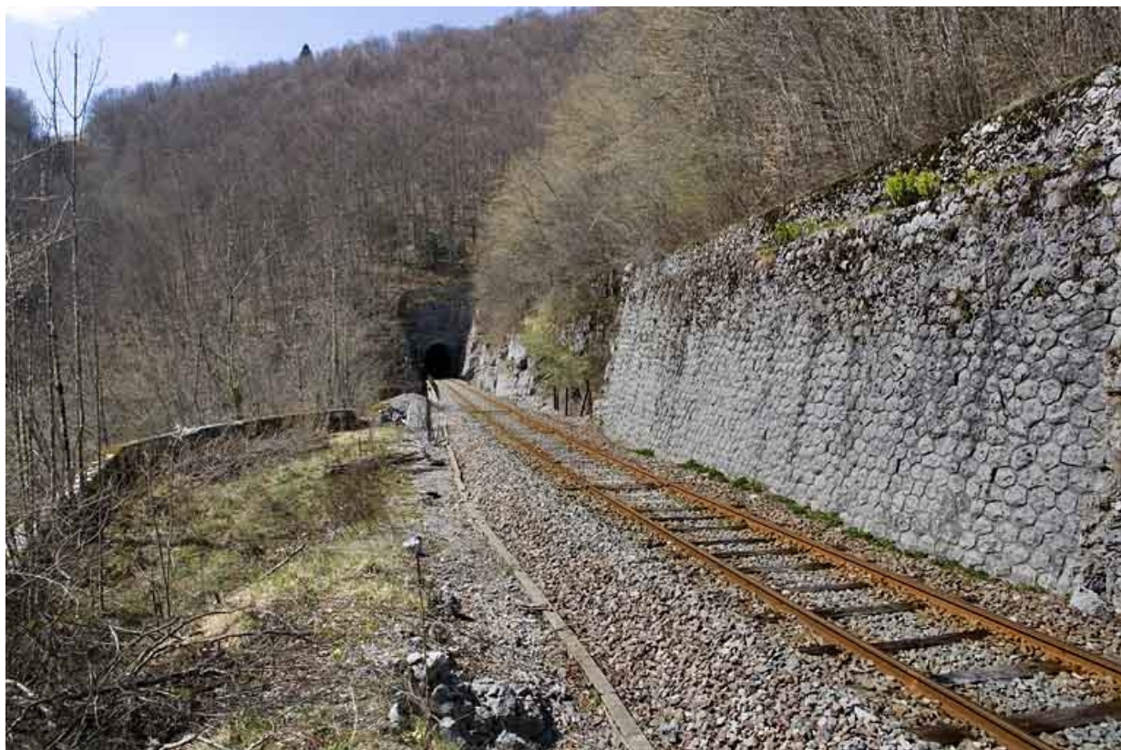
Vue d'ensemble, depuis le côté Andelot-en-Montagne (nord-est). Emplacement du passage à niveau au premier plan, mur de soutènement à droite.
