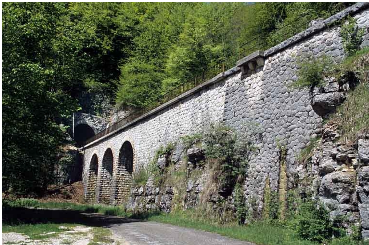
Murs de soutènement et viaduc, depuis le chemin départemental n° 126 à l'est (côté Andelot-en-Montagne). 39, Lézat C.D. 126, lieudit : les Mouillés
