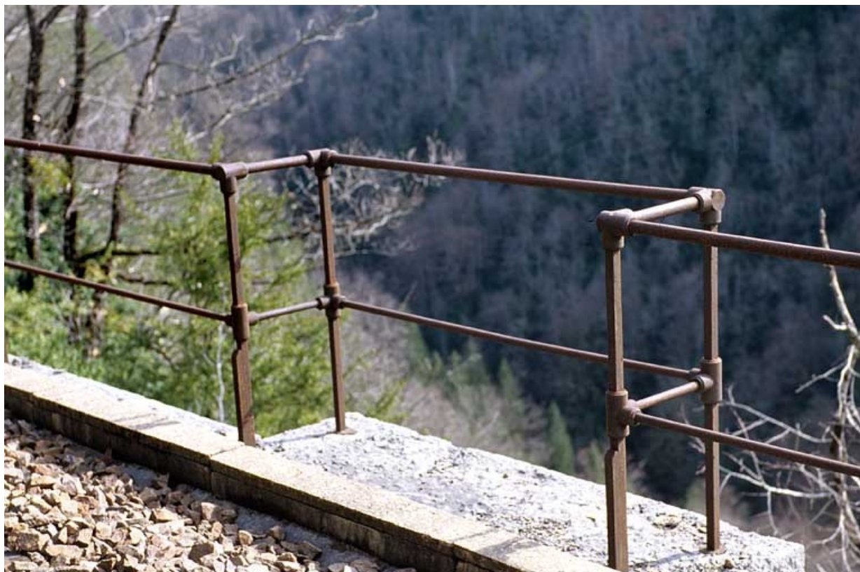
Mur : garde-corps métallique d'un refuge.
