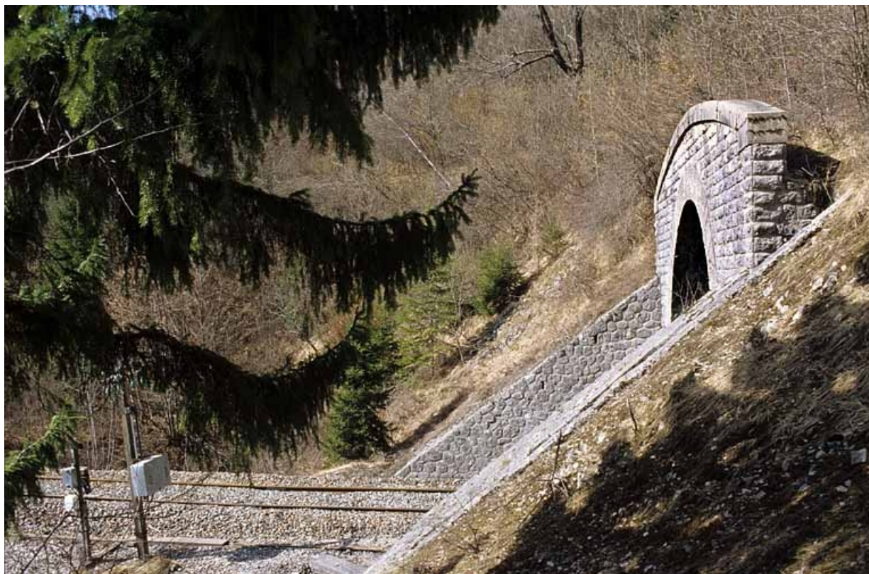
Tunnel : tête côté La Cluse, vue de profil.
