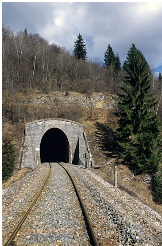
Tunnel : tête côté La Cluse (ouest).
