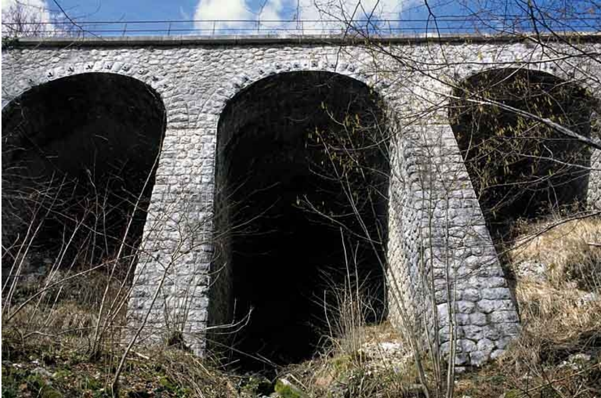
Mur de soutènement de la route : arcades.
