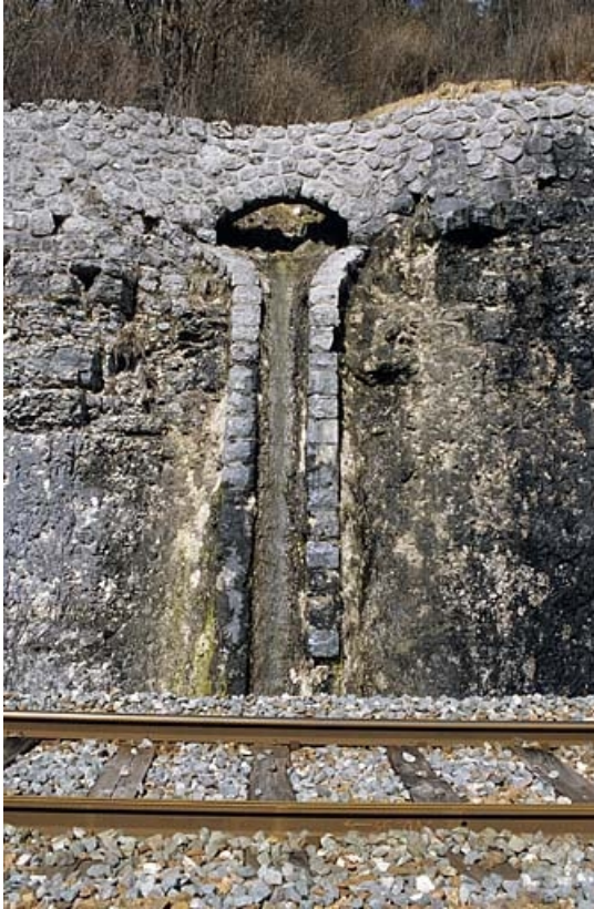
Descente d'eau dans le mur de protection à droite de la voie.
