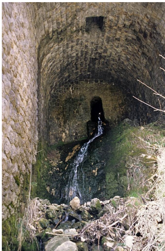
Mur de soutènement de la route : aqueduc, dans l'arche centrale.
