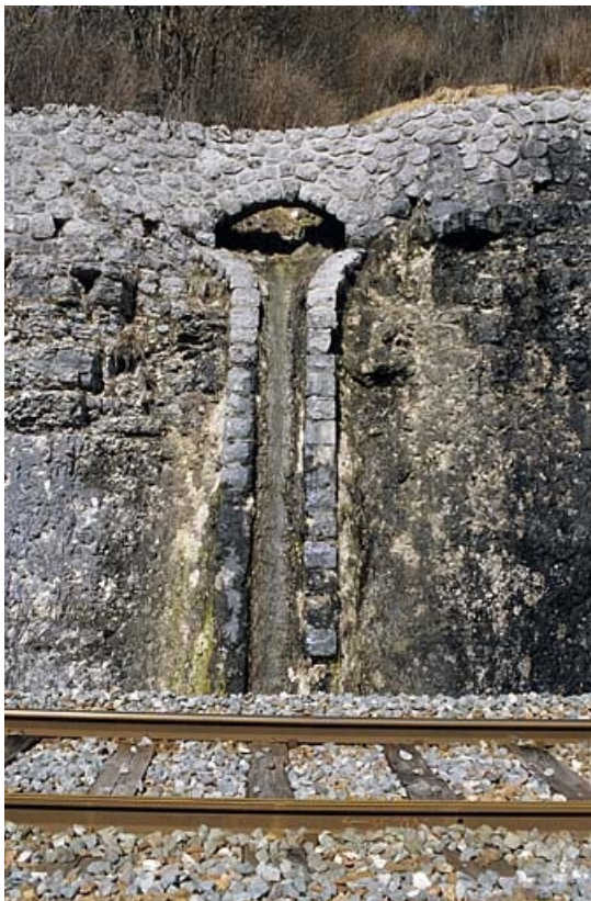
Descente d'eau dans le mur de protection à droite de la voie.
