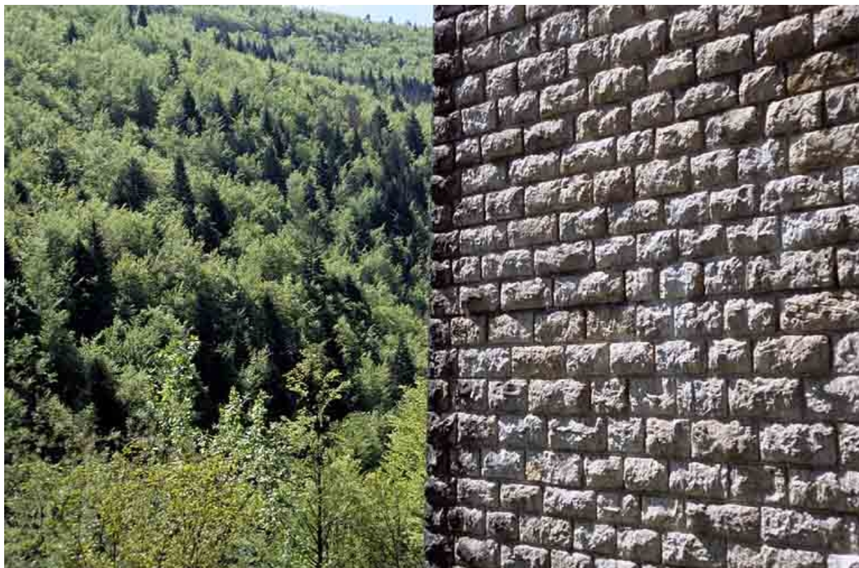
Viaduc du Puits : parement d'une pile.
