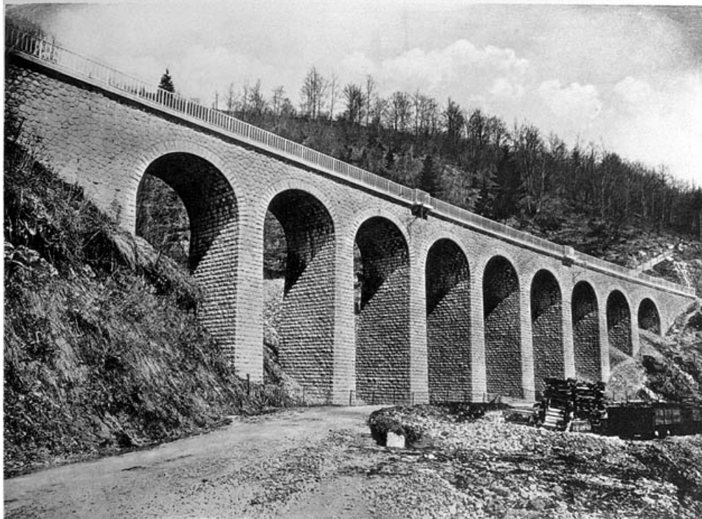
Viaduc du Puits [élévation sud-est (aval), vue de trois quarts gauche], [1919].
