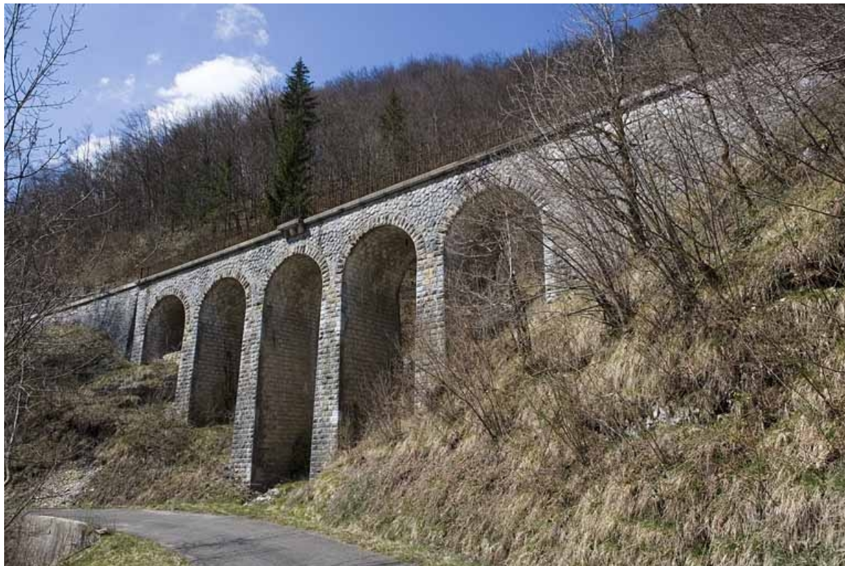
Viaduc du Crêt : élévation aval (sud-est), de trois quarts droite.
