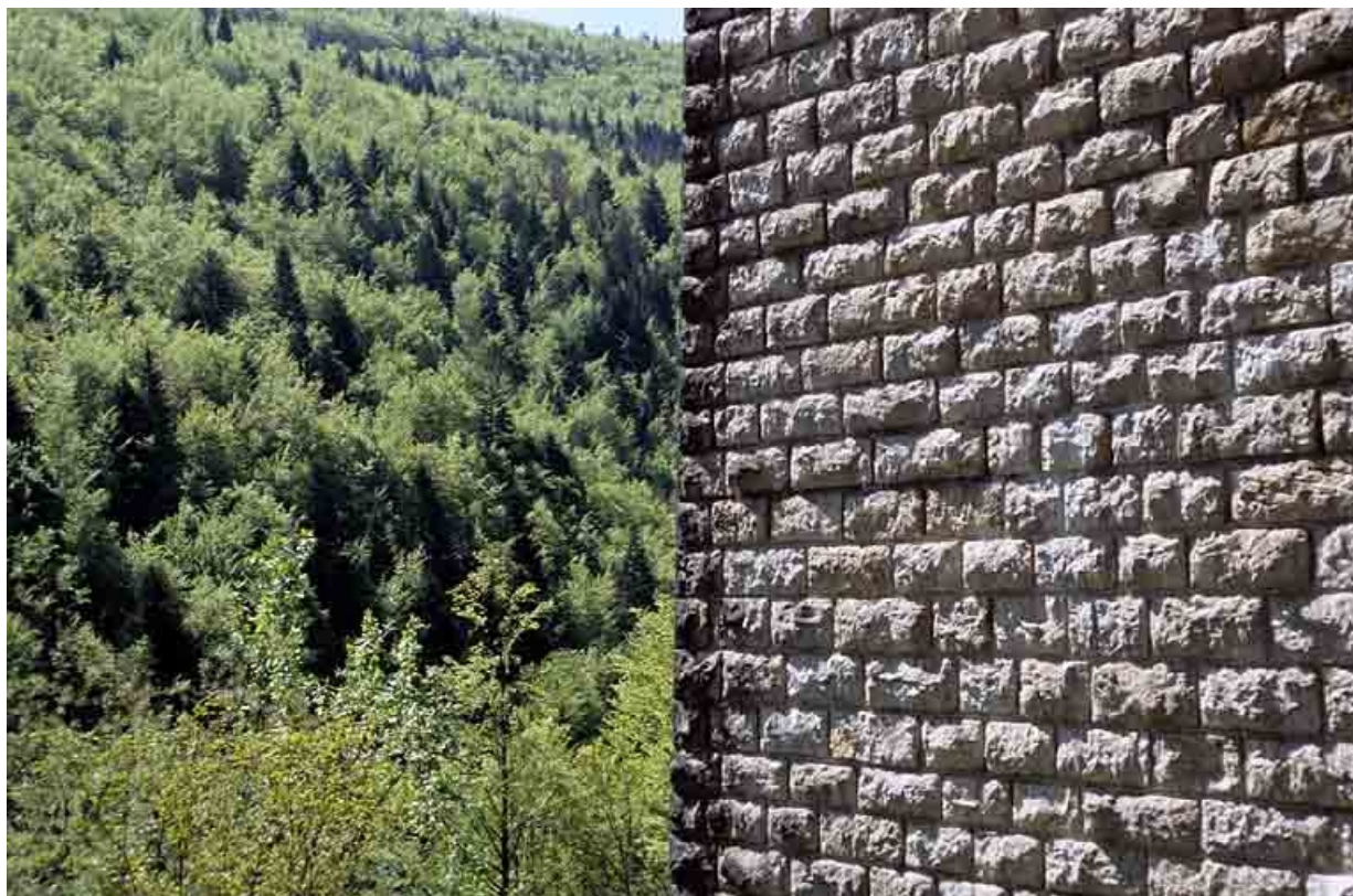
Viaduc du Puits : parement d'une pile.
