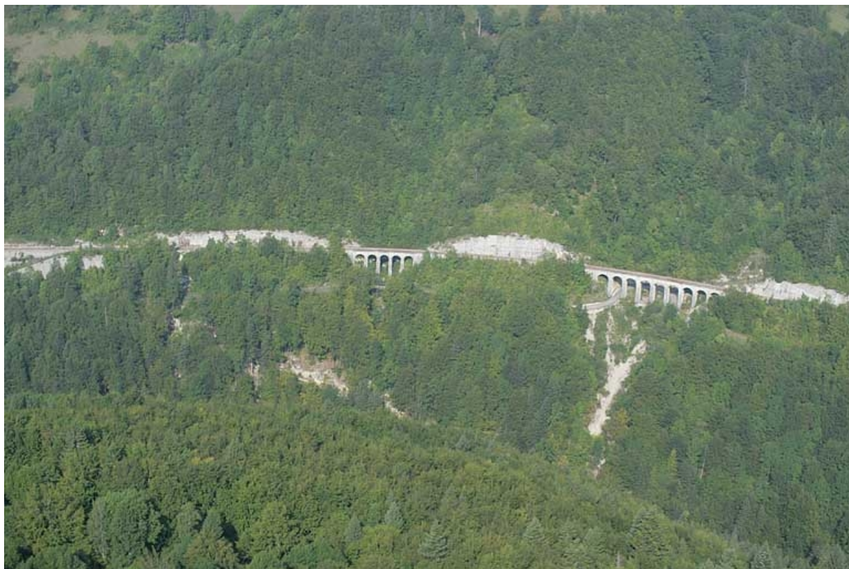
Vue aérienne des deux viaducs, depuis le sud-est. 39, Morbier
