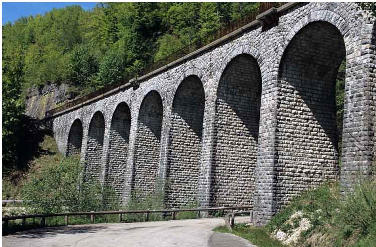
Viaduc du Puits : élévation aval, de trois quarts droite (vue rapprochée).
