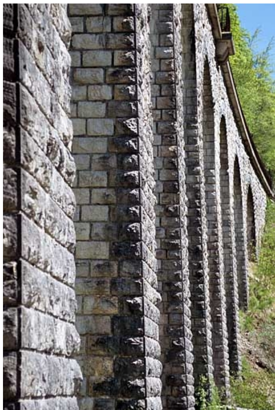
Viaduc du Puits : piles vues en enfilade.
