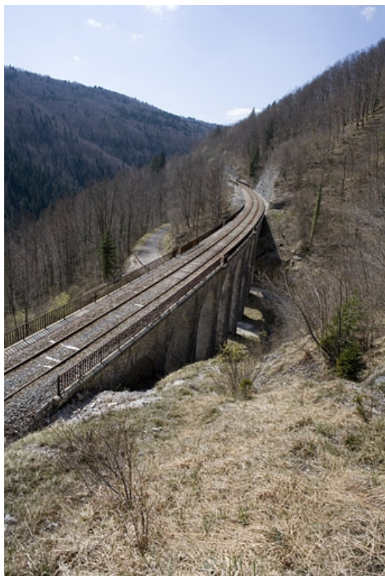
Vue d'ensemble des viaducs et de la voie, depuis le nord-est (côté Andelot-en-Montagne). 65, Tancua C.D. 126, lieudit : Côte de Bandu
