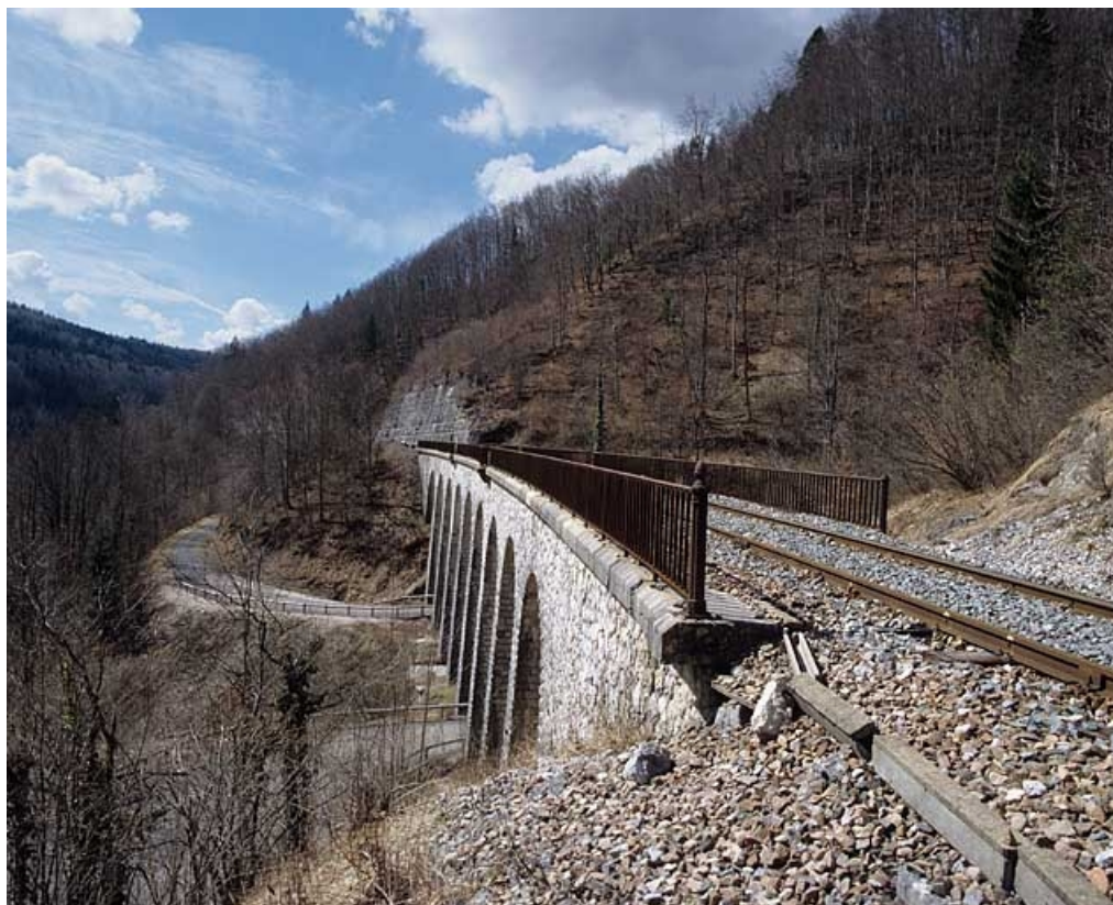
Viaduc du Puits : élévation aval, vue en enfilade depuis le côté Andelot-en-Montagne (nord-est). 65, Tancua C.D. 126, lieudit : Côte de Bandu
