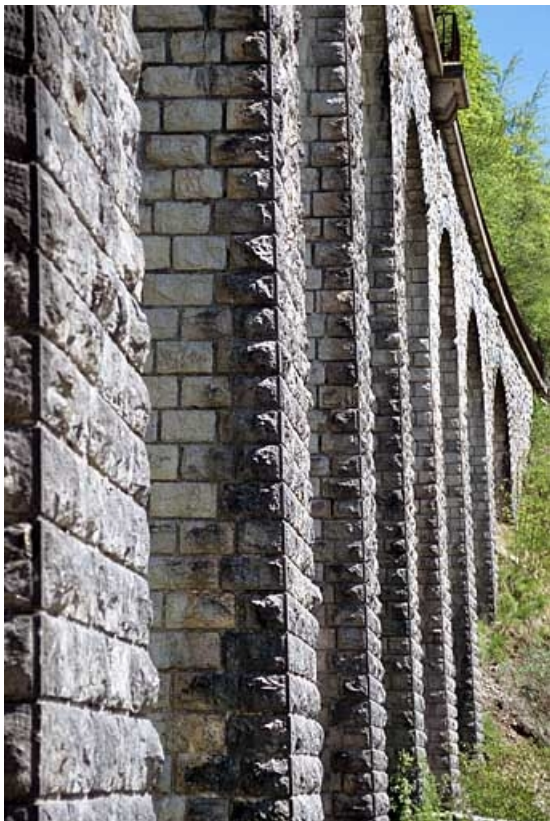
Viaduc du Puits : piles vues en enfilade.
