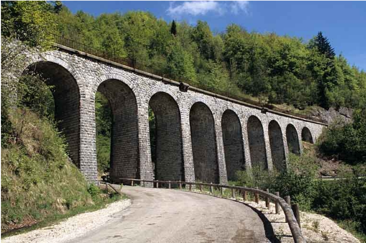
Viaduc du Puits : élévation aval (sud-est), de trois quarts gauche. 65, Tancua C.D. 126, lieudit : Côte de Bandu
