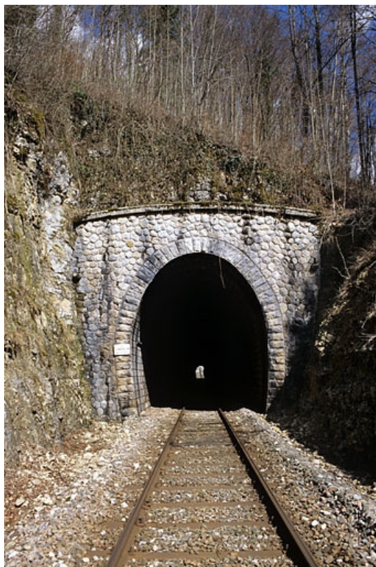
Tunnel du Grépillon : tête côté La Cluse (sud). 65, Tancua, lieudit : la Côte
