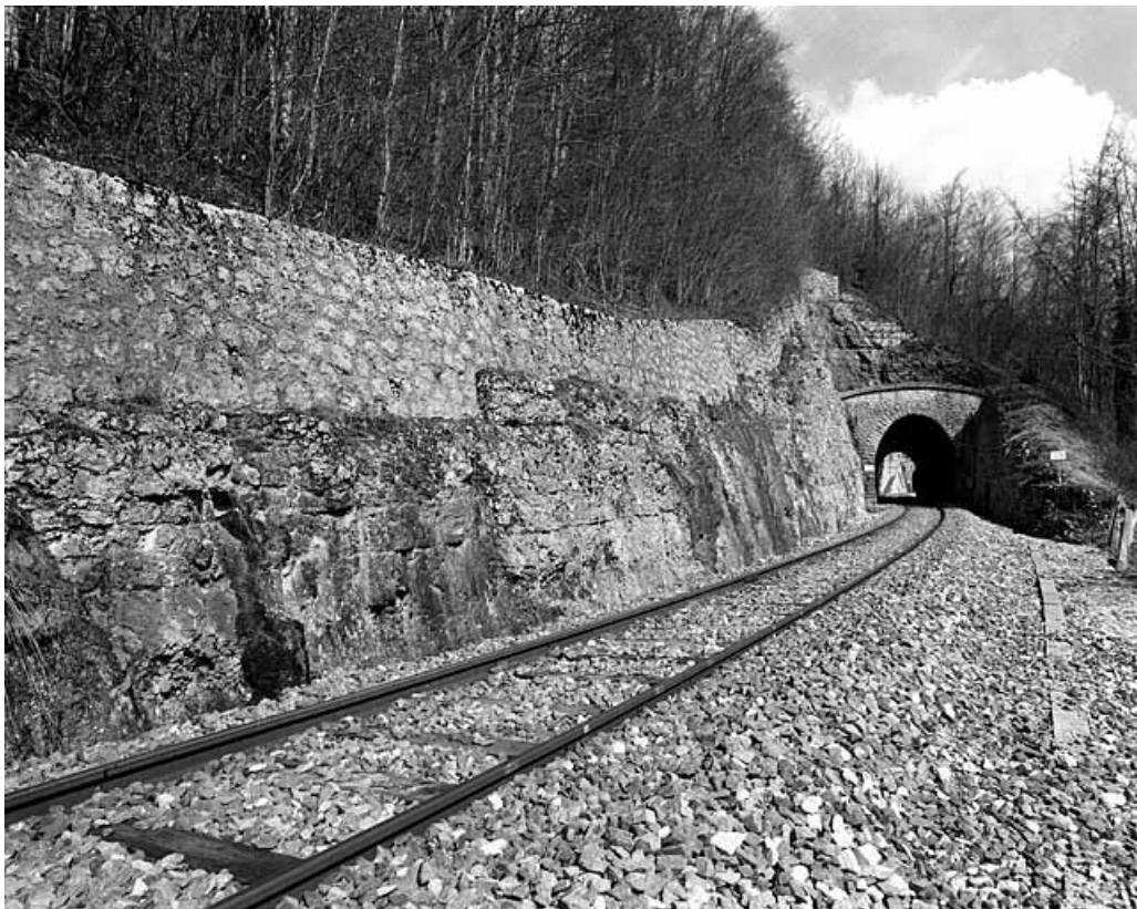
Tunnel de Tancua : vue d'ensemble, côté La Cluse (sud). 39, Morbier, lieudit : la Côte
