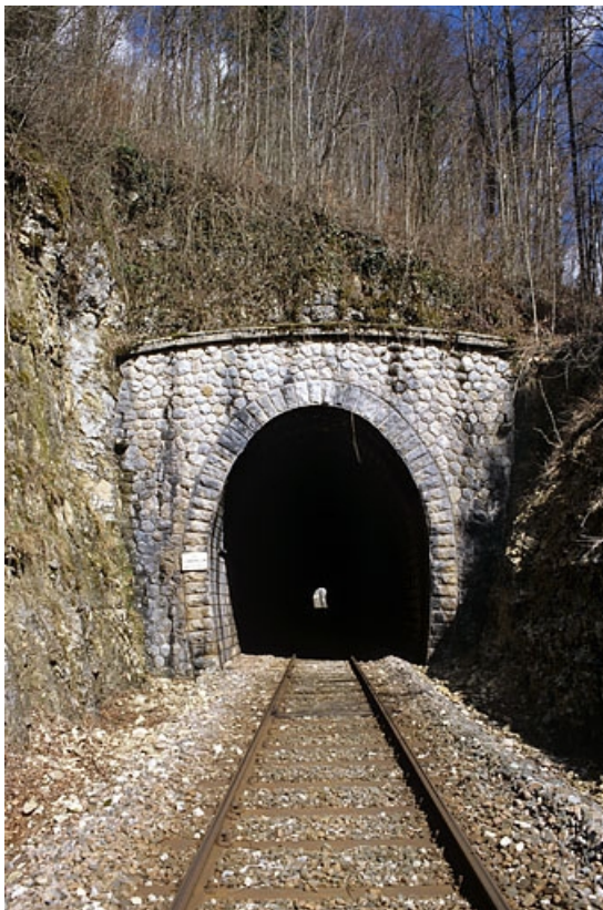
Tunnel du Grépillon : tête côté La Cluse (sud). 39, Morbier, lieudit : la Côte
