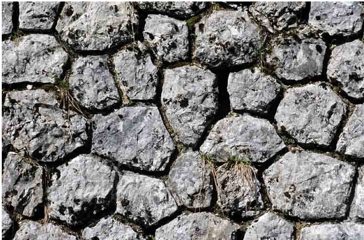
Tunnel du Chalet : détail de l'appareil du mur en aile, côté La Cluse. 65, Tancua, lieudit : la Côte
