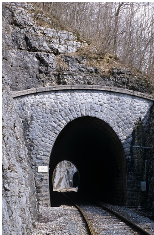
Tunnel de Tancua : tête côté La Cluse (sud).
