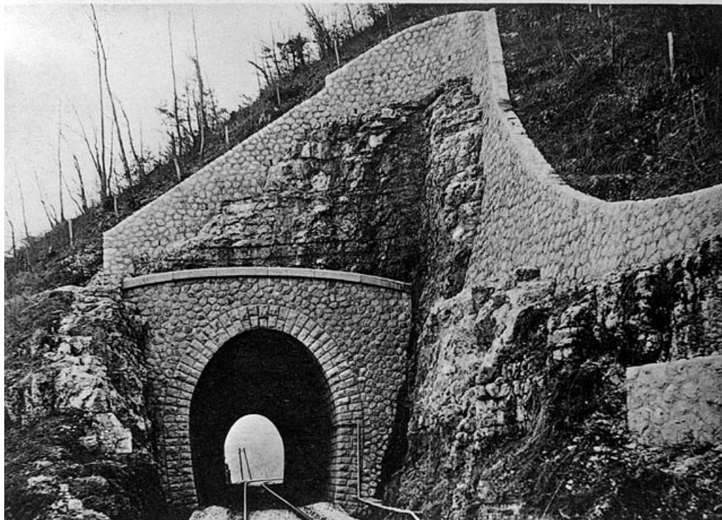
Souterrain de Tancua. Tête Morez, [1919]. 39, Morbier, lieudit : la Côte
