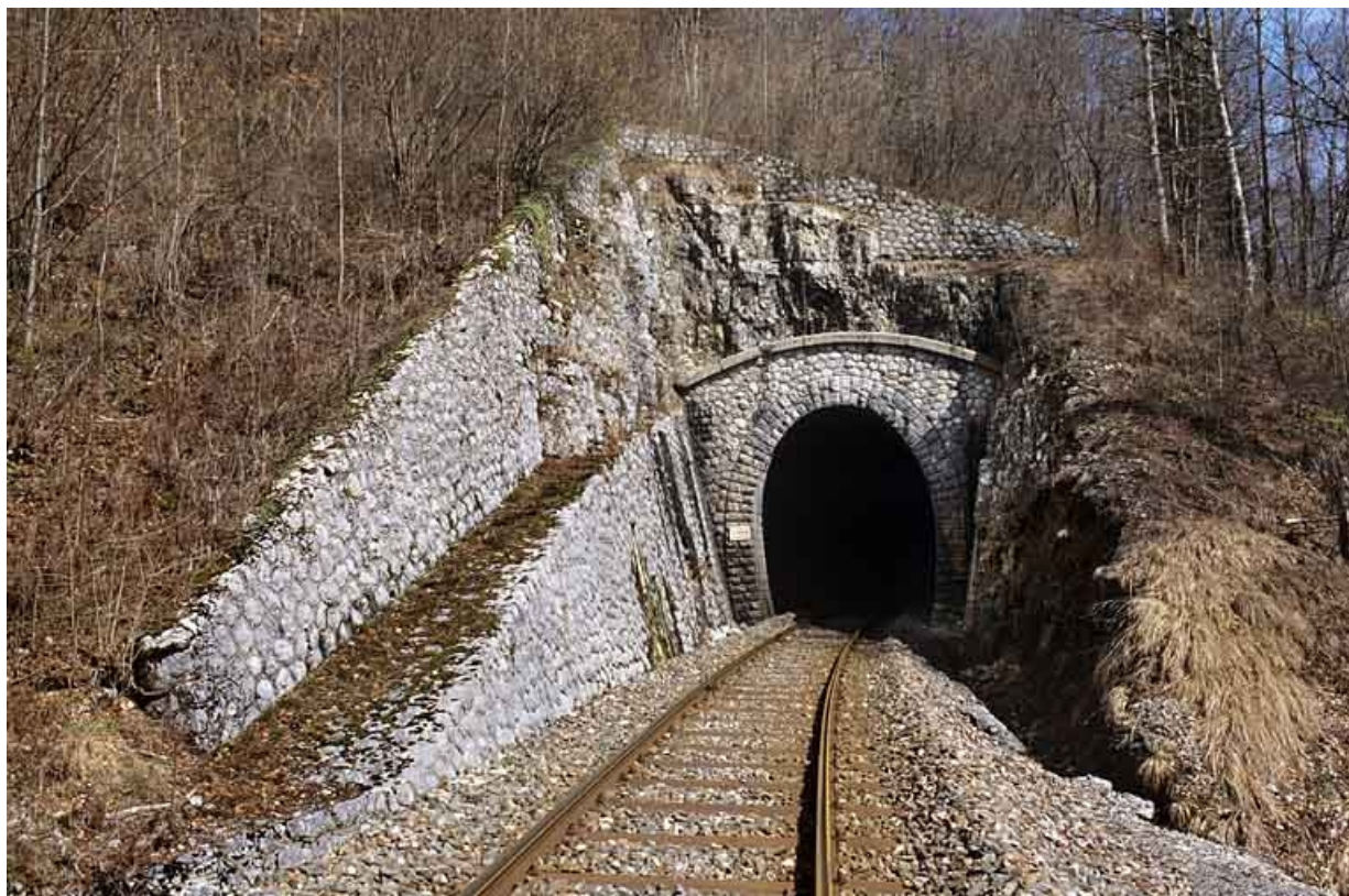
Tunnel du Chalet : vue d'ensemble, côté La Cluse (sud). À gauche, mur en aile sur deux niveaux. 39, Morbier, lieudit : la Côte
