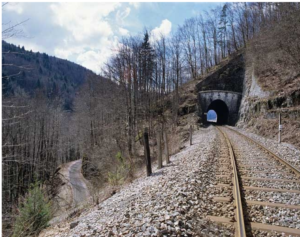
Tunnel de Tancua : vue d'ensemble, côté Andelot-en-Montagne (nord). 39, Morbier, lieudit : la Côte
