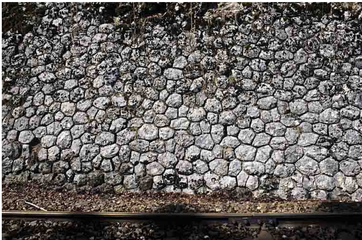
Tunnel du Chalet : appareil du mur en aile, côté La Cluse.
