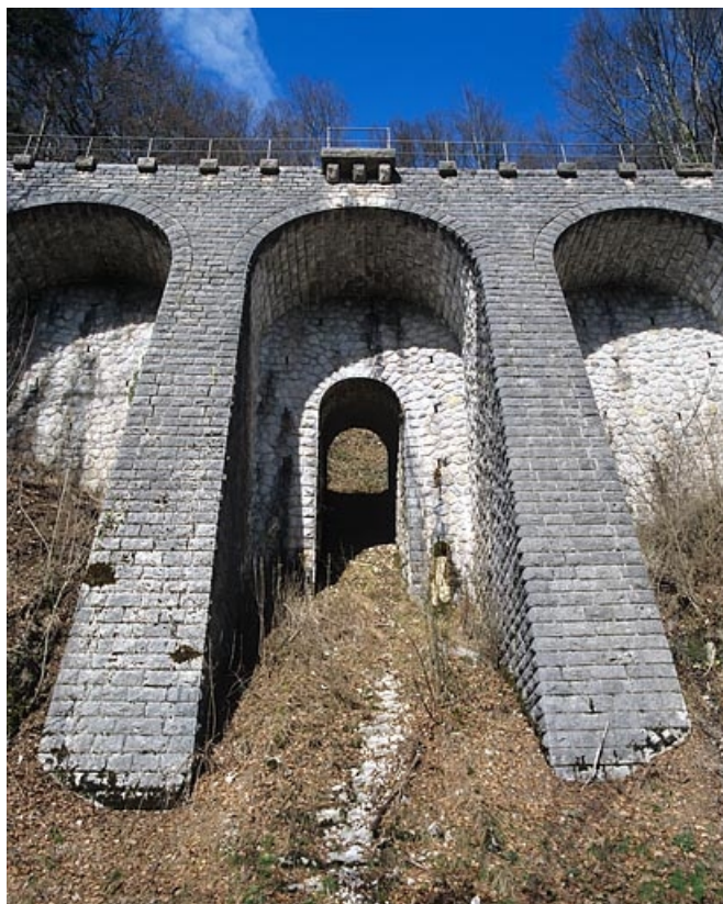
Arcade centrale, avec refuge et pont.
