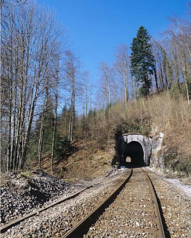
Tunnel des Bataillards : vue d'ensemble rapprochée de la tête côté Andelot-en-Montagne (est). 39, Morbier, lieudit : la Doye de Bienne
