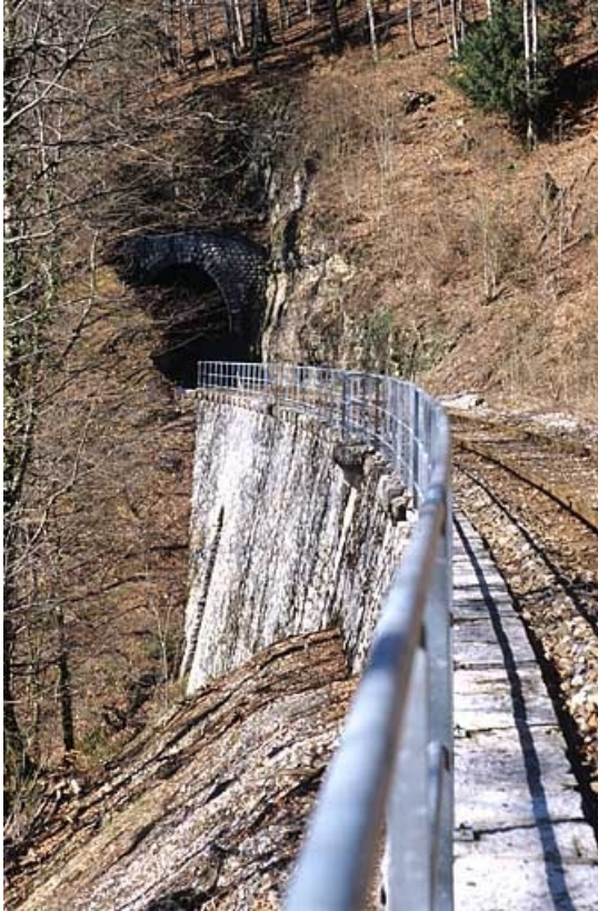
Tunnel de Lézair : tête côté Andelot-en-Montagne (nord-est). Cette tête est précédée par un mur de soutènement à gauche de la voie.
