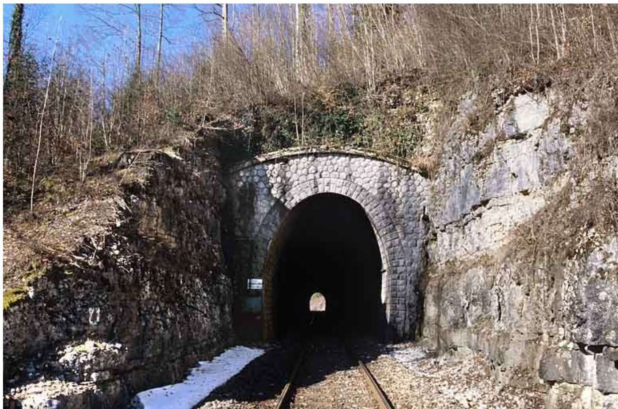
Tunnel des Bataillards : tête côté Andelot-en-Montagne (est).
