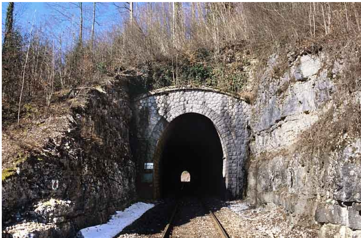
Tunnel des Bataillards : tête côté Andelot-en-Montagne (est).
