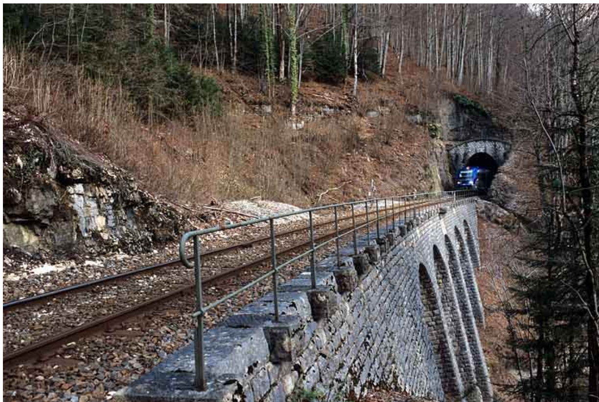
Tunnel de Lézair : tête côté La Cluse (sud-ouest), avec autorail X 73500. Cette tête est suivie d'un mur de soutènement à arcades à gauche de la voie.
