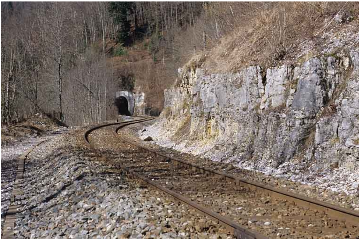
Tunnel des Bataillards : vue d'ensemble de la tête côté Andelot-en-Montagne (est).
