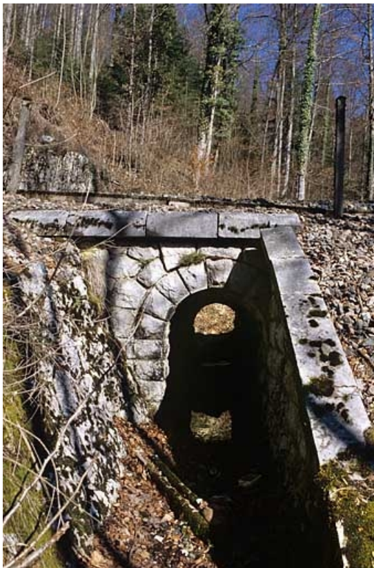
Vue d'ensemble, depuis l'aval (sud).
