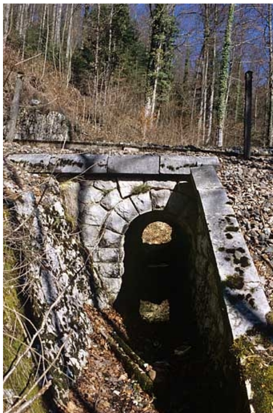
Vue d'ensemble, depuis l'aval (sud).
