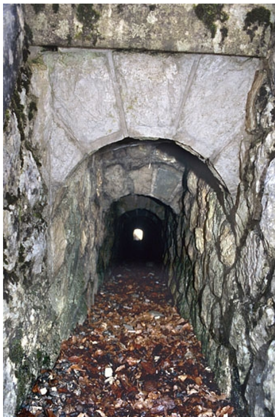
Voûte appareillée en rouleaux à ressauts, vue depuis l'amont (nord). 39, Morbier, lieudit : la Doye Gabet
