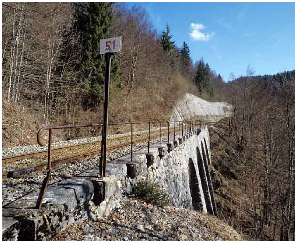
Vue d'ensemble en enfilade, depuis le sud-ouest.
