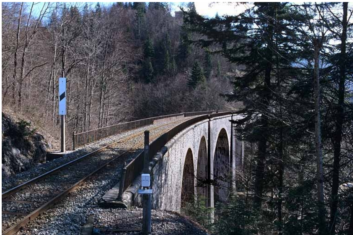
Vue d'ensemble en enfilade, depuis le côté La Cluse (ouest).
