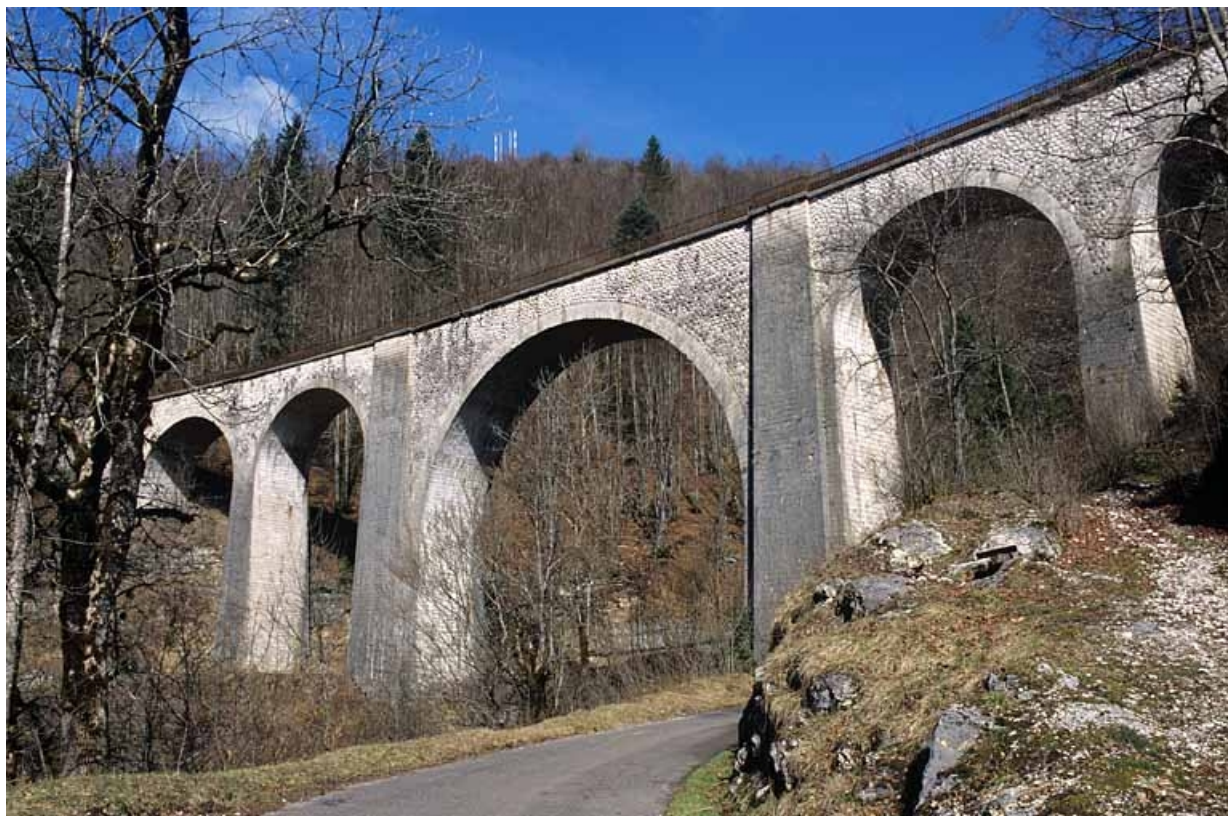
Élévation sud (aval), vue de trois quarts droite.
