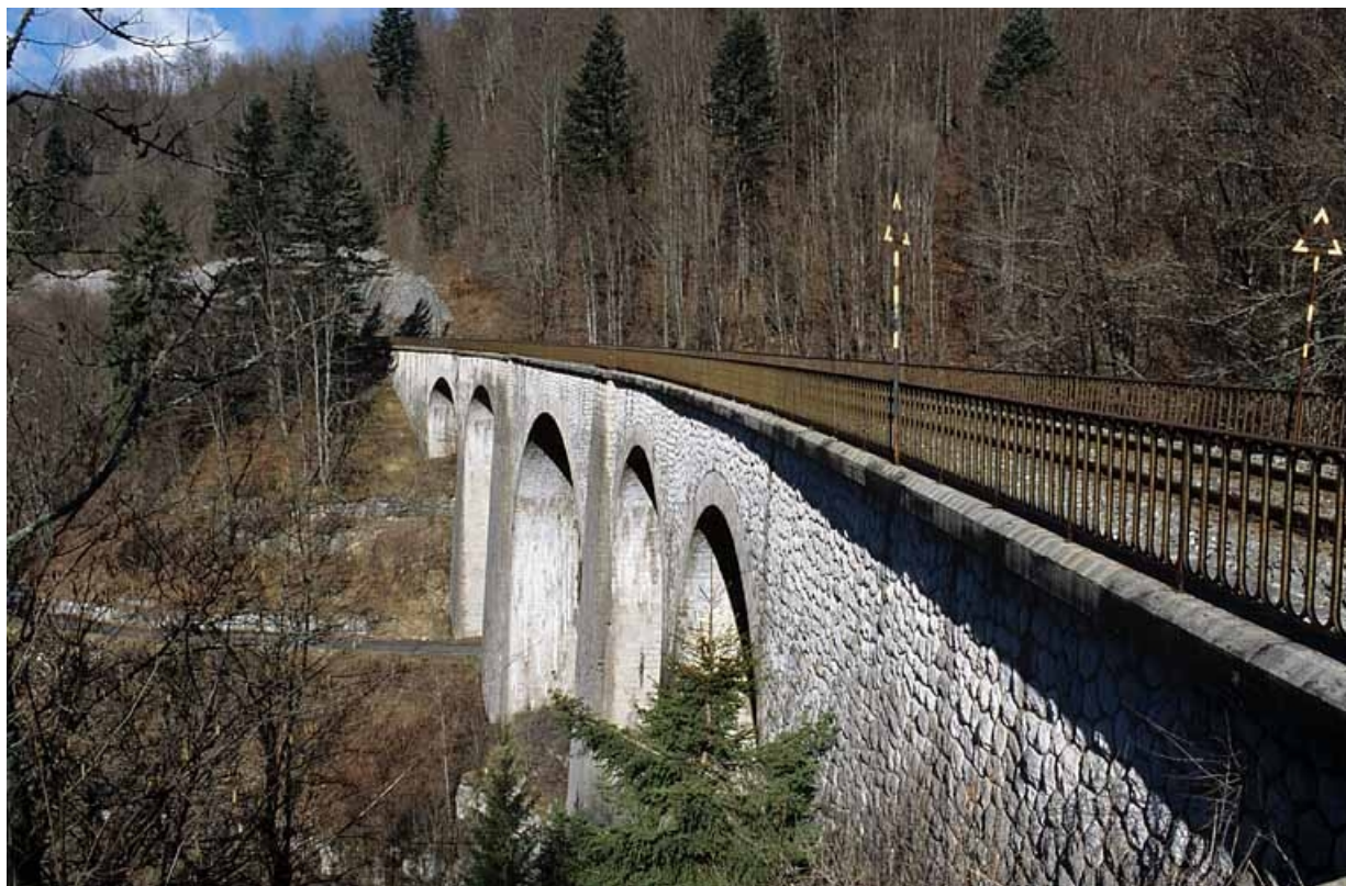
Vue d'ensemble en enfilade, depuis le côté Andelot-en-Montagne (est).
