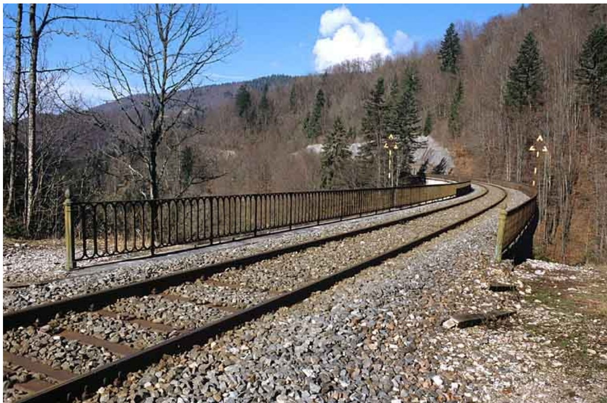
Tablier et garde-corps métallique, vus depuis le côté Andelot-en-Montagne (est).
