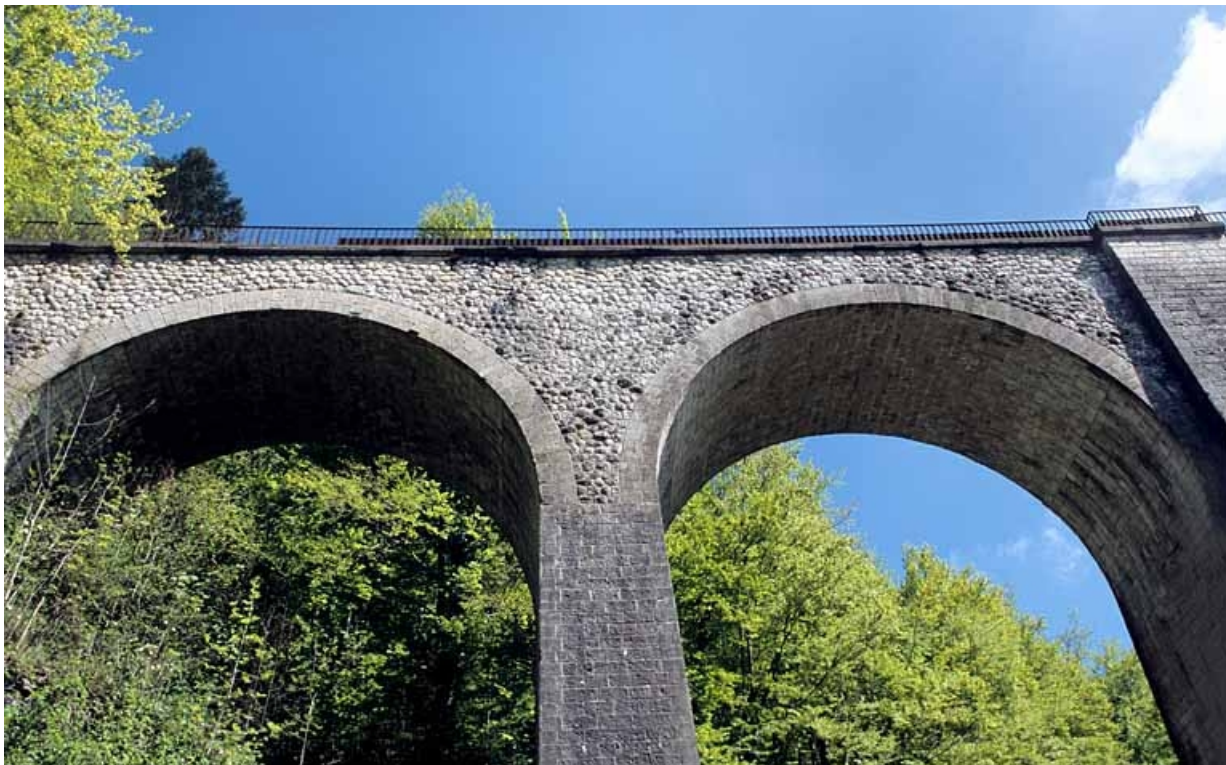
Deux arches du côté La Cluse, vues en contre-plongée.
