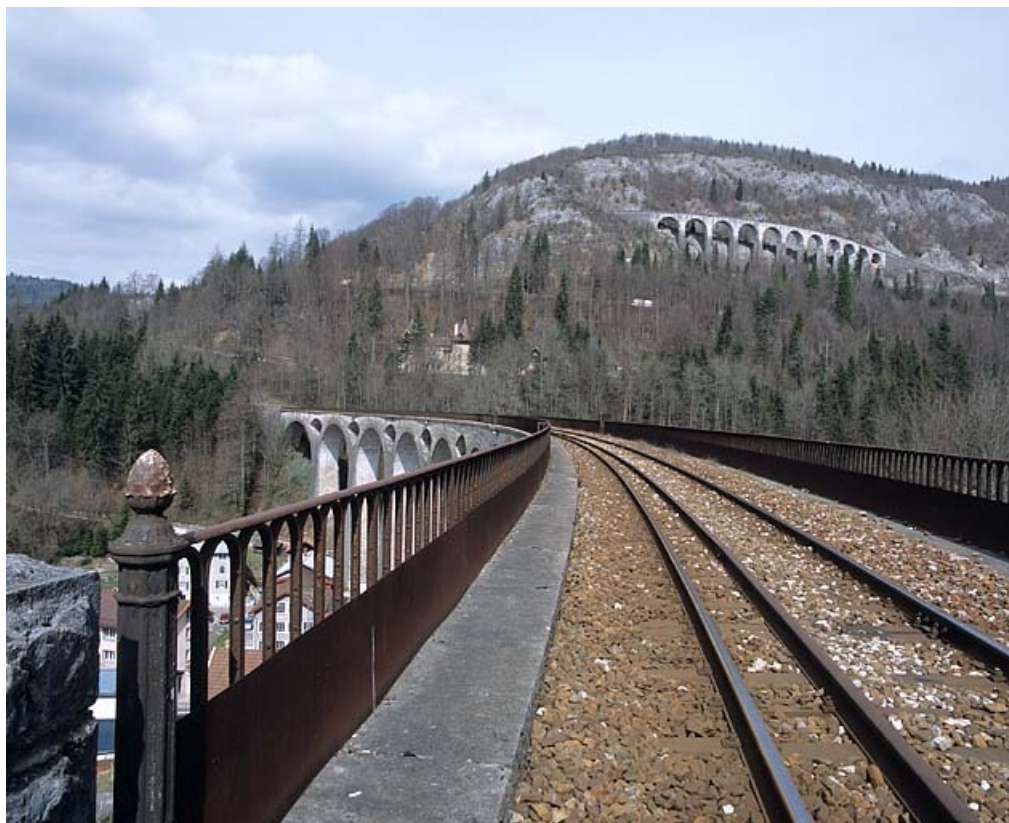
Tablier et garde-corps métallique côté Andelot-en-Montagne.
