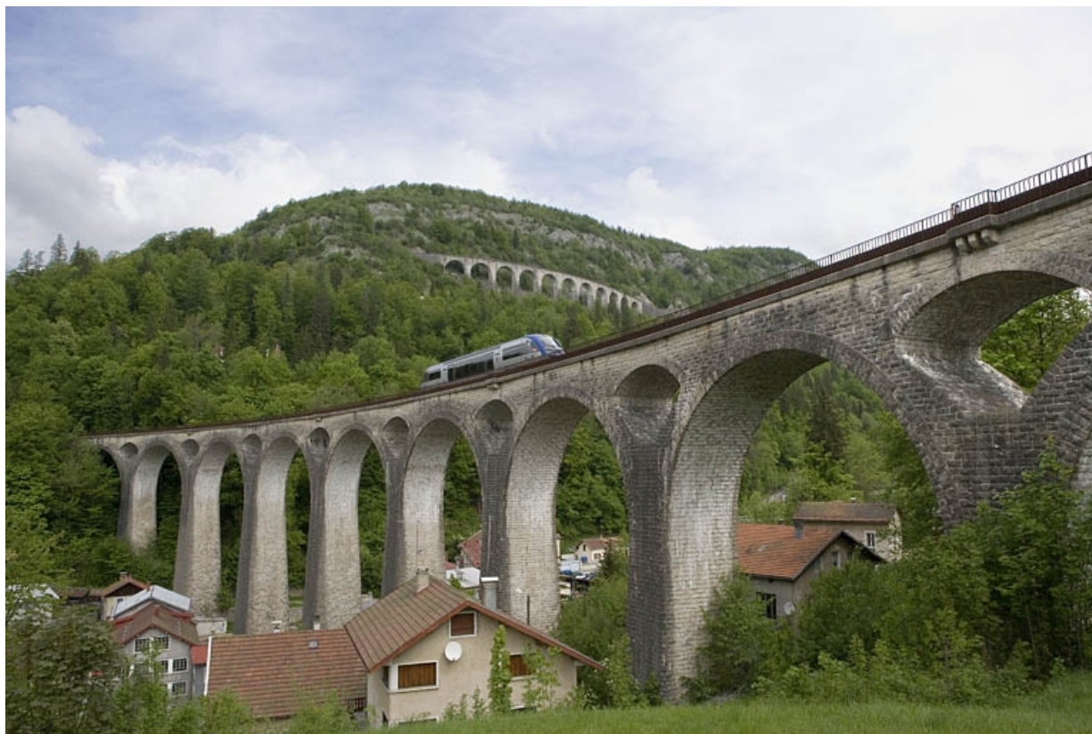
Vue d'ensemble, depuis le sud, avec un autorail X 73500. 39, Morez rue de la République
