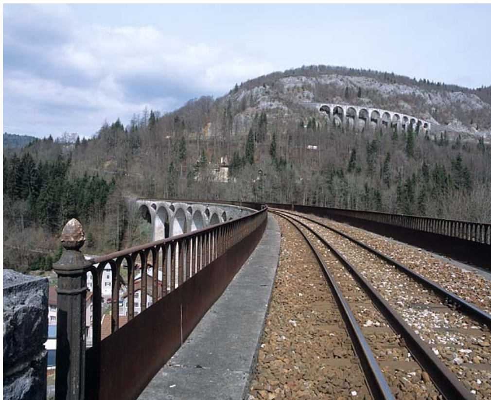
Tablier et garde-corps métallique côté Andelot-en-Montagne.
