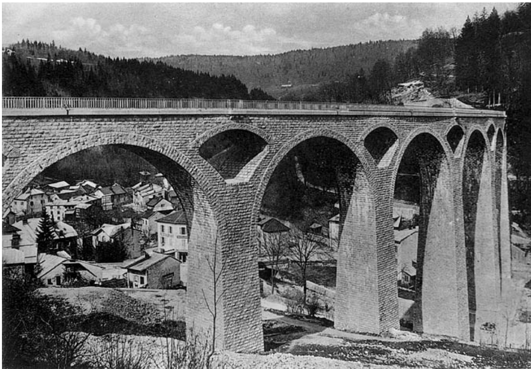
5. — VIADUC DE MOREZ.
