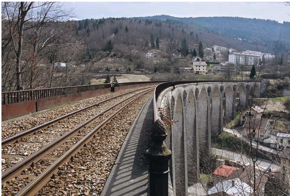
Tablier et élévation sud vus en enfilade, depuis l'ouest.
