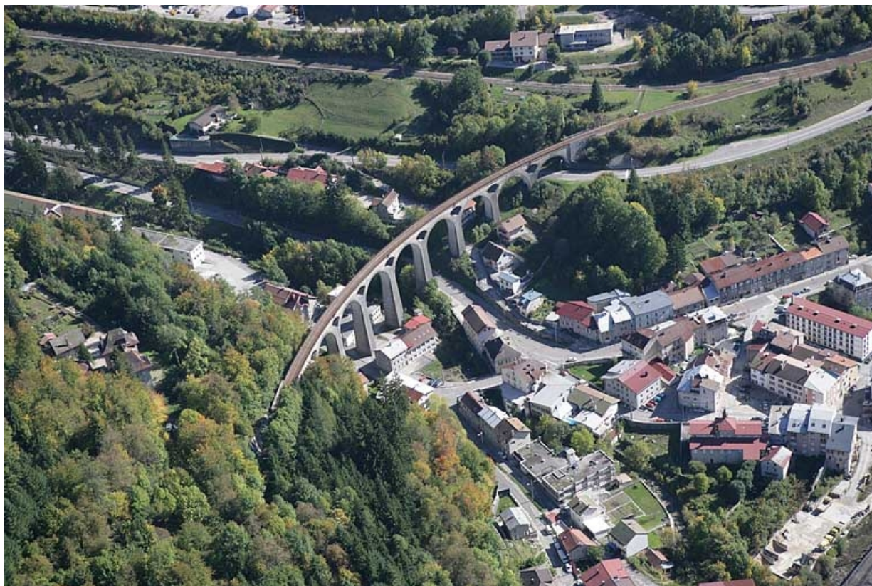
Vue aérienne rapprochée, depuis l'ouest.
