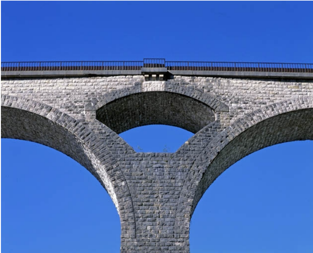
Pile avec voûte d'élégissement et refuge.
