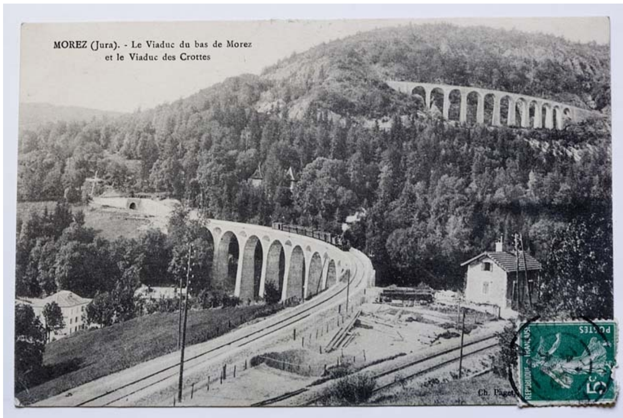
Morez (Jura). - Le Viaduc du bas de Morez et le Viaduc des Crottes, 1912-1913.
