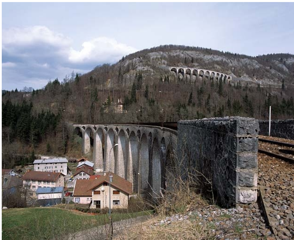
Parapet sud de la culée côté Andelot-en-Montagne.
