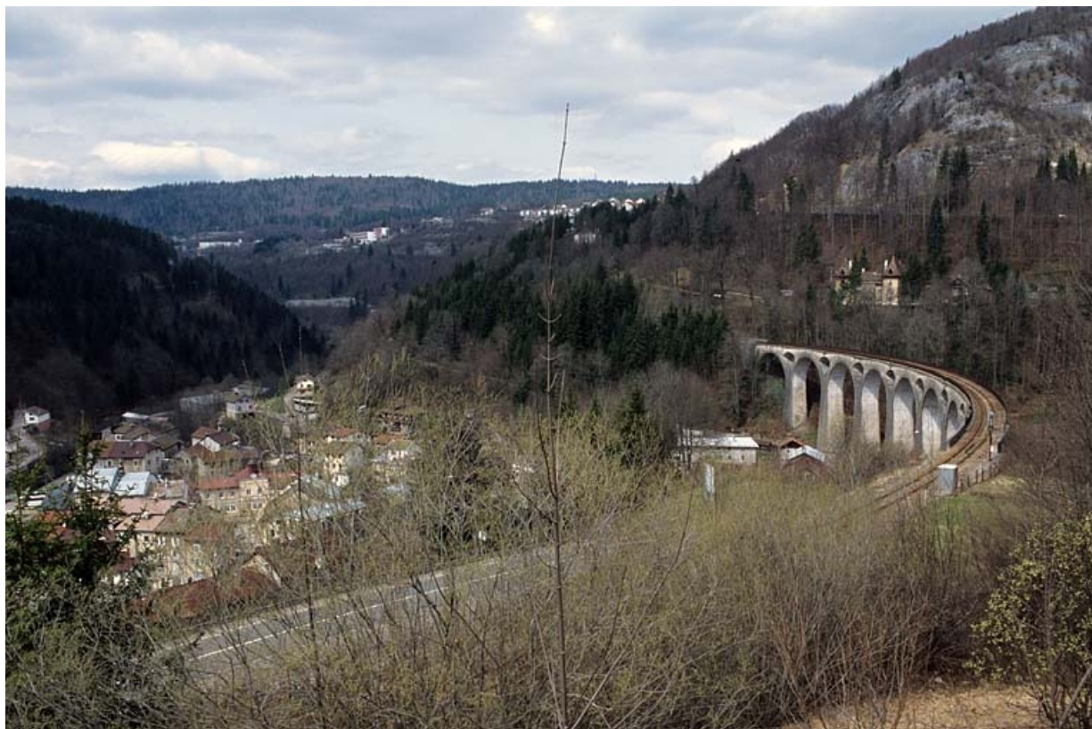
Vue d'ensemble du viaduc et de la vallée de la Bienne, depuis l'est. 39, Morez rue de la République
