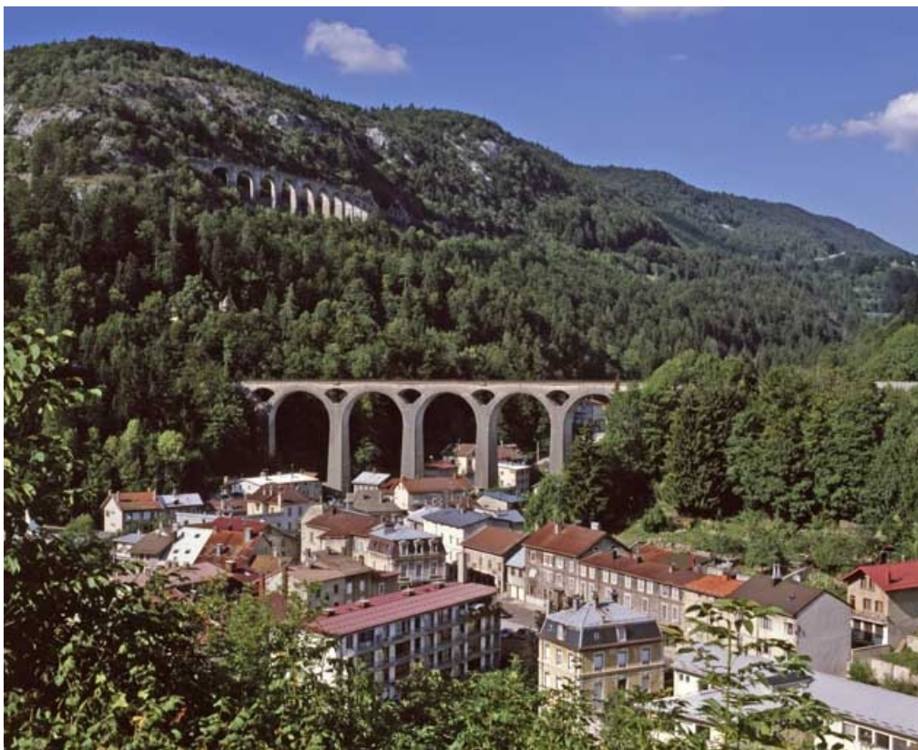
Vue d'ensemble depuis la route de Longchaumois, au sud-ouest.
