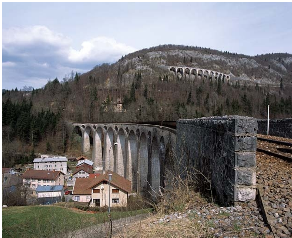
Parapet sud de la culée côté Andelot-en-Montagne.
