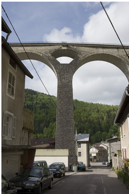
Une pile, vue de la rue Voltaire au nord-ouest. 39, Morez rue de la République
