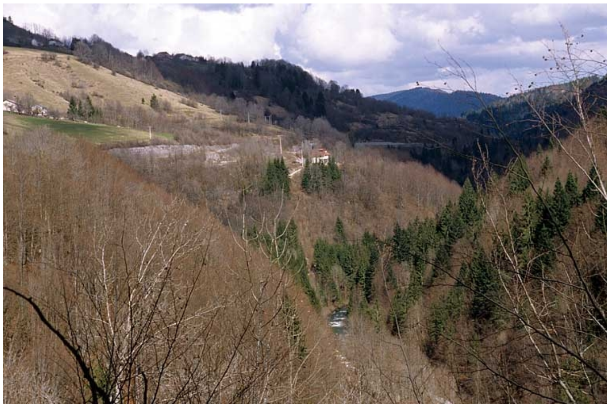
Voie ferrée dans la zone Tancua - Lézat : implantation dans la vallée de la Bienne (PK 052.000-058.000).
