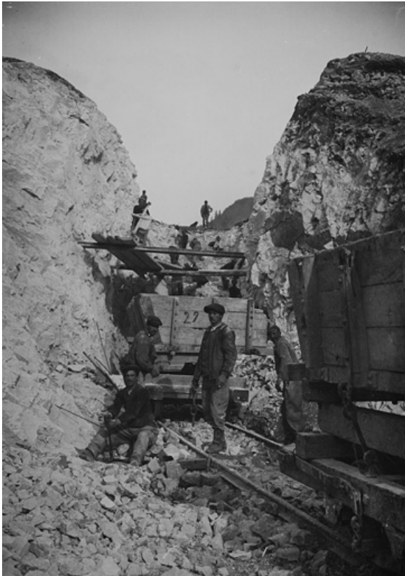
[Creusement d'une tranchée rocheuse vers le point kilométrique 071.700, en amont du tunnel de la Serre (commune de Saint-Claude)], vers 1910.
