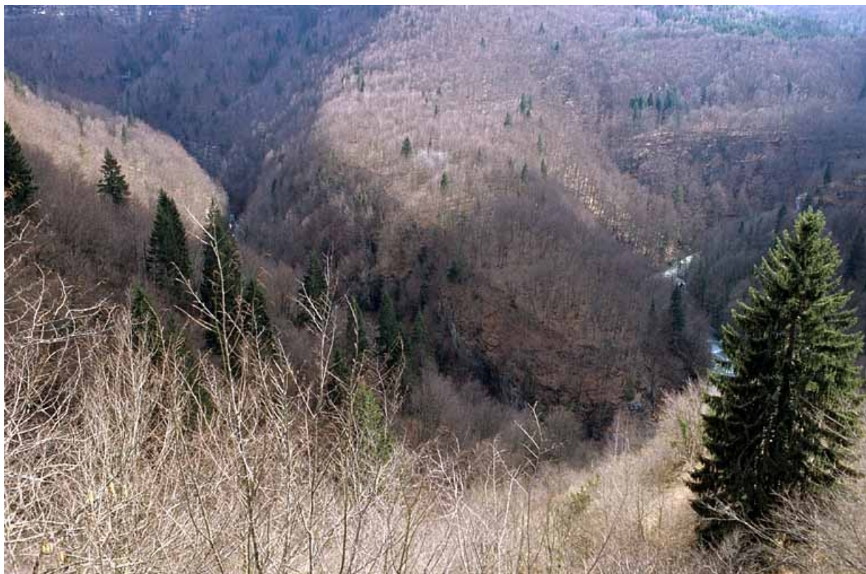
Voie ferrée dans la zone Tancua - Lézat : méandre de la Bienne en contrebas du tunnel de la Gouille aux Cerfs (vers le PK 057.000).
