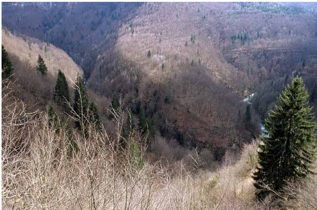
Voie ferrée dans la zone Tancua - Lézat : méandre de la Bienne en contrebas du tunnel de la Gouille aux Cerfs (vers le PK 057.000).
