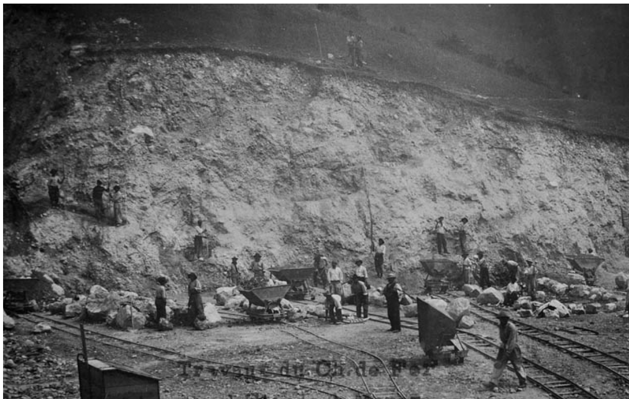
Travaux du Ch. de Fer de S. Claude à Morez [terrassment vers le point kilométrique 072.200 ?], vers 1910.
