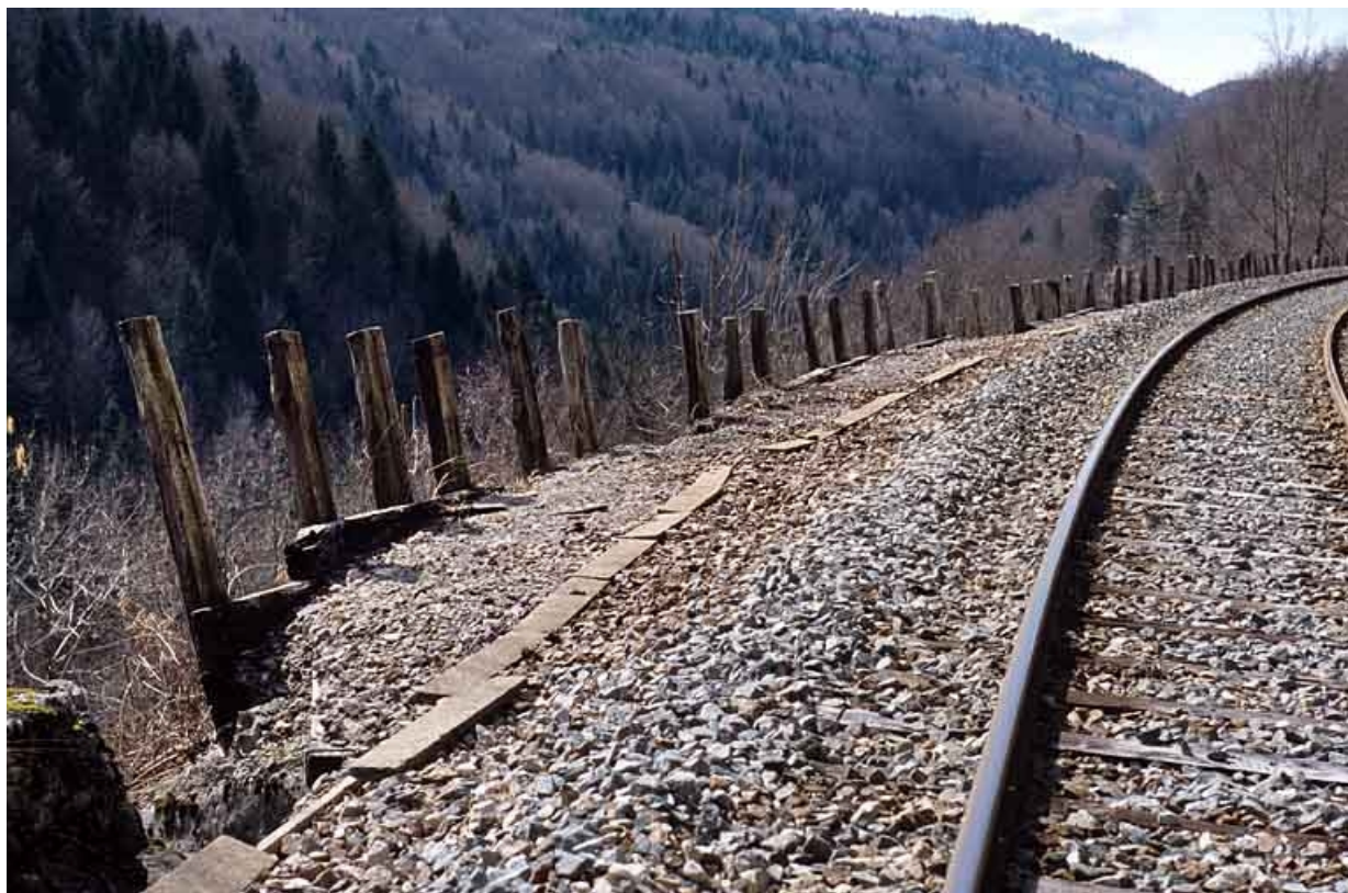
Traverses placées en soutènement de la voie côté La Cluse (sud), à la sortie du tunnel de Tancua (vers le PK 053.000).
