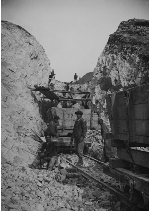
[Creusement d'une tranchée rocheuse vers le point kilométrique 071.700, en amont du tunnel de la Serre (commune de Saint-Claude)], vers 1910.
