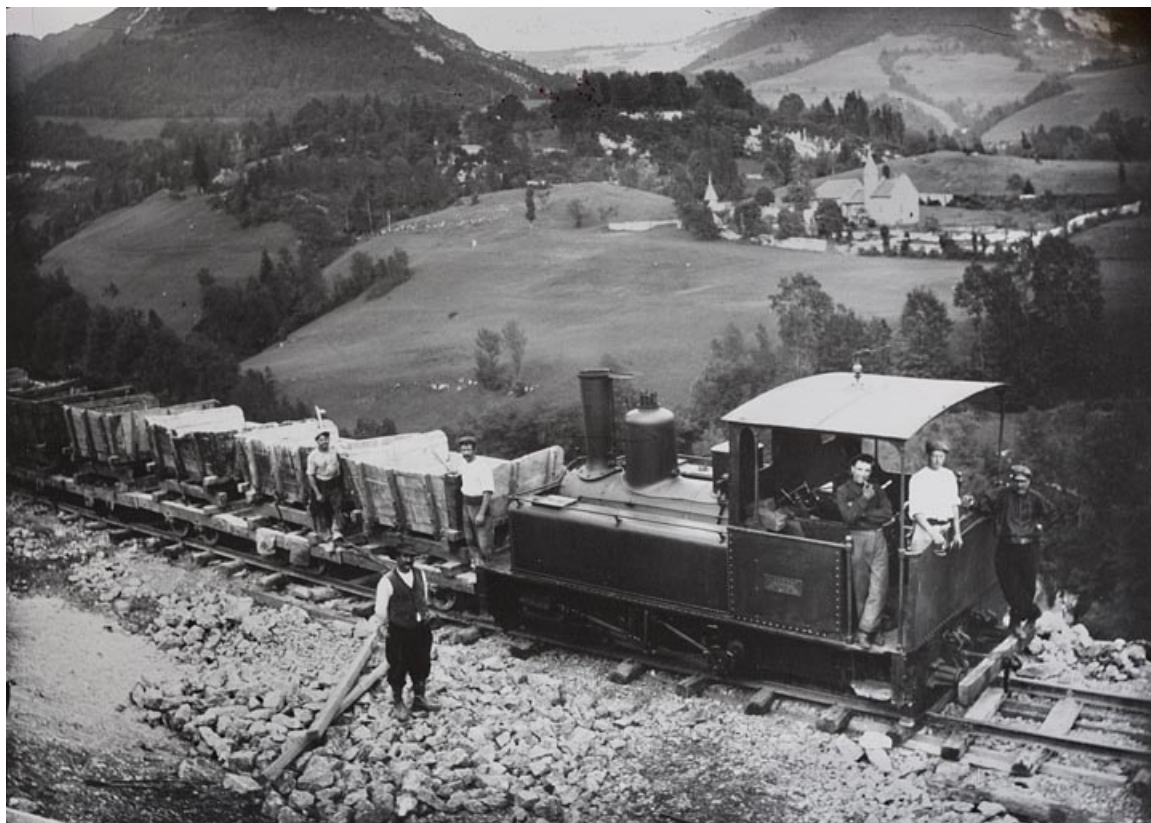
Construction de la ligne Saint-Claude - Morez vers 1910 [locomotive et wagons du chantier sur la commune de Saint-Claude, avec la Condamine en arrière-plan].
