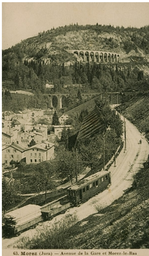
Morez (Jura) - Avenue de la Gare et Morez-le-Bas, 2e quart 20e siècle.
