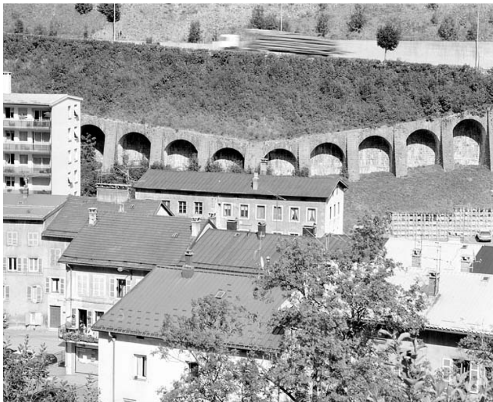
Mur à arcades, depuis l'ouest.
