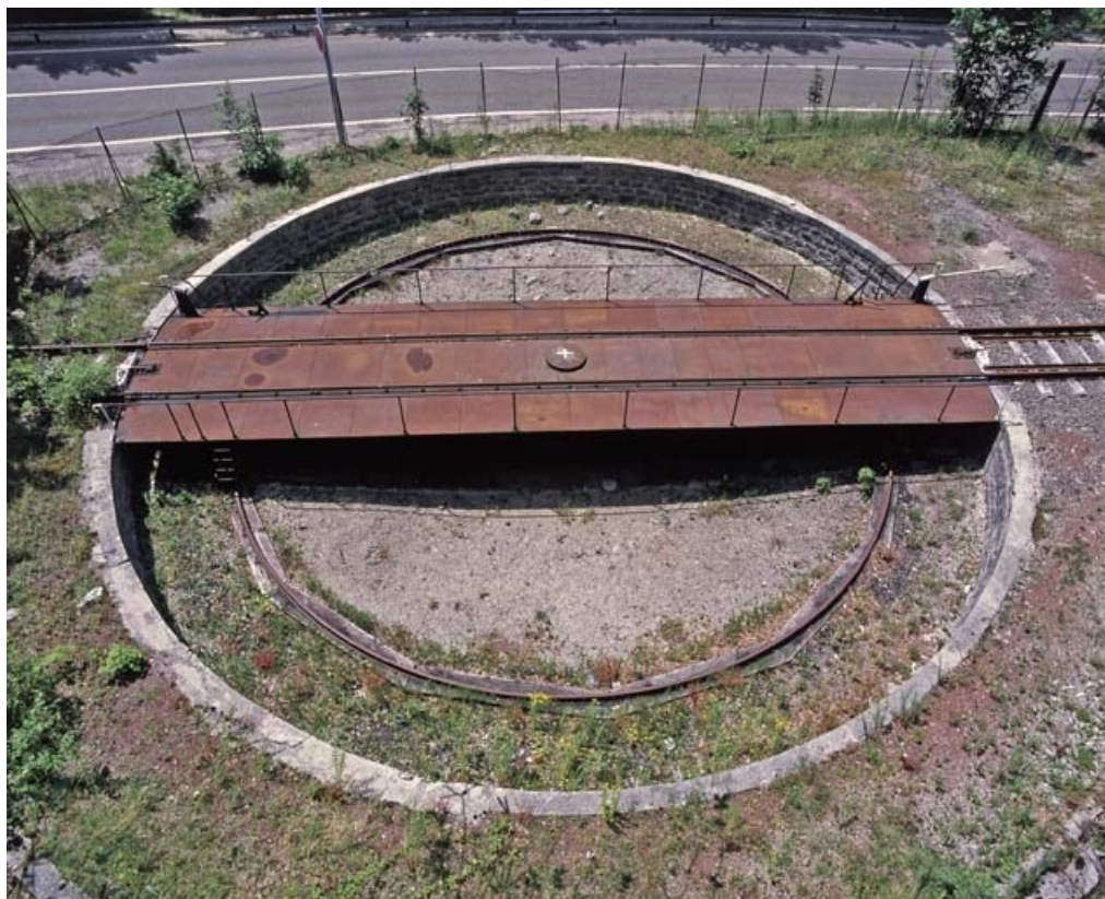
Vue d'ensemble plongeante, depuis l'est. 39, Morez, 15, 17 avenue Charles de Gaulle
