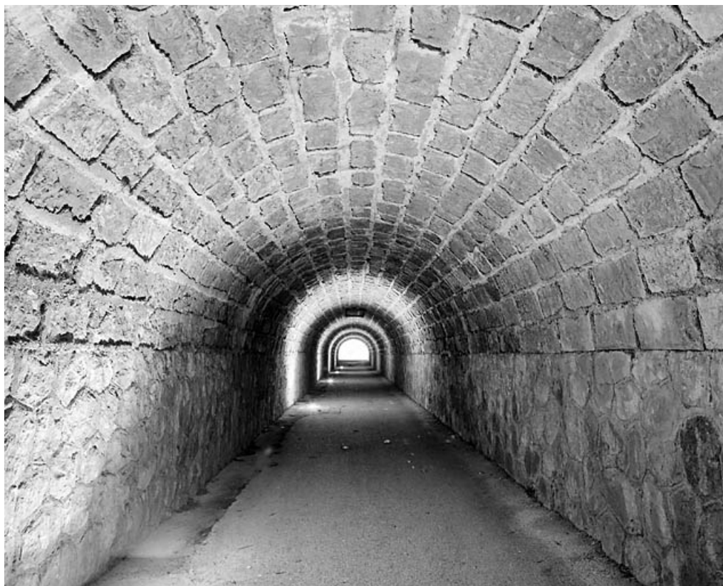
Passage souterrain (sous les voies) : intérieur.
