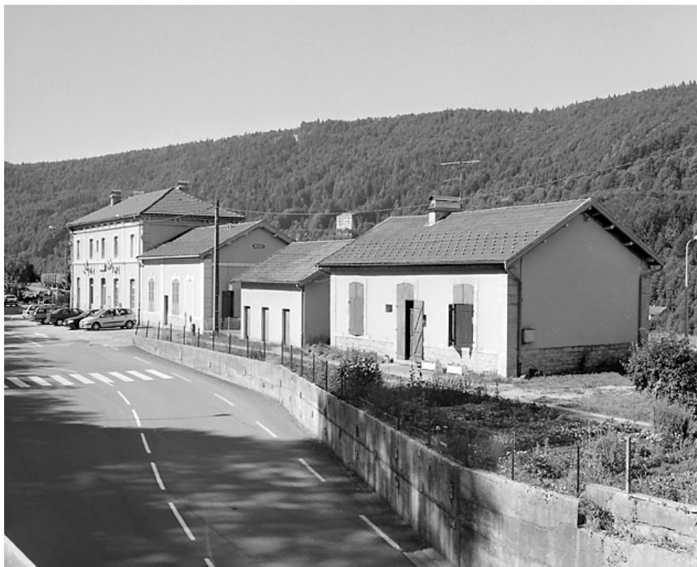
Bâtiment des voyageurs et logement, depuis le nord-est.
