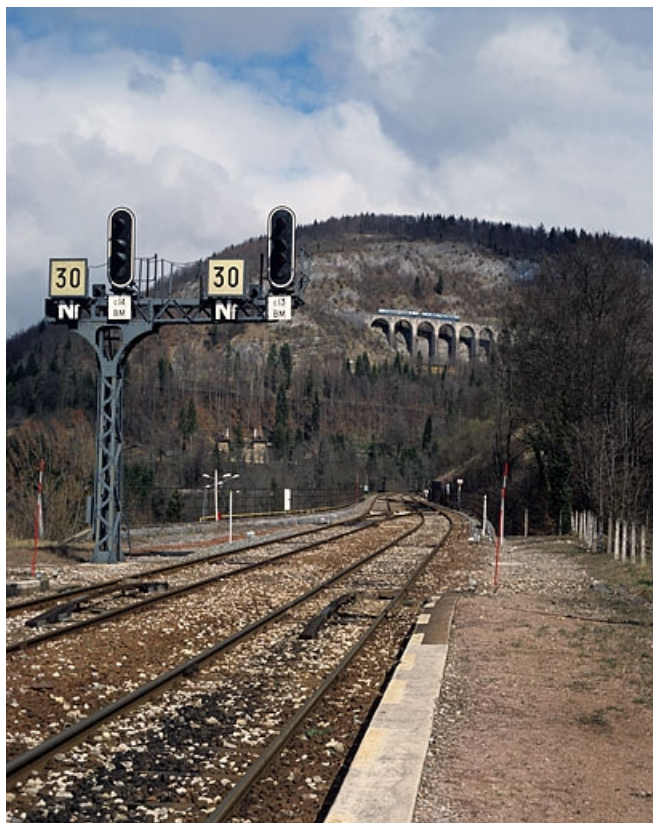
Voies à l'entrée de la gare, avec autorail X 2800 sur le viaduc des Crottes.
