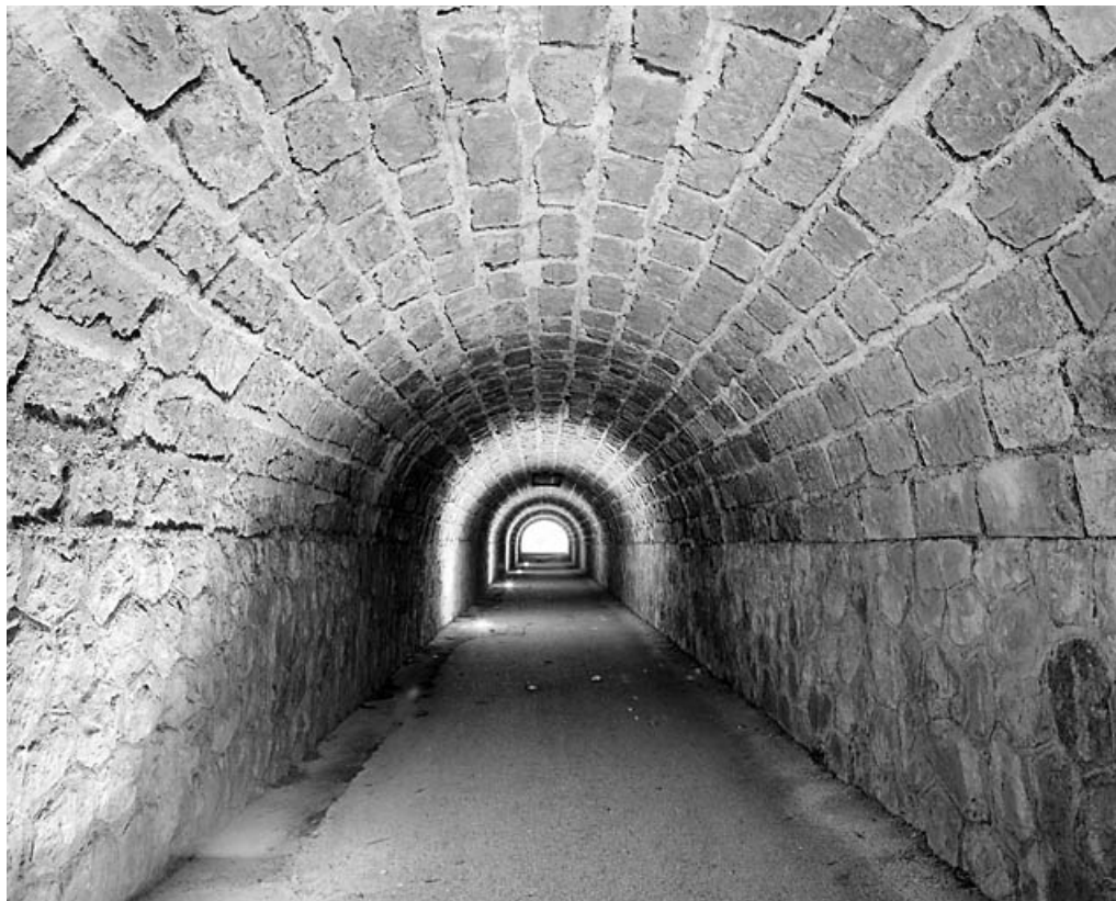
Passage souterrain (sous les voies) : intérieur.
