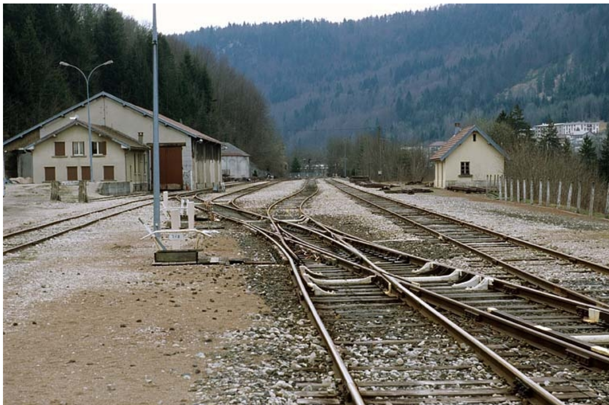
Vue d'ensemble de la gare des marchandises, depuis le nord.
