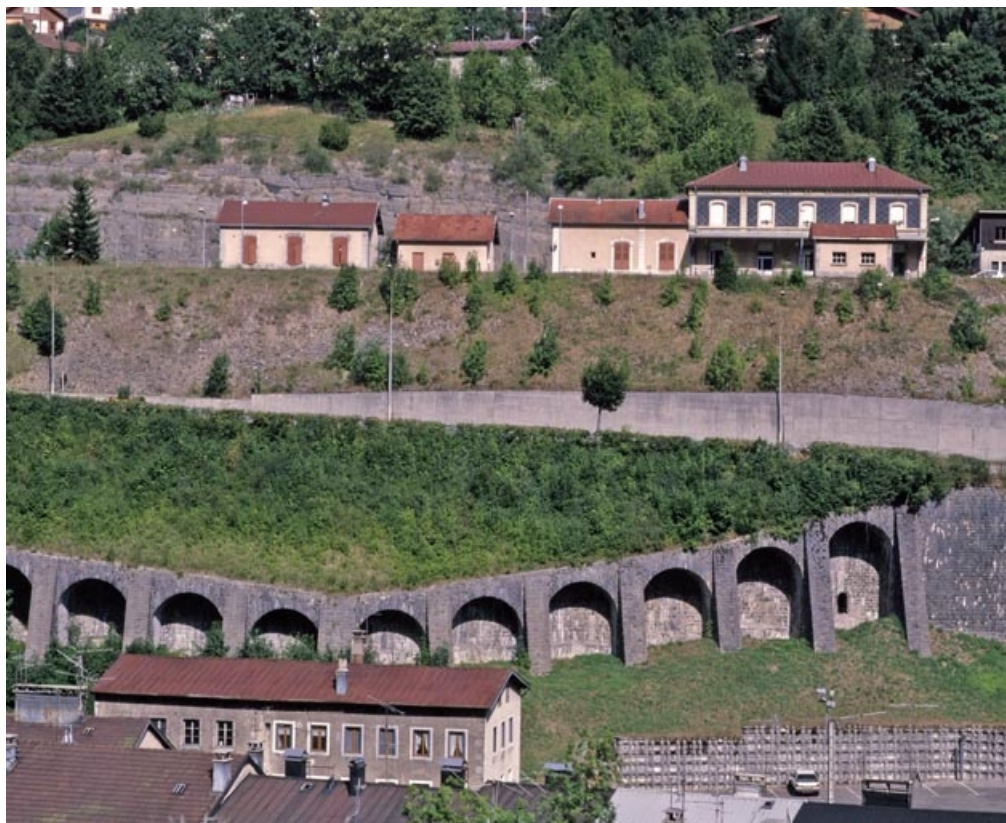
Bâtiment des voyageurs et logement, depuis l'ouest.
