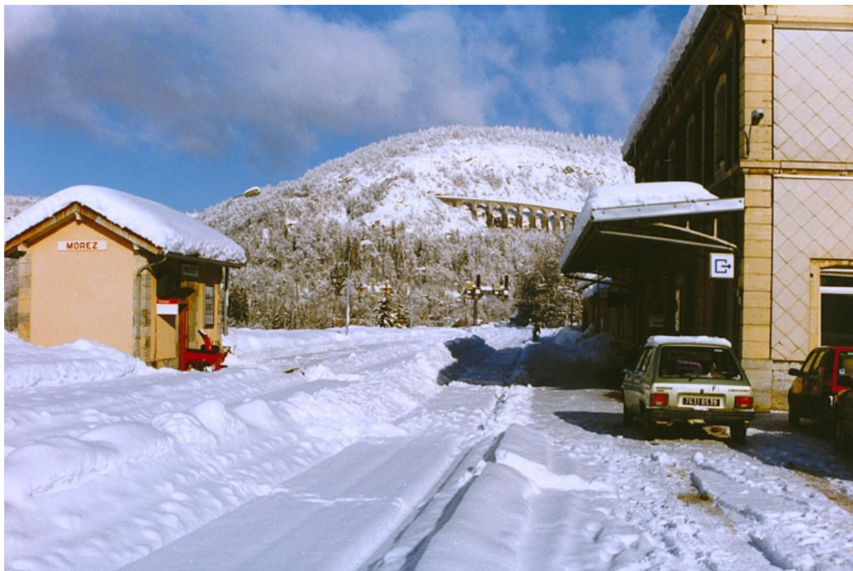
[La gare durant l'hiver 2000, côté bâtiment des voyageurs].
