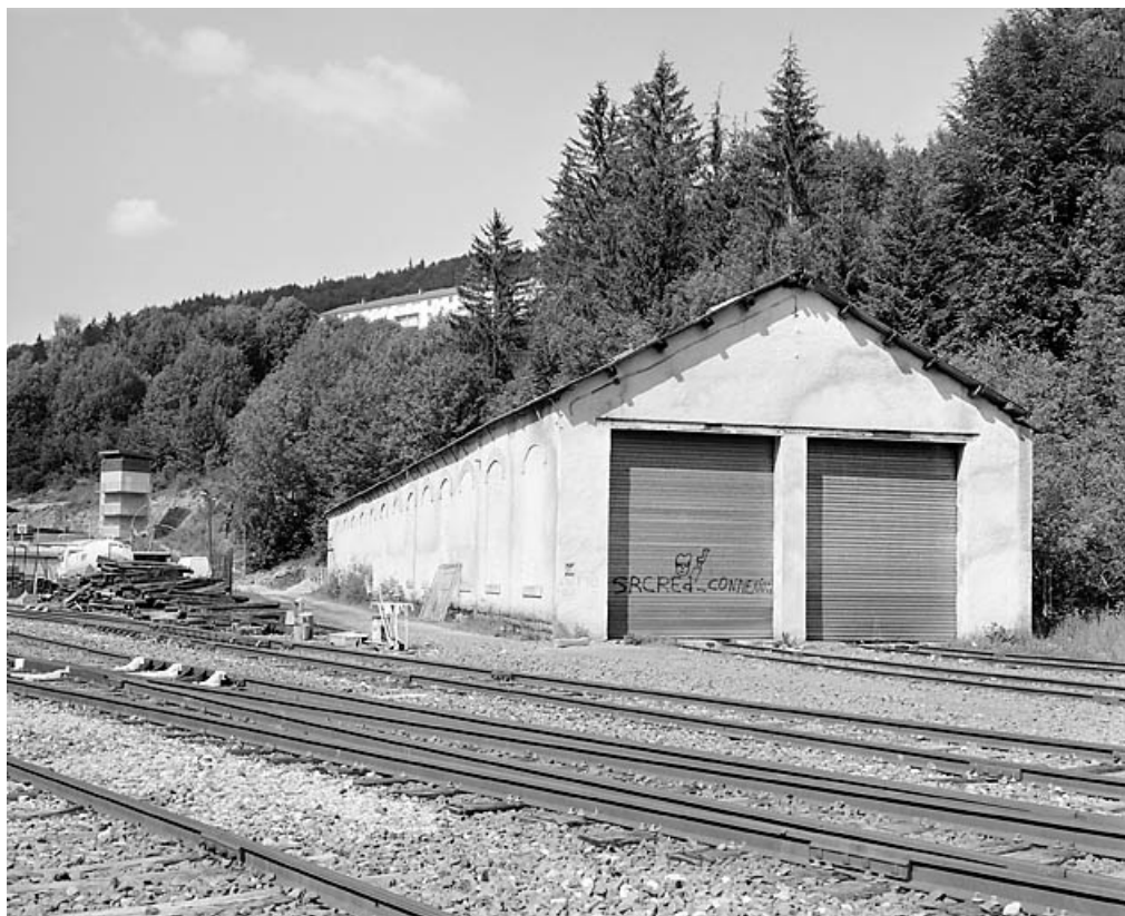
Remise ferroviaire, depuis le sud.
