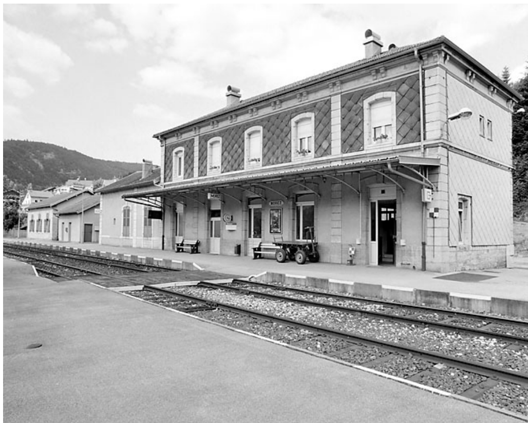
Bâtiment des voyageurs : façade postérieure, de trois quarts droite.
