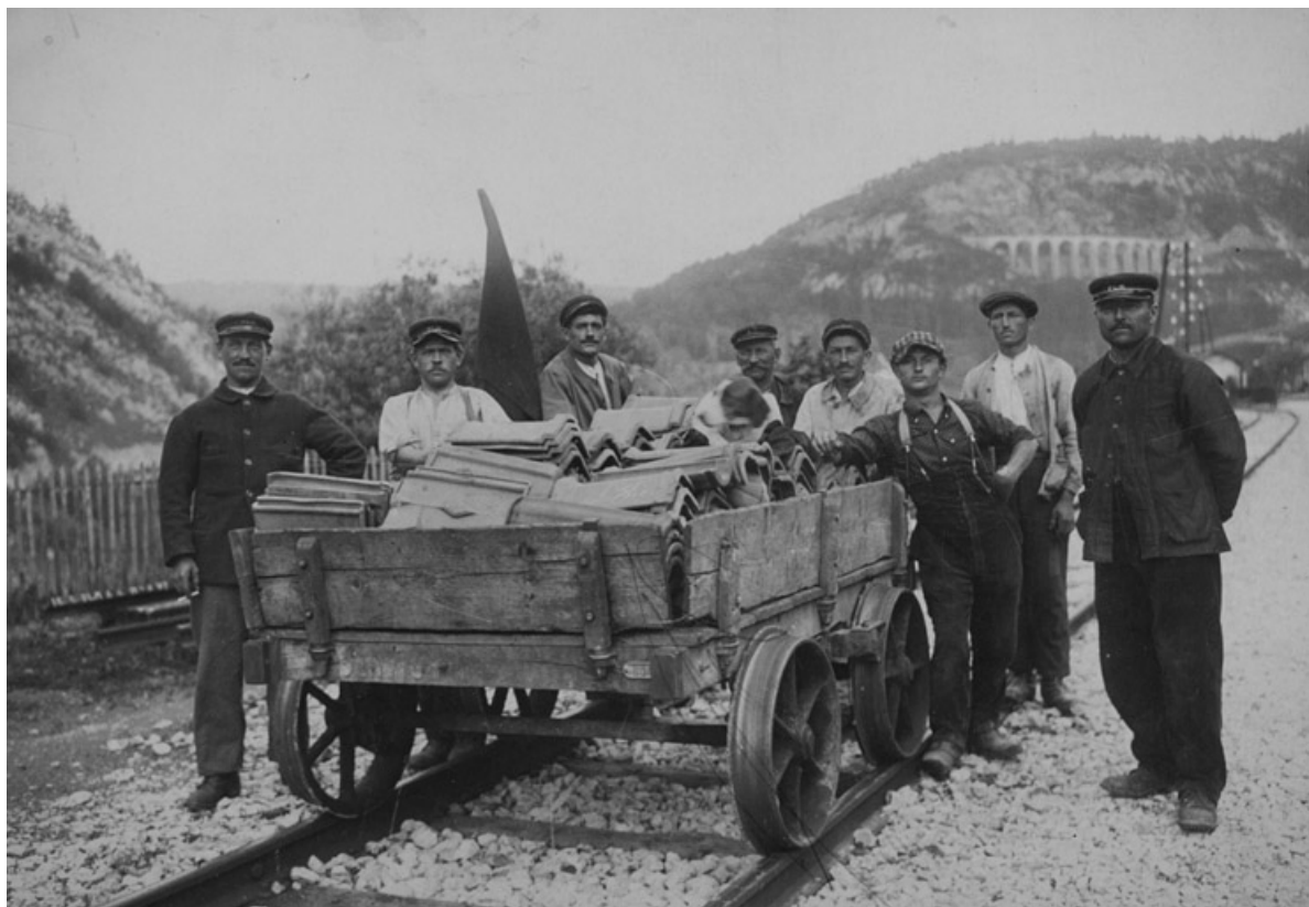
L'équipe d'entretien de la voie, sur la voie de service n° 6 de Morez, 1935.
