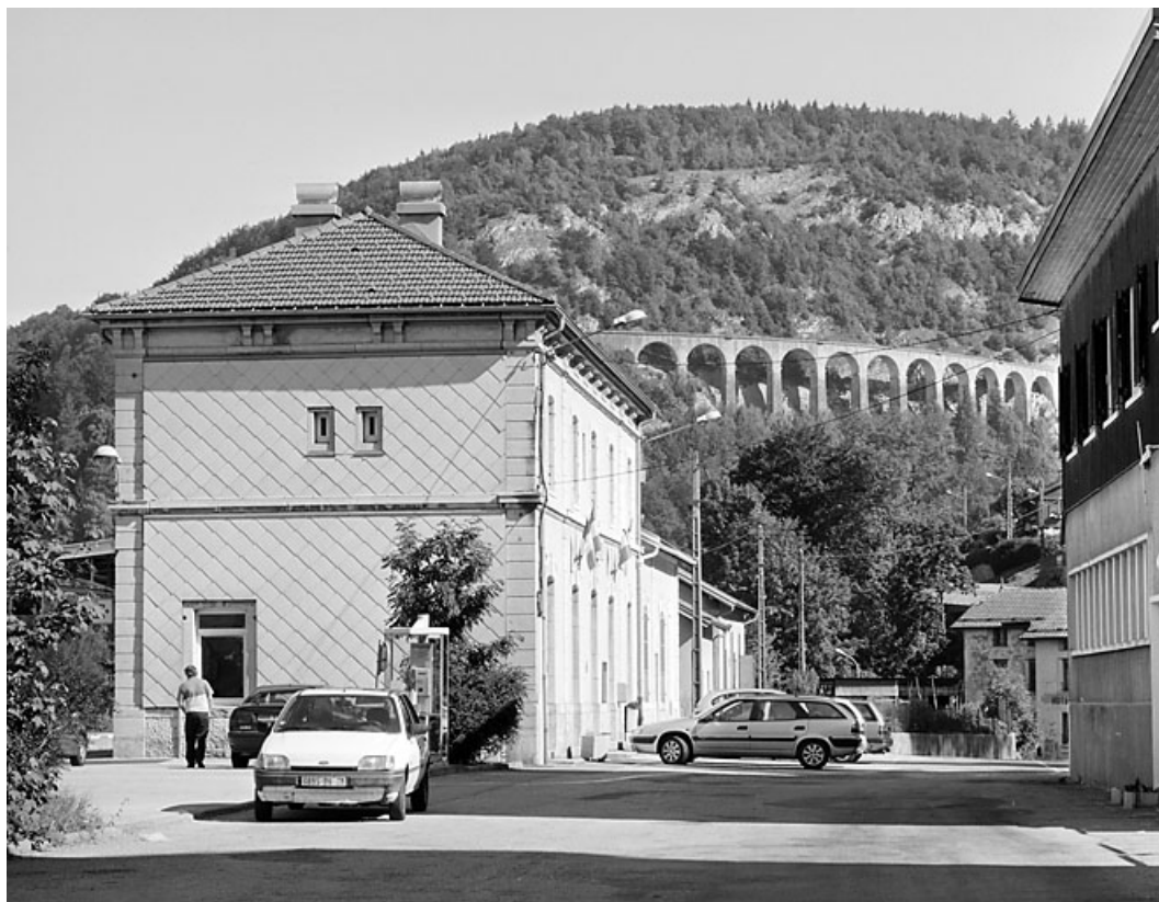
Bâtiment des voyageurs : façade latérale gauche.
