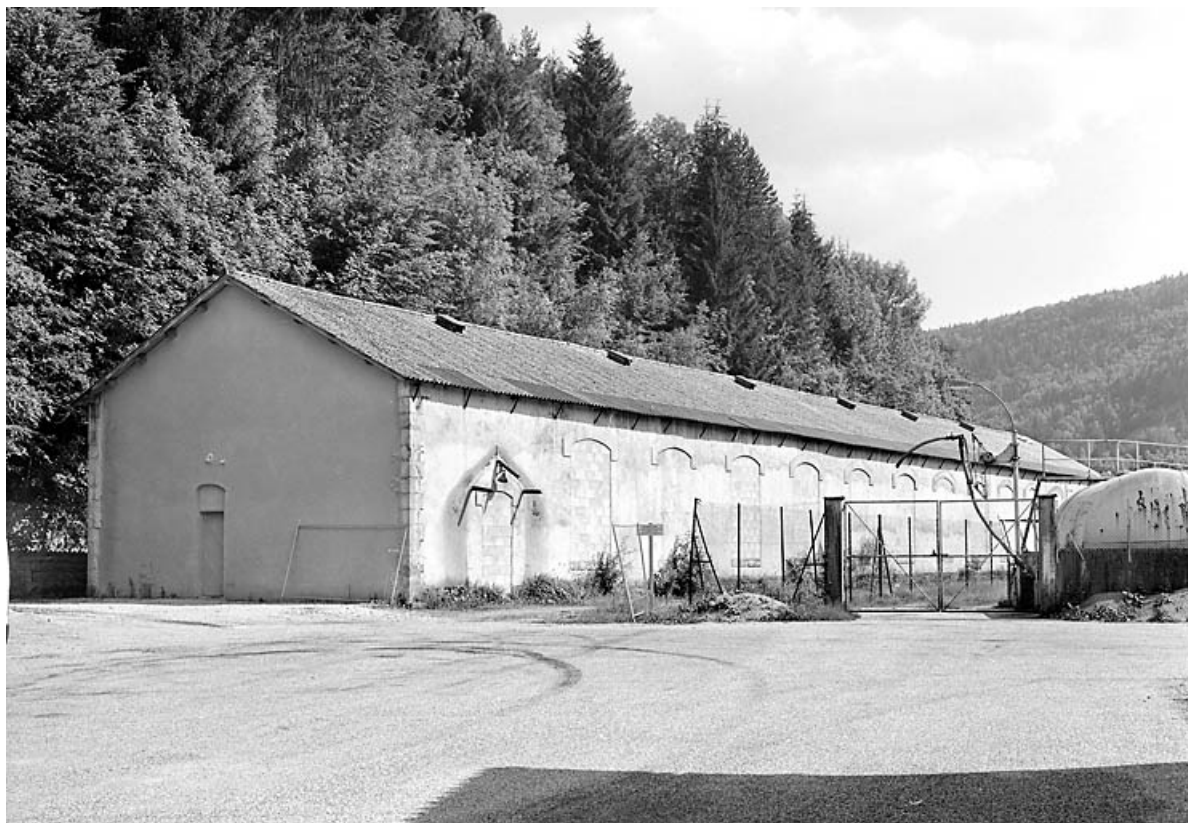
Remise ferroviaire, depuis le nord.
