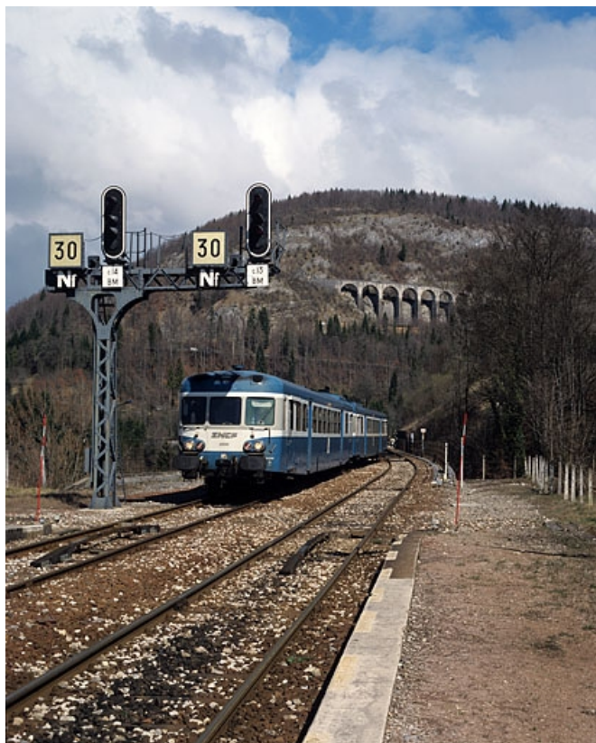
Voies à l'entrée de la gare, avec autorail X 2800 venant d'Andelot-en-Montagne.
