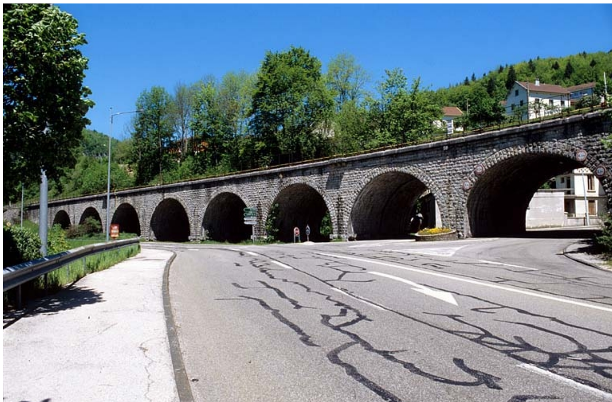
Élévation orientale, vue de trois quarts droite.
