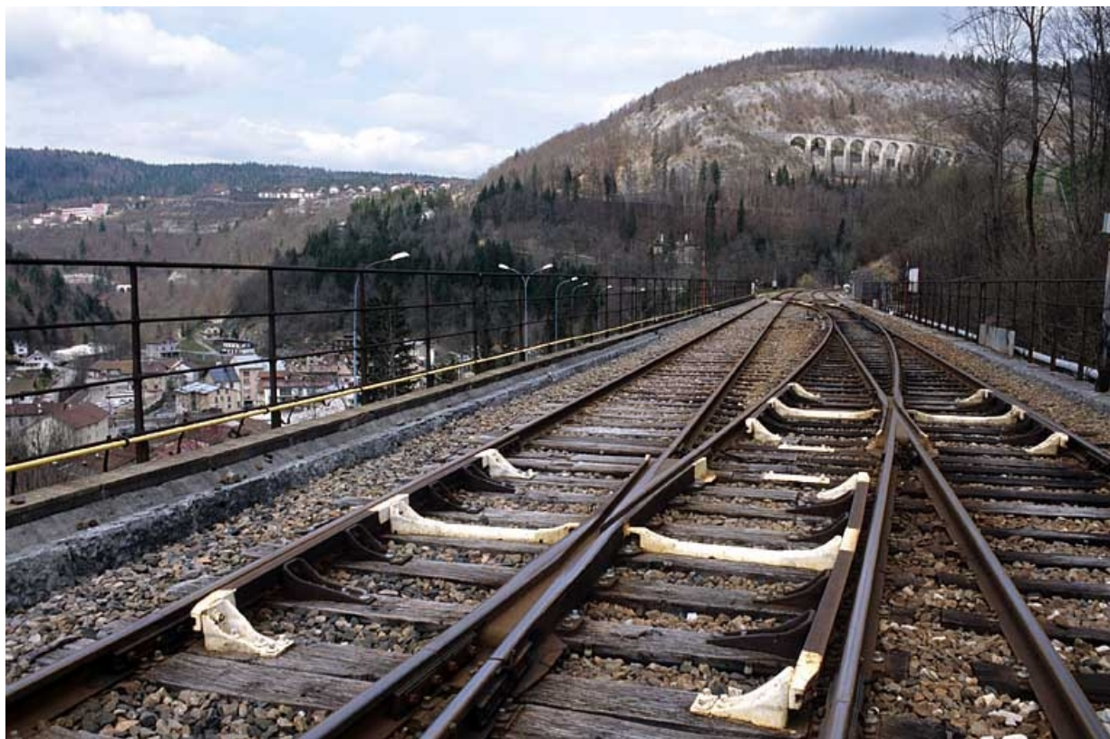
Vue d'ensemble du tablier, depuis la voie côté gare.
