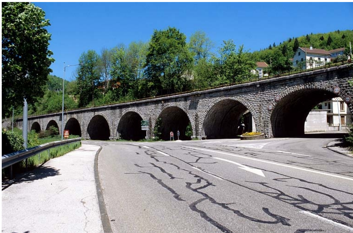
Élévation orientale, vue de trois quarts droite.
