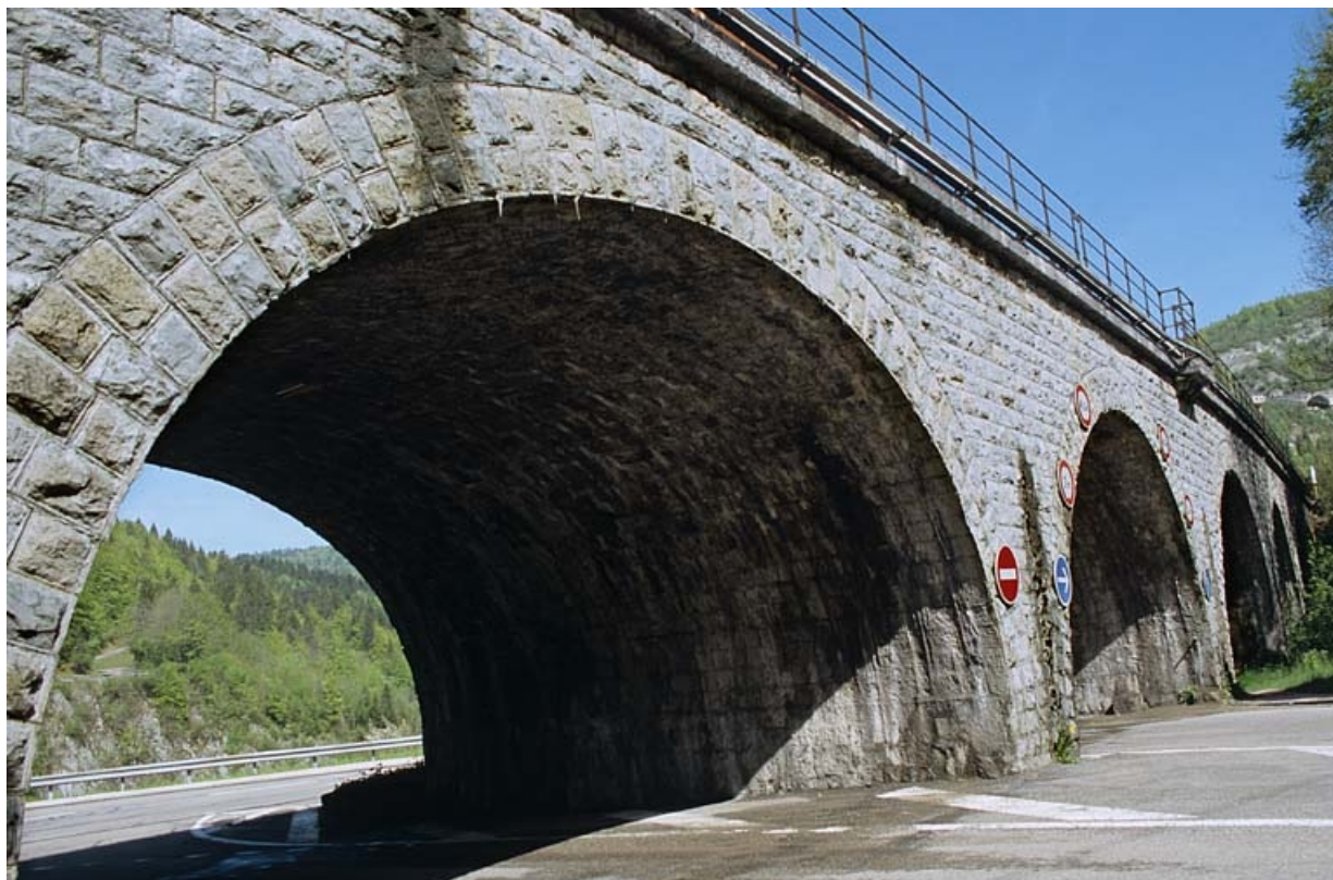
Élévation occidentale vue en enfilade, depuis le sud-est.
