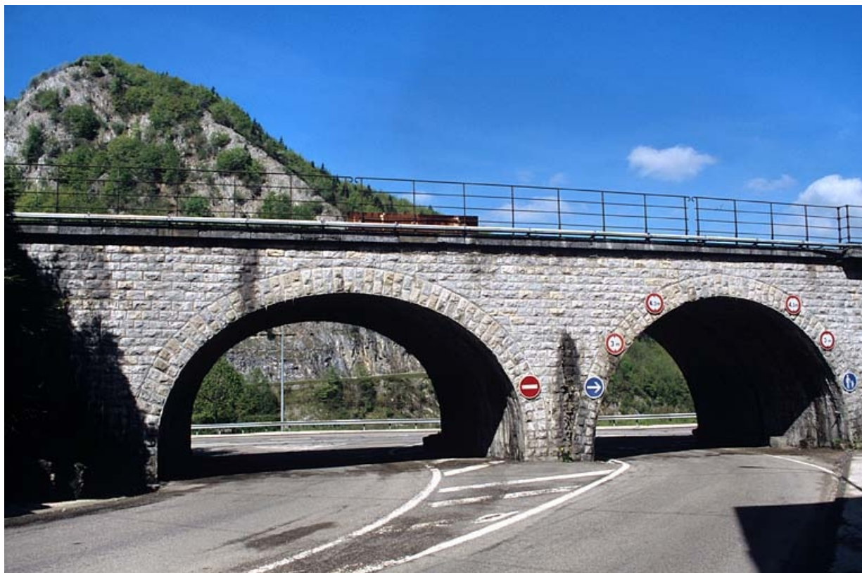
Élévation occidentale : arches enjambant la rue.
