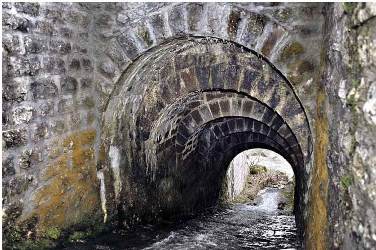
Pont : voûte appareillée en rouleaux à ressauts, depuis le nord (amont). 39, Bellefontaine, lieudit : Pâturage dessus l'Evalude
