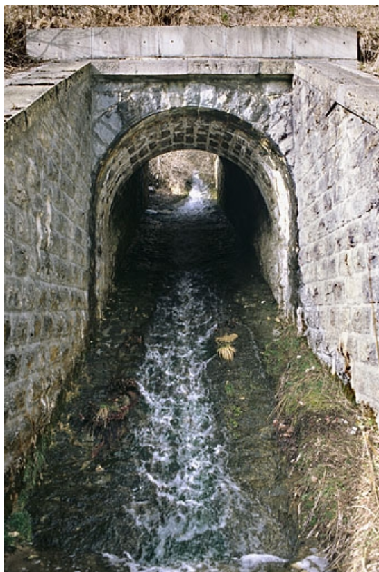
Pont : vue d'ensemble, depuis le sud (aval).
