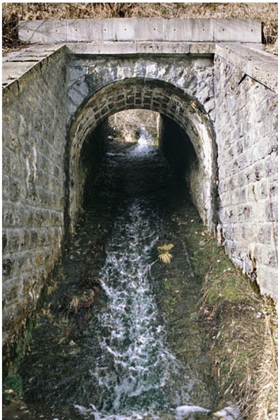
Pont : vue d'ensemble, depuis le sud (aval).
