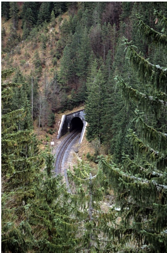
Vue d'ensemble plongeante sur la tête côté La Cluse.
