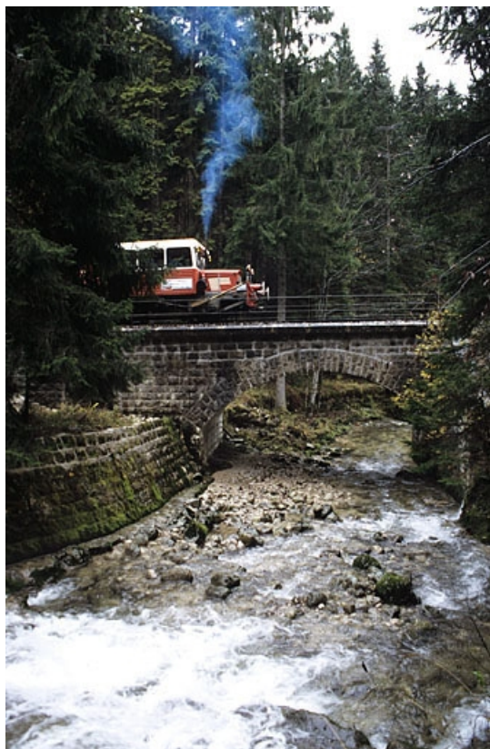
Élévation nord (amont), avec draisine.
