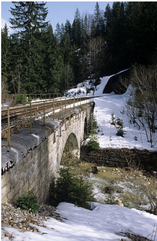
Vue d'ensemble, depuis le sud-ouest (aval).
