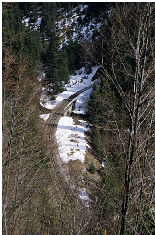
Vue d'ensemble plongeante, depuis le sud-ouest (côté Andelot-en-Montagne). 39, Bellefontaine, lieudit : le Caton
