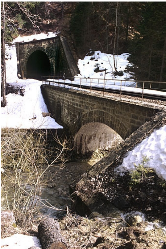
Vue d'ensemble, depuis le nord-ouest (amont).
