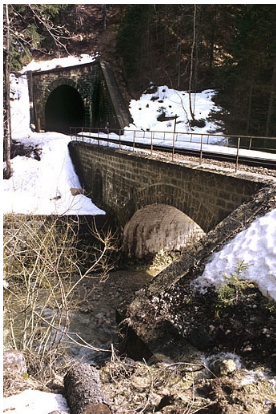
Vue d'ensemble, depuis le nord-ouest (amont).
