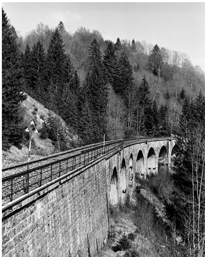
Élévation sud vue en enfilade, depuis le sud-ouest (côté Andelot-en-Montagne). 39, Bellefontaine, lieudit : le Bois des Crottes
