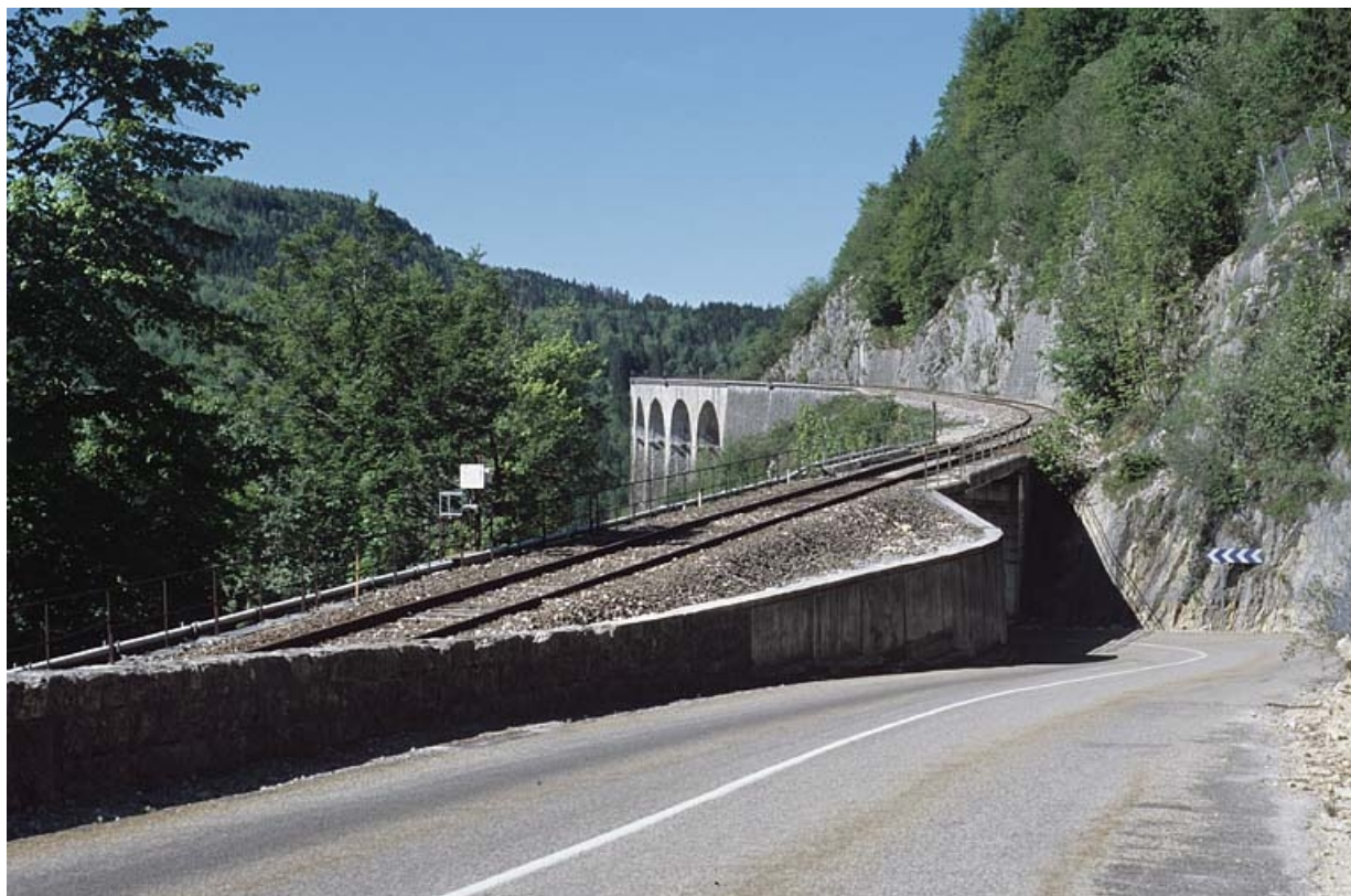
Vue d'ensemble depuis la route départementale n° 18, au nord-est.
