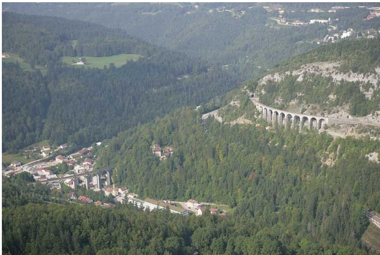
Vue aérienne du viaduc et du tunnel des Crottes, depuis l'est.
