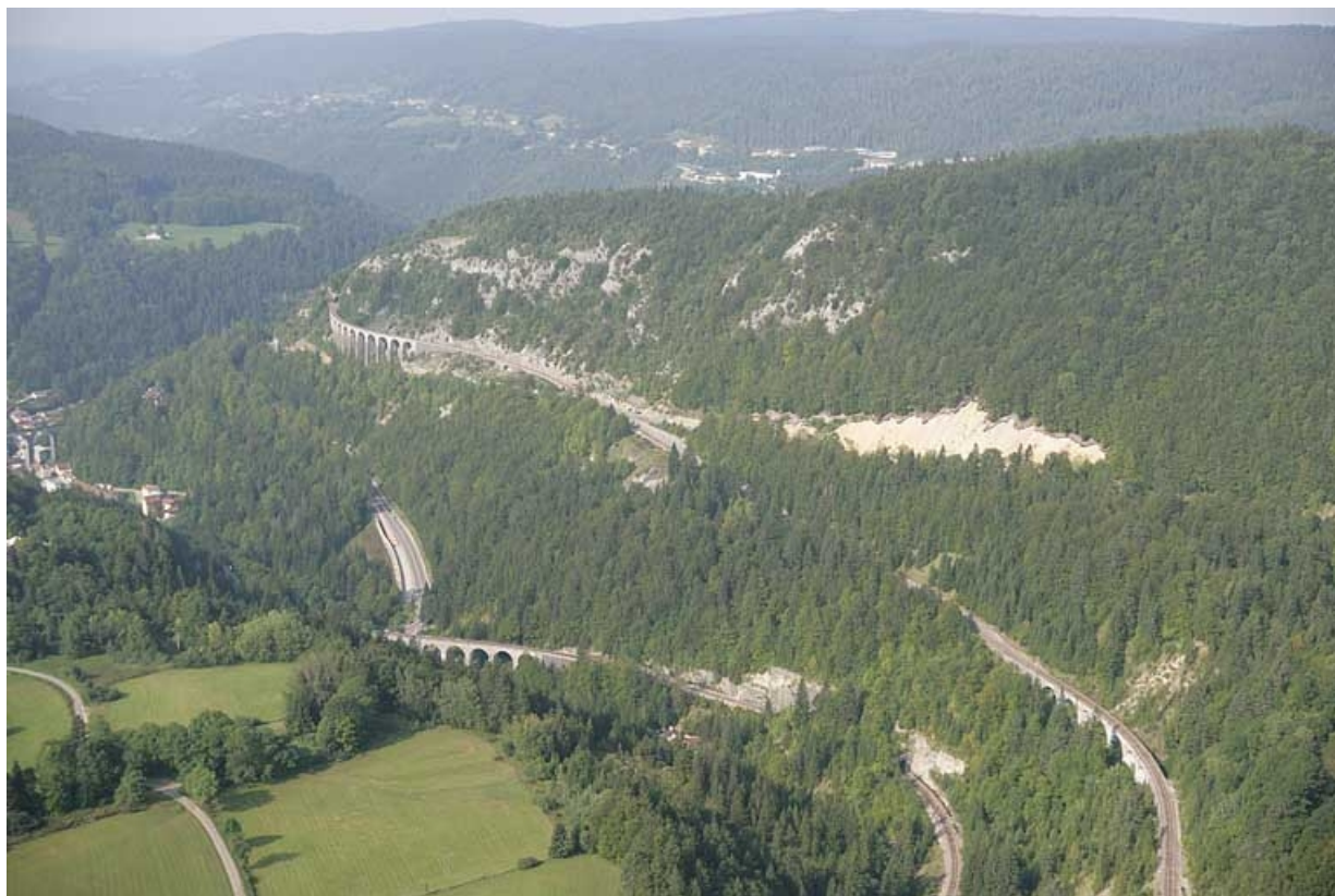
Vue aérienne du viaduc et des autres ouvrages d'art entre Morbier et Morez, depuis le nord-est.
