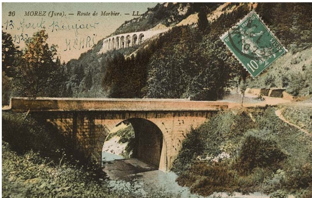
Morez (Jura). - Route de Morbier [viaduc des Crottes et pont routier sur l'Evalude], entre 1900 et 1922. 39, Morbier, lieudit : le Bois des Crottes
