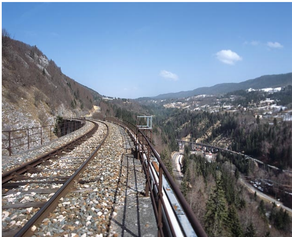
Vue d'ensemble du tablier et des garde-corps, depuis le côté Andelot-en-Montagne. 39, Morbier, lieudit : le Bois des Crottes
