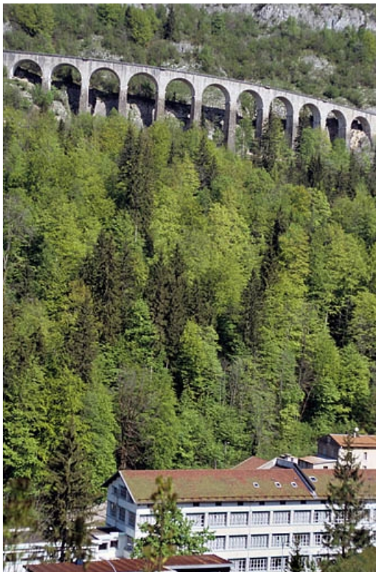
Élévation orientale, vue depuis Morez.
