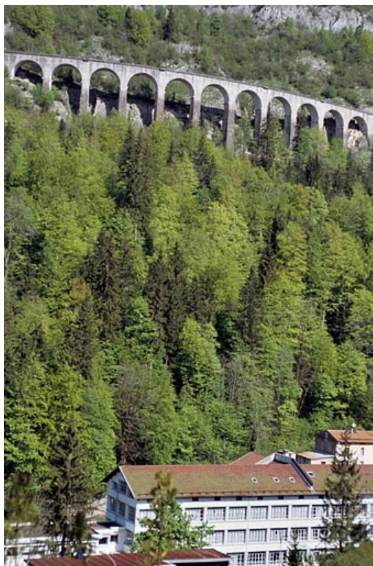
Élévation orientale, vue depuis Morez.
