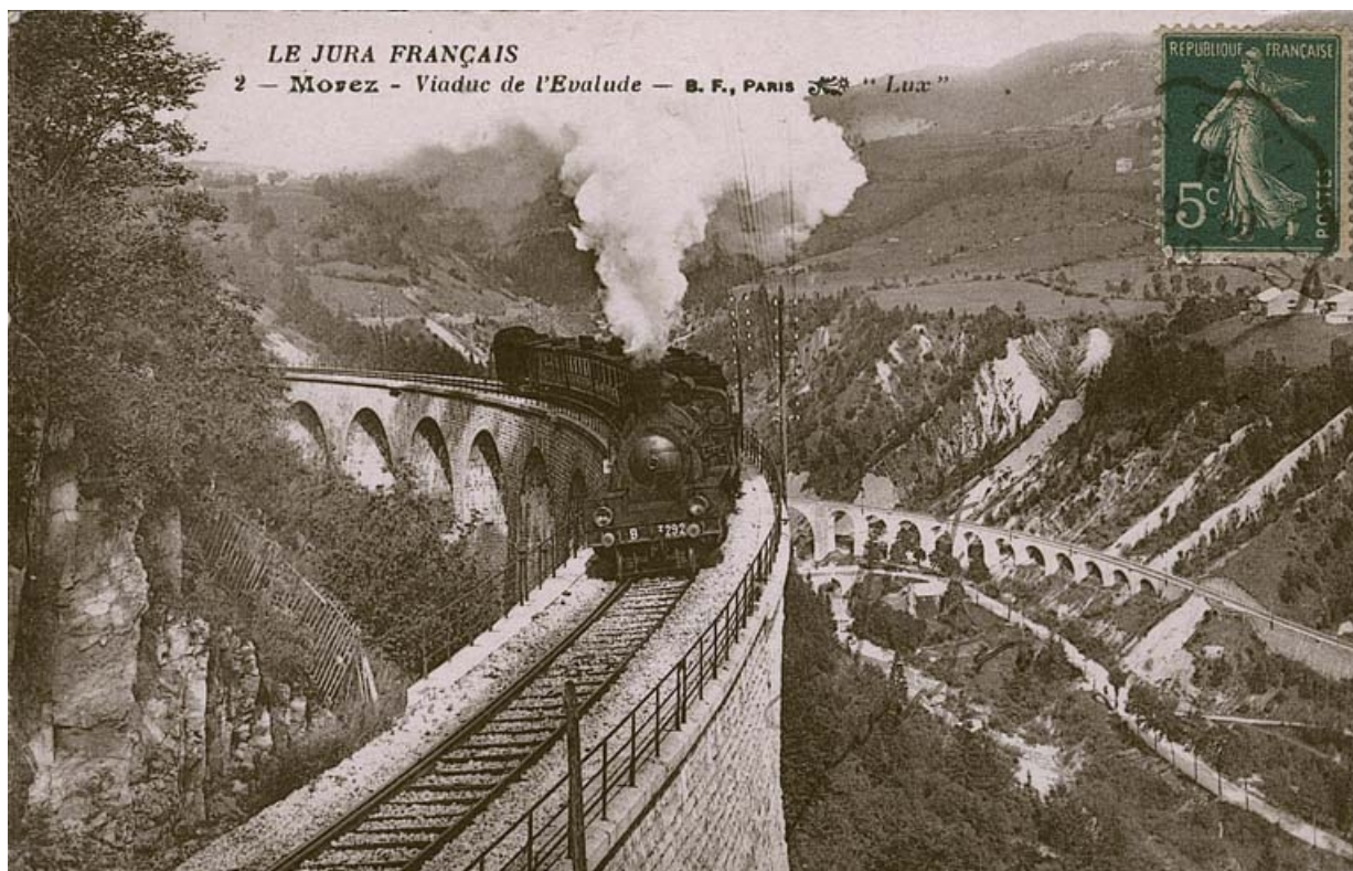
Morez - Viaduc de l'Evalude [locomotive à vapeur venant de Morez et franchissant le viaduc des Crottes], 1er quart 20e siècle. 39, Morbier, lieudit : le Bois des Crottes
