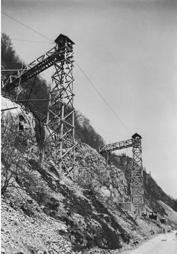
Travaux du chemin de fer : les pylônes pour la construction du viaduc des Crottes, 1899. 39, Morbier, lieudit : le Bois des Crottes
