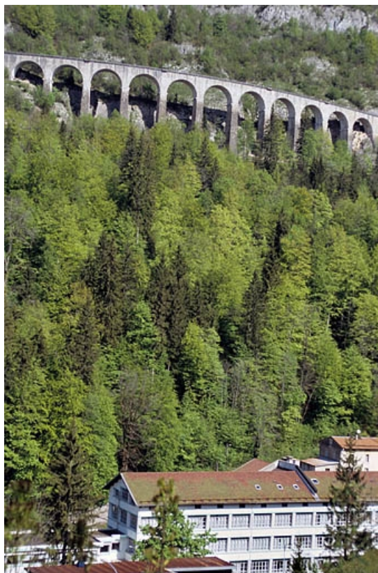
Élévation orientale, vue depuis Morez.
