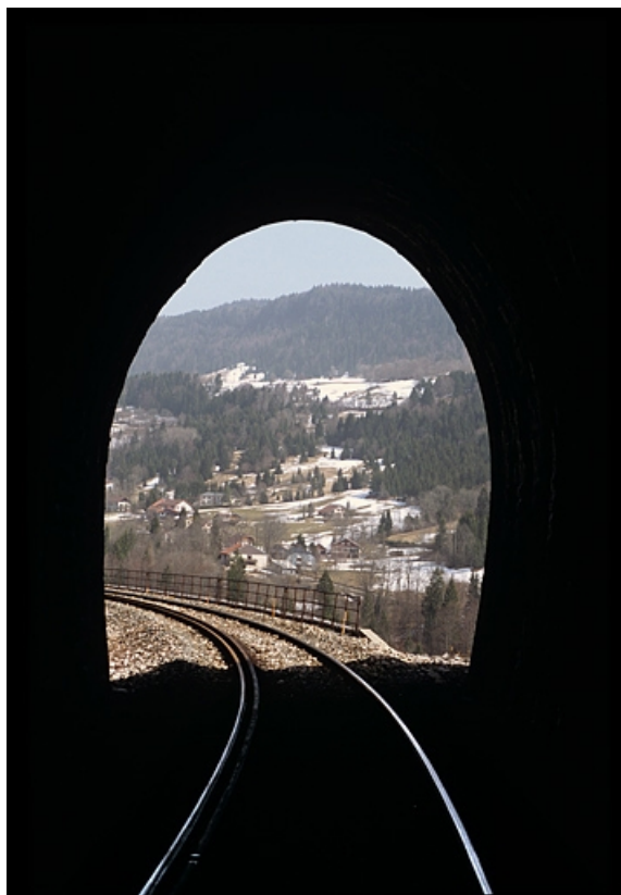
Tête côté La Cluse, depuis l'intérieur.
