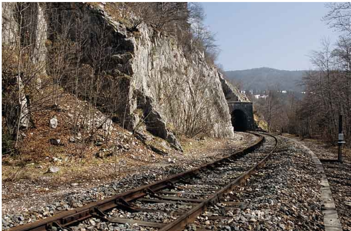
Vue d'ensemble, depuis le nord-ouest (côté Andelot-en-Montagne).
