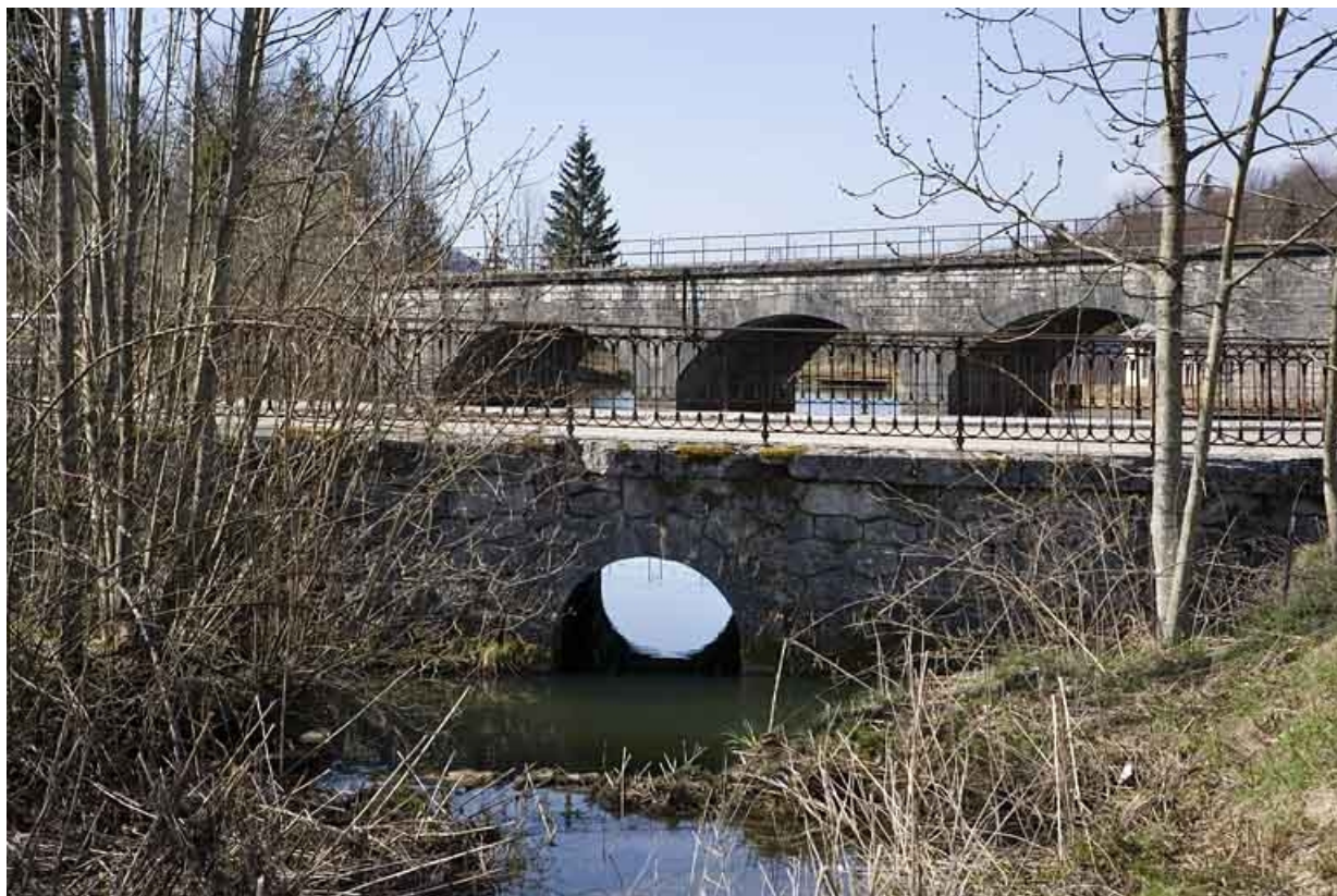
Pont sur le Pontet : vue d'ensemble rapprochée, depuis le nord-est.
