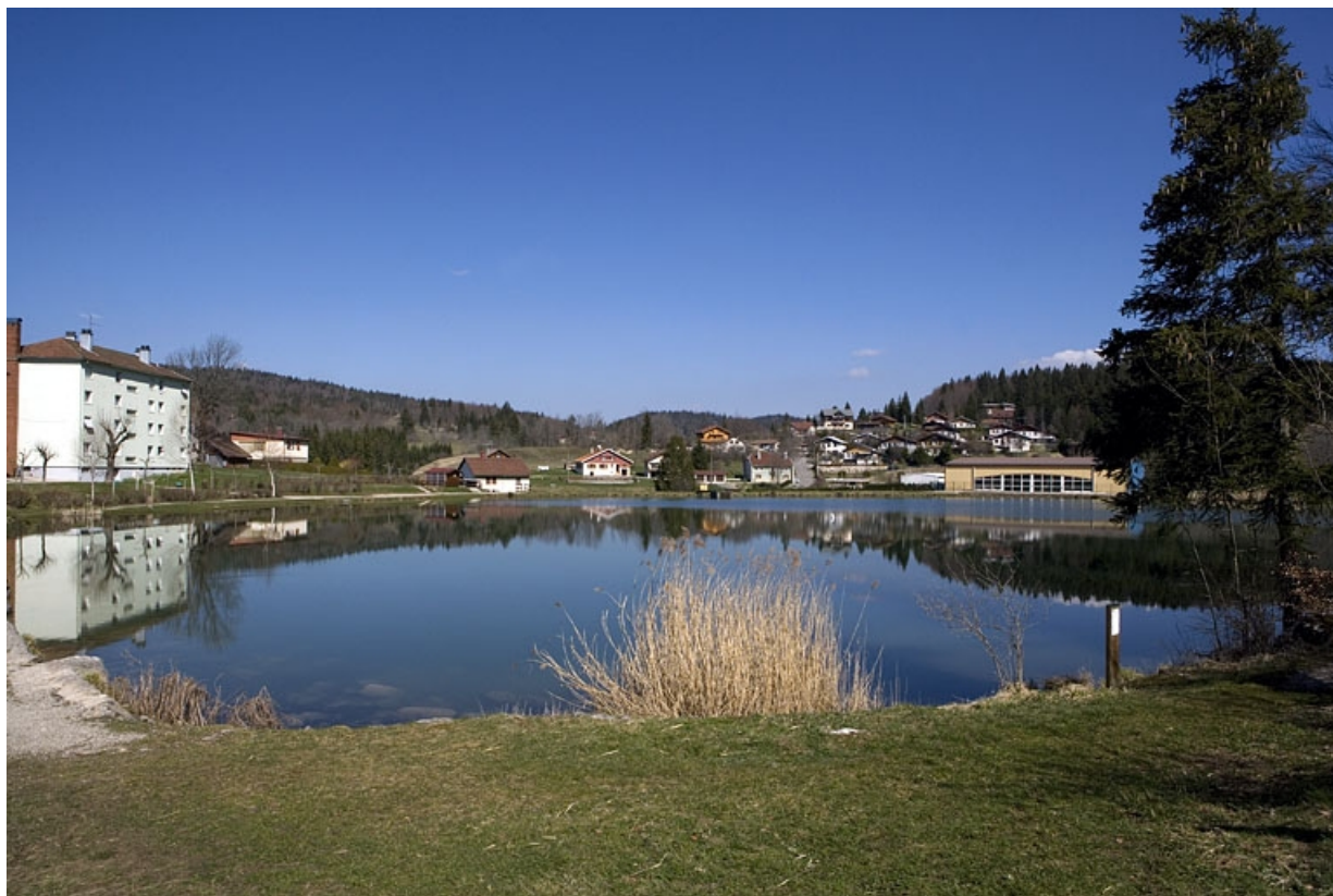
Réservoir : vue d'ensemble, depuis le sud.
