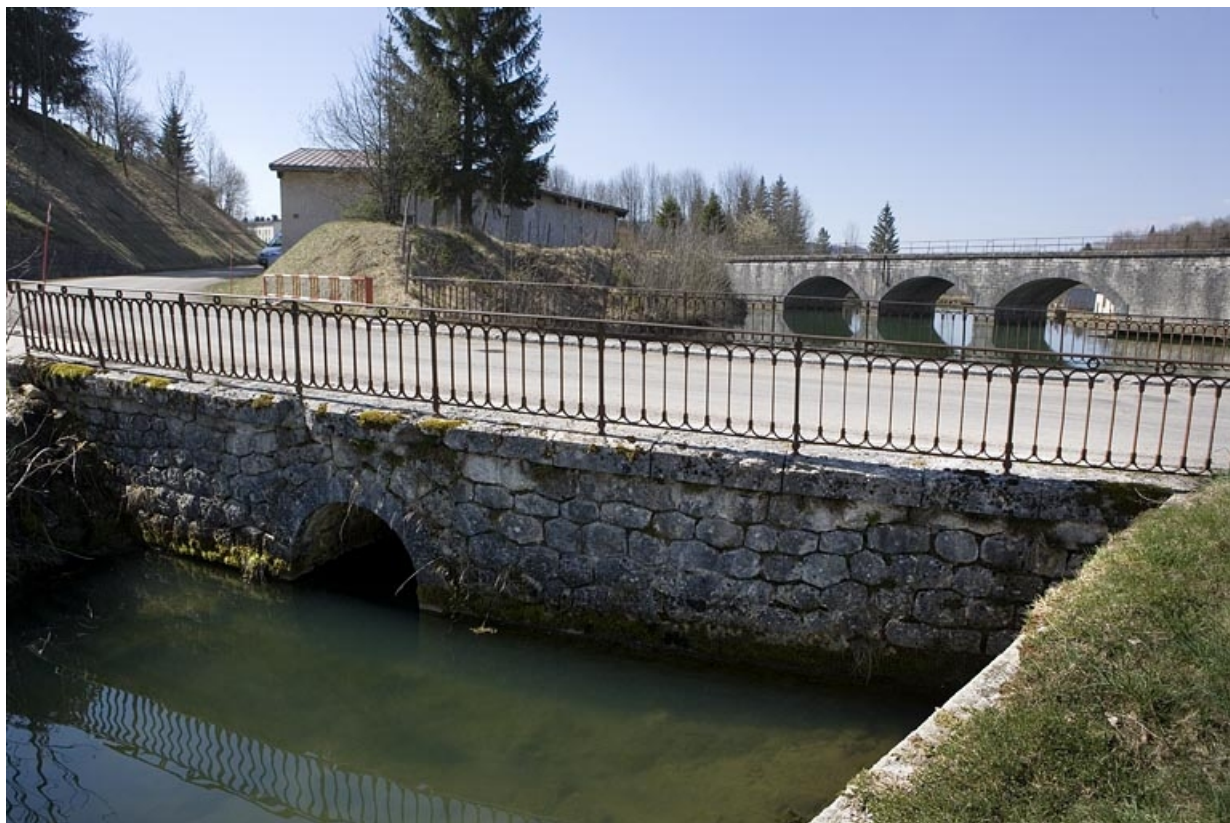
Pont sur le Pontet : vue d'ensemble, depuis le nord-est.
