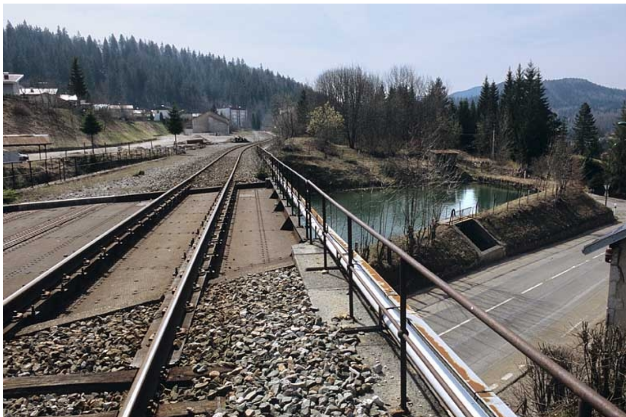
Pont et viaduc : tablier depuis la voie côté Andelot-en-Montagne, avec bassin de retenue Gaudard. 39, Morbier route Blanche
