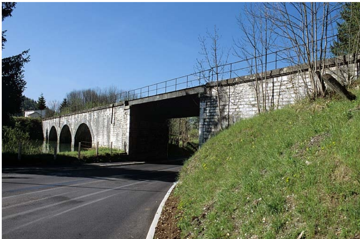
Vue d'ensemble depuis la route nationale (nord).
