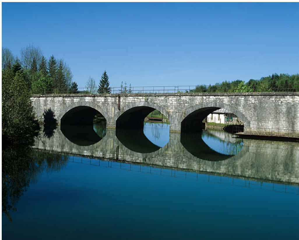
Viaduc : élévation orientale, depuis le nord-est.
