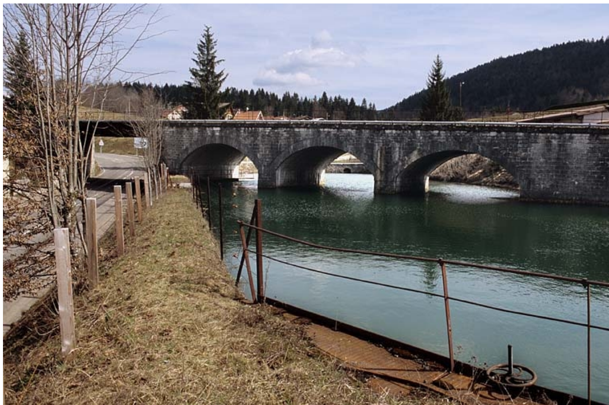
Vue d'ensemble depuis le bassin de retenue (sud-ouest), en aval.
