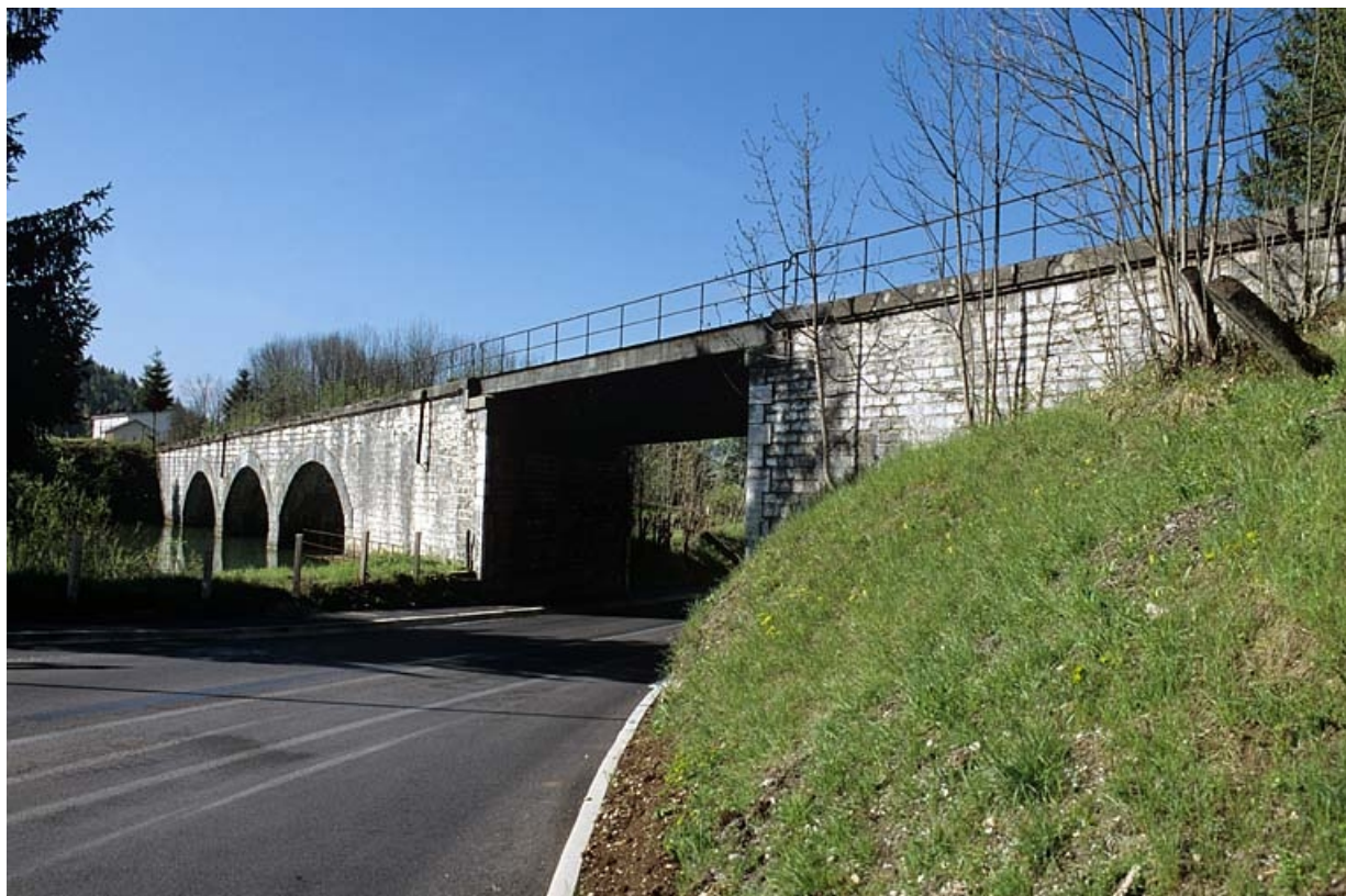
Vue d'ensemble depuis la route nationale (nord).
