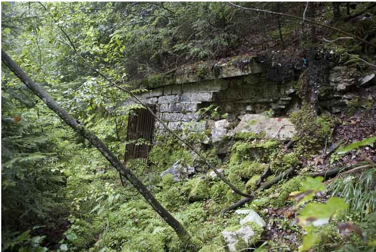
Chambres de mine centrale : entrée de la galerie.
