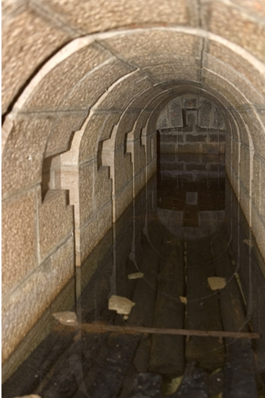
Chambres de mine centrale : galerie inférieure.
