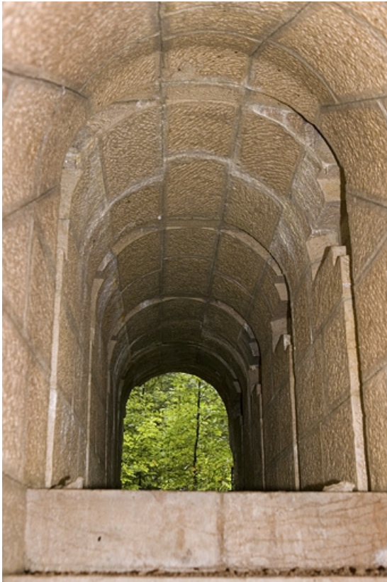
Chambres de mine centrale : galerie supérieure, vue depuis l'escalier. 39, Morbier, lieudit : le Bois de la Savine
