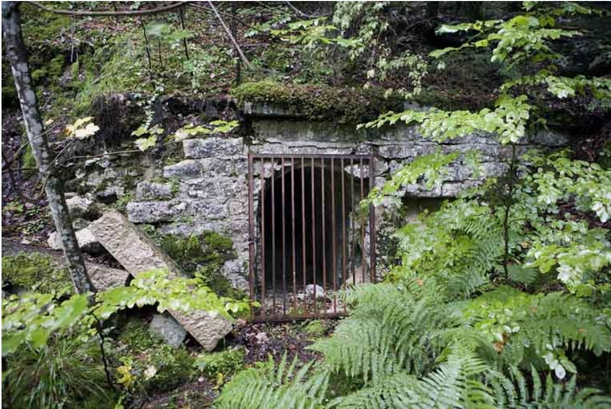
Chambres de mine sud-ouest : entrée de la galerie.
