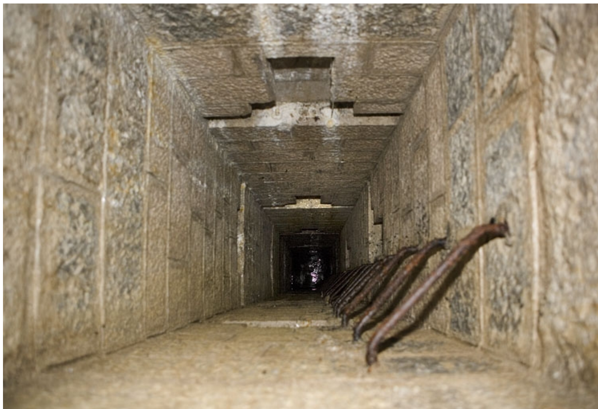
Chambres de mine sud-ouest : intérieur du puits.
