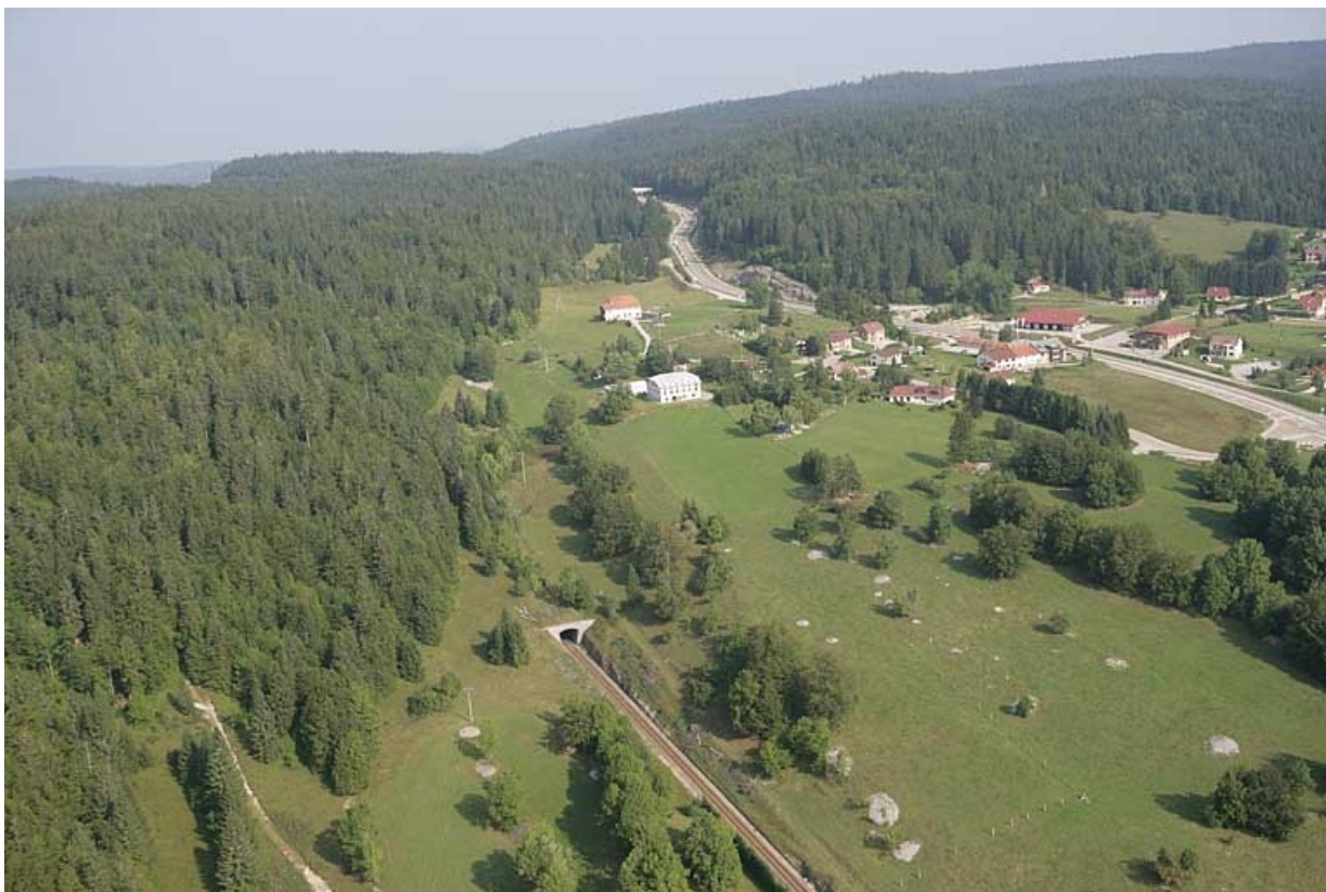
Vue aérienne de la tête côté La Cluse, depuis le sud.
