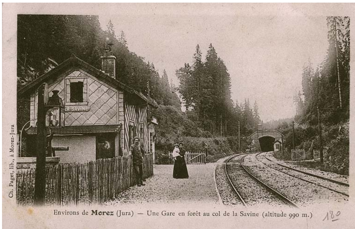
Environs de Morez (Jura) - une Gare en forêt au col de la Savine (altitude 990 m.) [entrée du tunnel côté Andelot-en-Montagne], entre 1899 et 1903.
