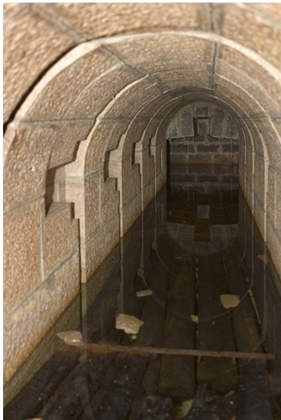
Chambres de mine centrale : galerie inférieure.
