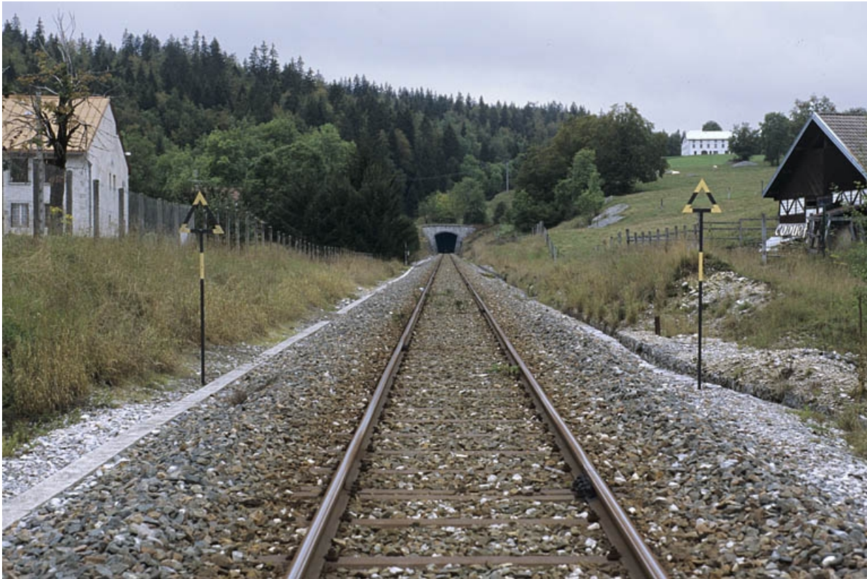
Vue d'ensemble depuis le passage à niveau n° 33, côté La Cluse.
