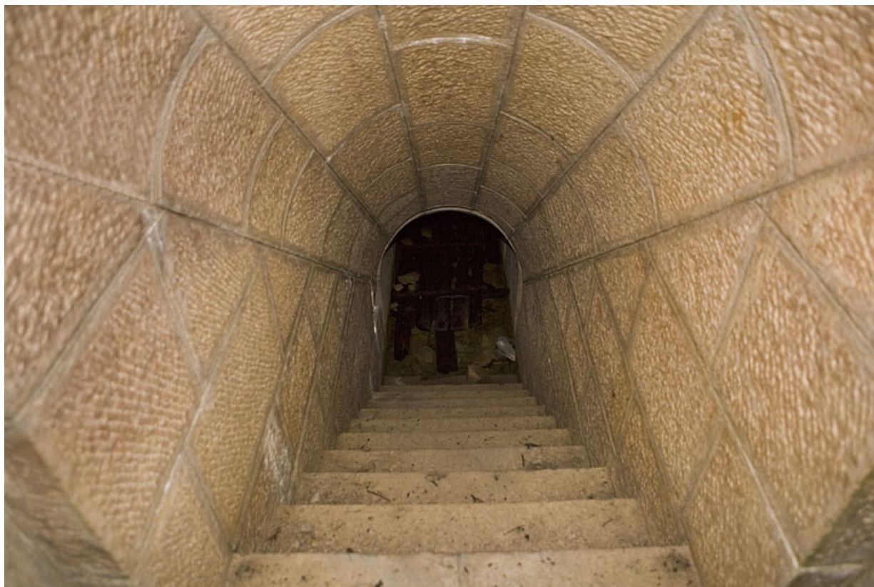
Chambres de mine centrale : escalier.
