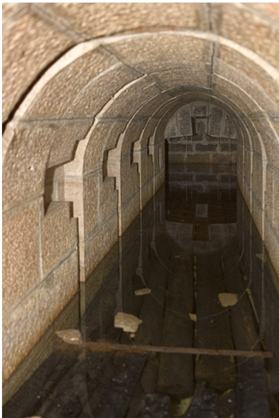
Chambres de mine centrale : galerie inférieure.
