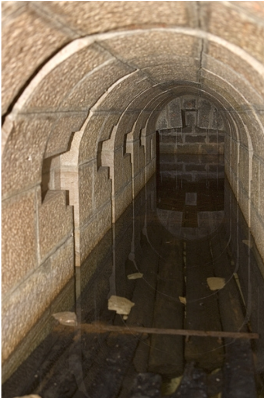
Chambres de mine centrale : galerie inférieure.
