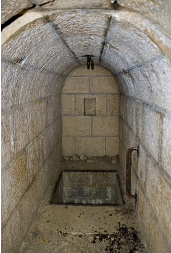
Chambres de mine sud-ouest : fond de la galerie et puits.
