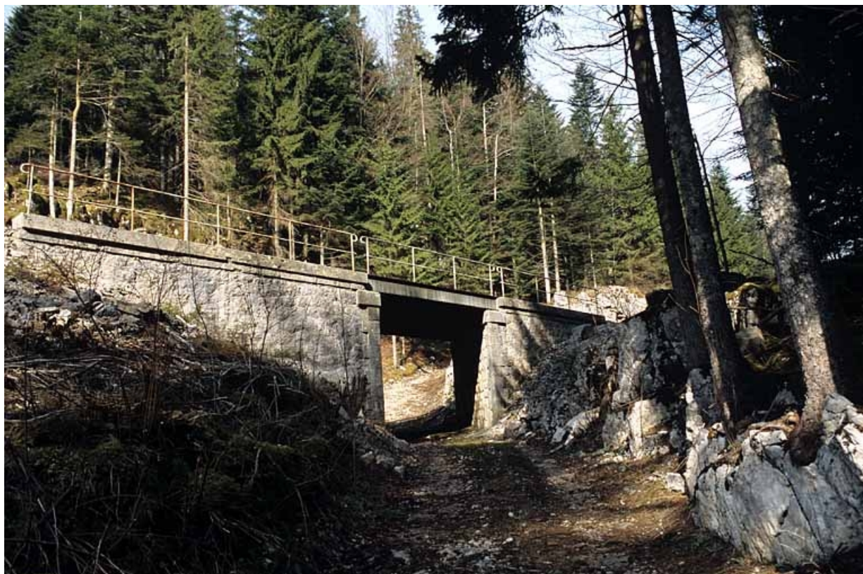
Vue d'ensemble, depuis le chemin à l'est.
