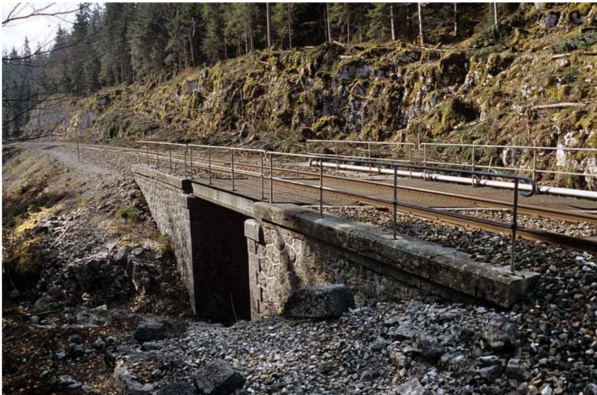
Élévation orientale vue en enfilade, depuis le nord (côté Andelot-en-Montagne).
