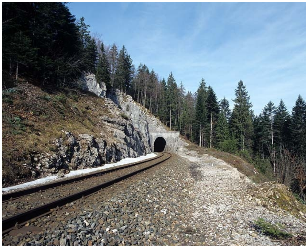
Vue d'ensemble de la tête côté La Cluse.
