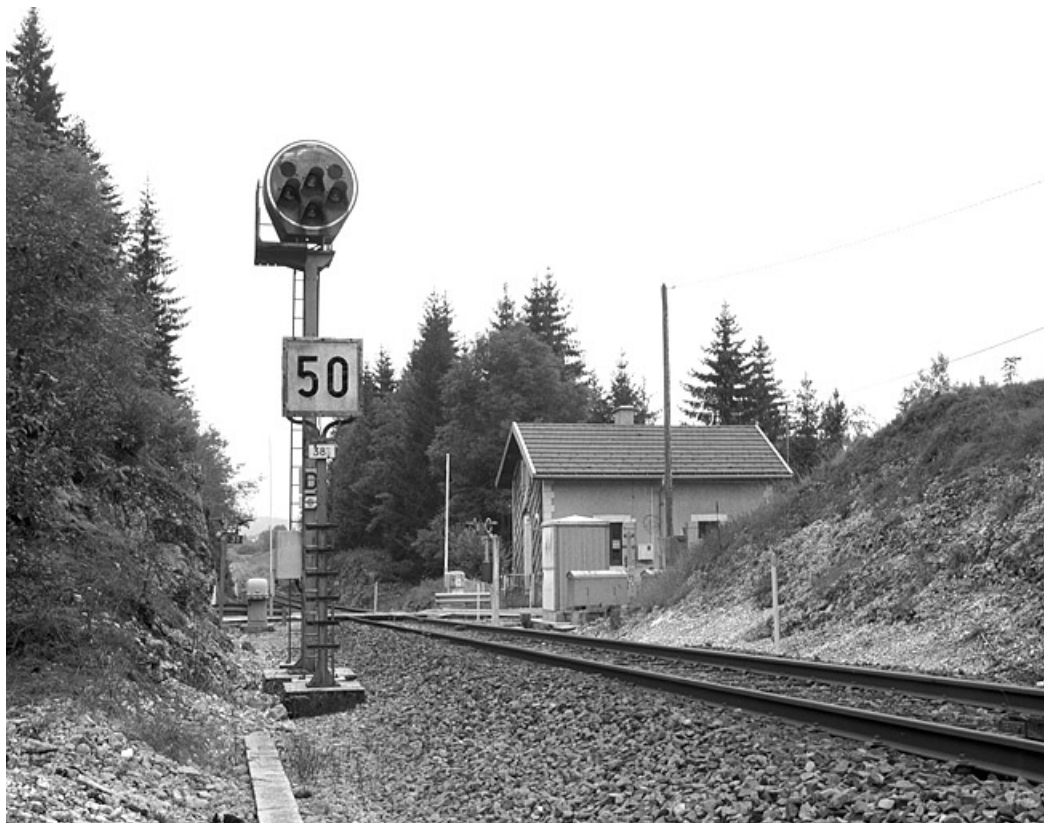
Vue d'ensemble depuis la voie, à l'est (côté La Cluse).
