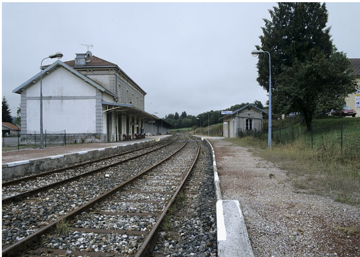
Bâtiment des voyageurs et abri : vue d'ensemble, depuis le nord (côté Andelot-en-Montagne). 39, Saint-Laurent-en-Grandvaux place de la Gare
