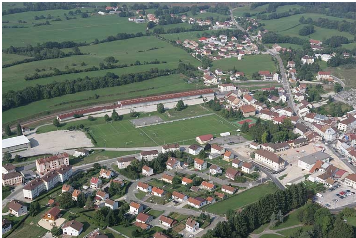
Vue aérienne du quartier de la gare, depuis l'est. 39, Saint-Laurent-en-Grandvaux place de la Gare
