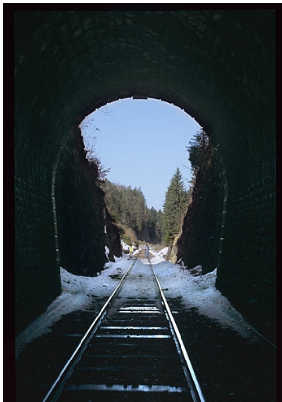
Intérieur (côté Andelot-en-Montagne) : tête. 39, La Chaumusse, lieudit : la Vie de la Serre
