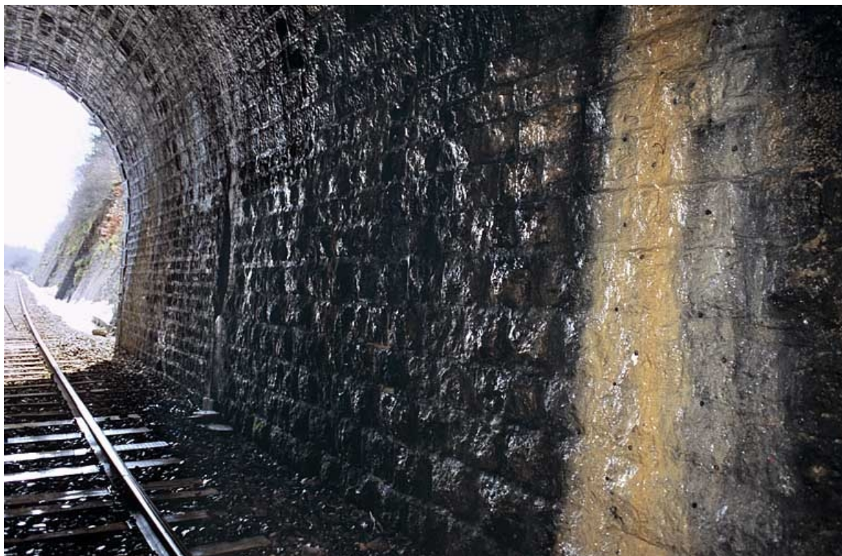
Intérieur (côté La Cluse) : appareil à bossages du mur et voile de calcite. 39, La Chaumusse, lieudit : la Vie de la Serre
