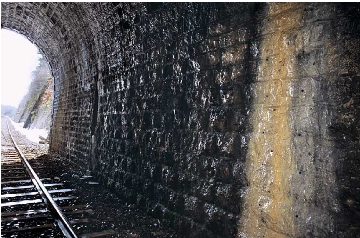
Intérieur (côté La Cluse) : appareil à bossages du mur et voile de calcite. 39, La Chaumusse, lieudit : la Vie de la Serre
