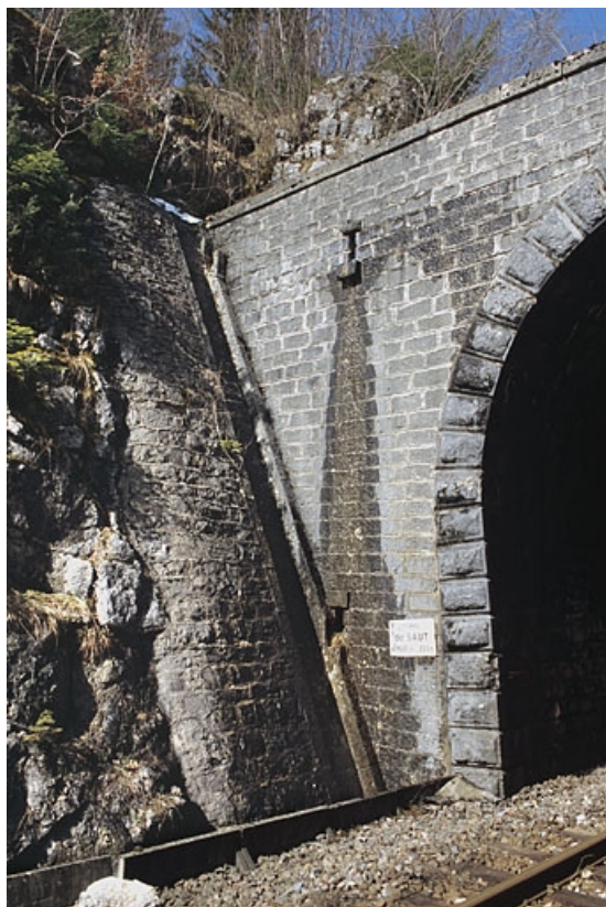
Tête côté La Cluse : descente d'eau, chantepleures et caniveau.
