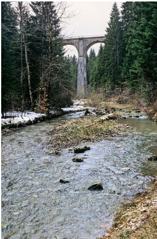
Viaduc : vue d'une pile, depuis le fond du vallon au nord-est.
