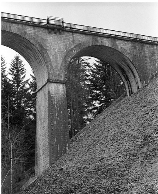
Première arche côté Andelot-en-Montagne, depuis l'est.
