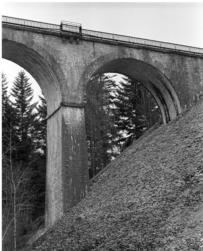
Première arche côté Andelot-en-Montagne, depuis l'est.
