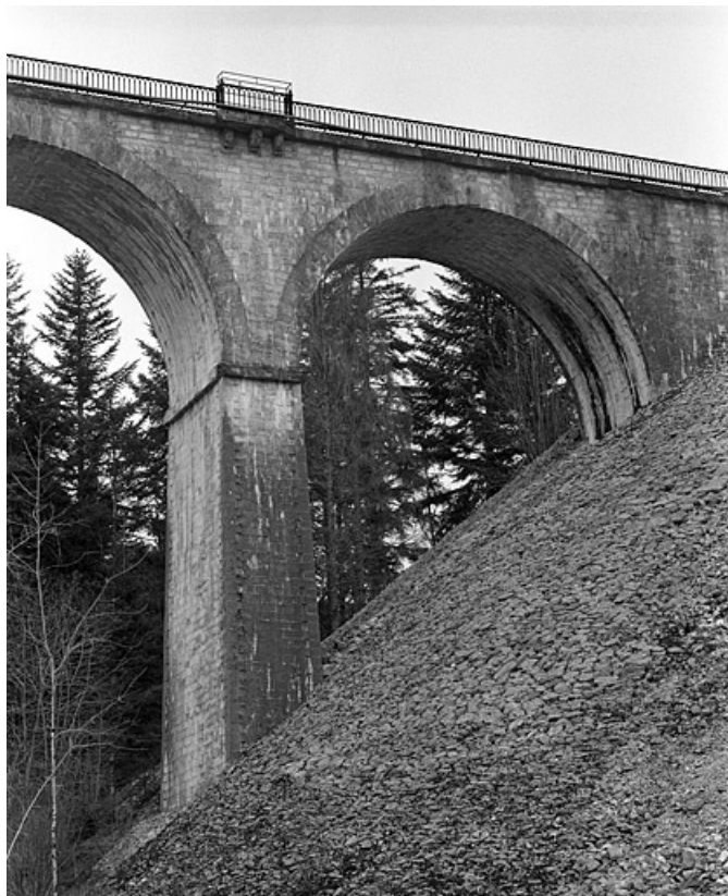
Première arche côté Andelot-en-Montagne, depuis l'est.
