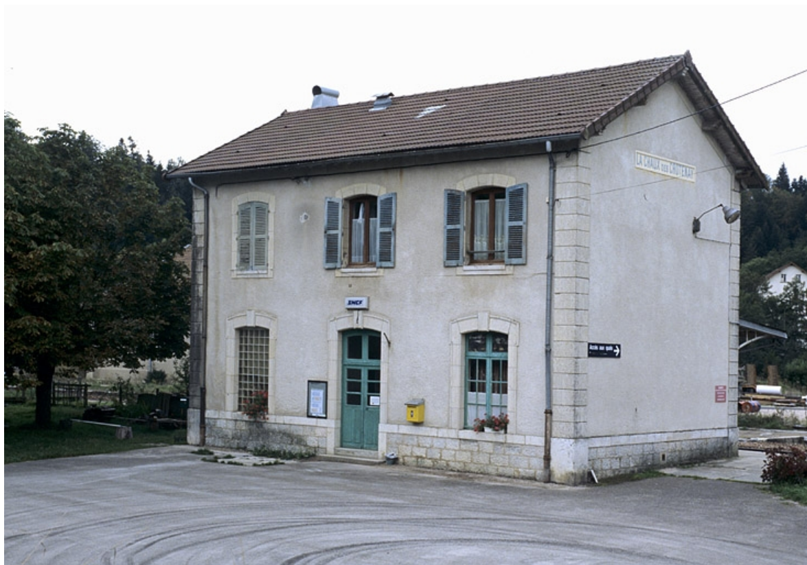
Bâtiment des voyageurs : façade antérieure, de trois quarts droite. 39, Chaux-des-Crotenay, 4 rue de la Gare, lieudit : le Pont de la Chaux
