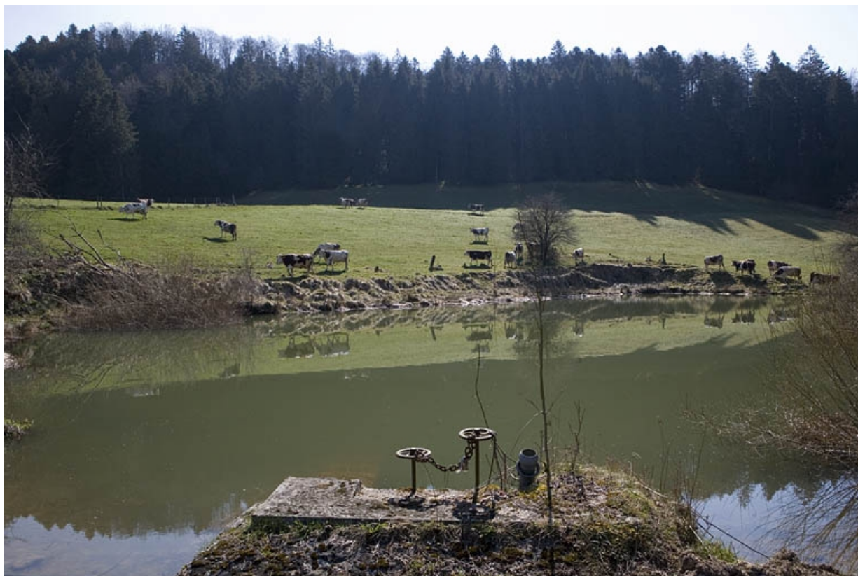
Réservoir : vue d'ensemble, depuis l'ouest.
