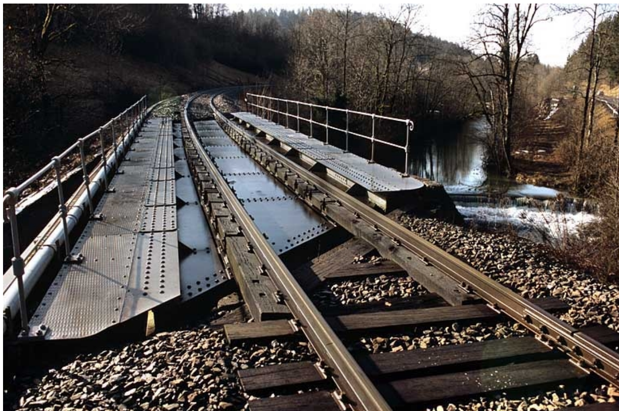
Pont sur la Lemme : tablier, depuis la voie côté Andelot-en-Montagne.
