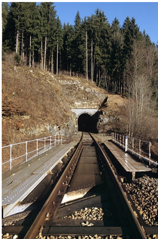
Pont sur la route nationale n° 5 : tablier, depuis la voie côté La Cluse.
