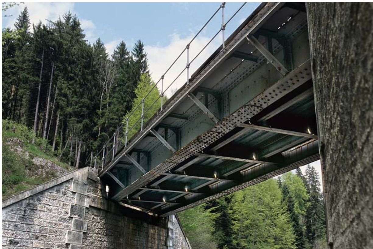
Pont sur la route nationale n° 5 : dessous du tablier.
