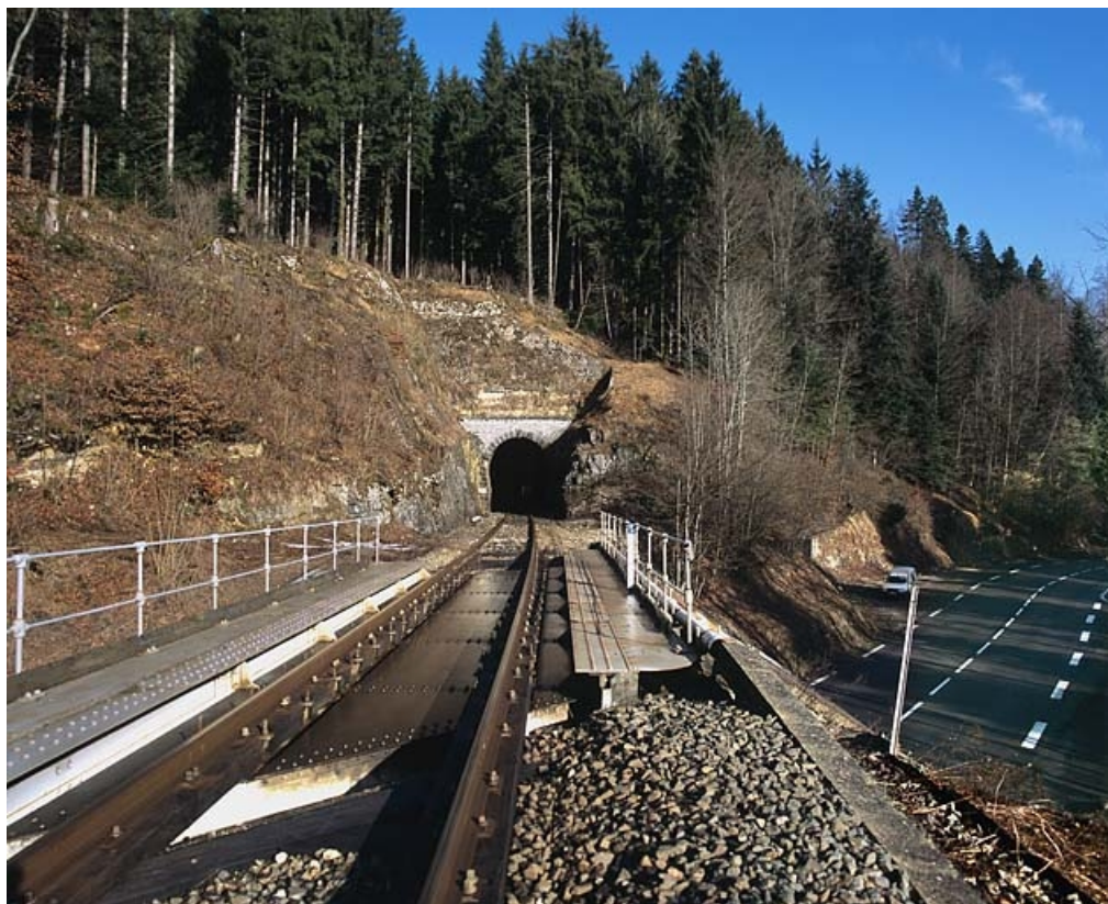
Tunnel : tête côté La Cluse, depuis la voie et le pont sur la R.N. 5.
