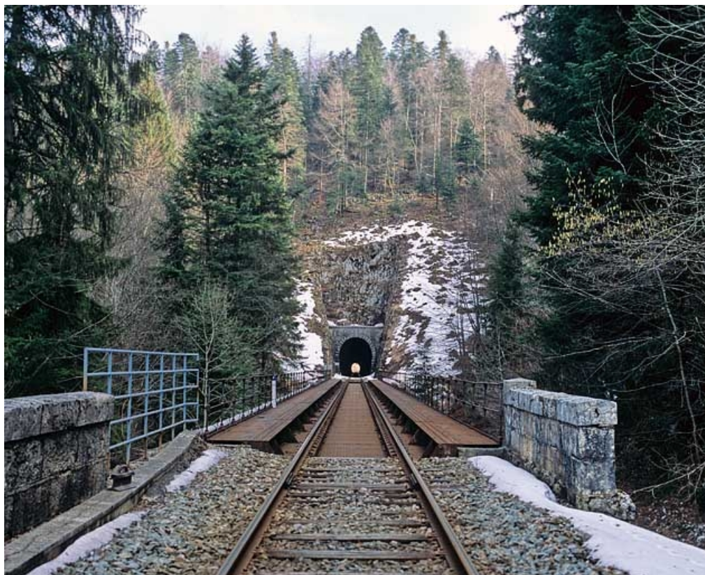
Vue d'ensemble depuis la voie, côté Andelot-en-Montagne.
