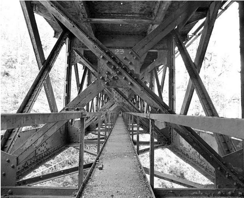
Viaduc : passerelle sous le tablier.
