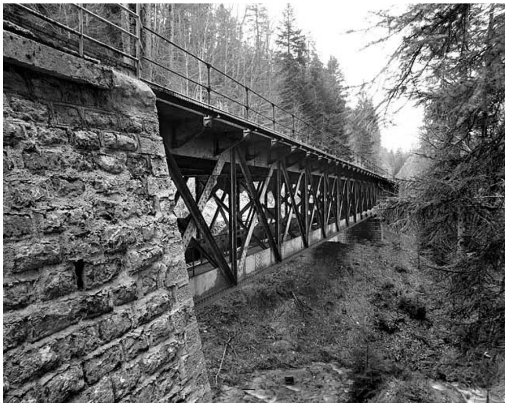
Viaduc : l'extrémité sud (vers La Cluse), côté vallée.
