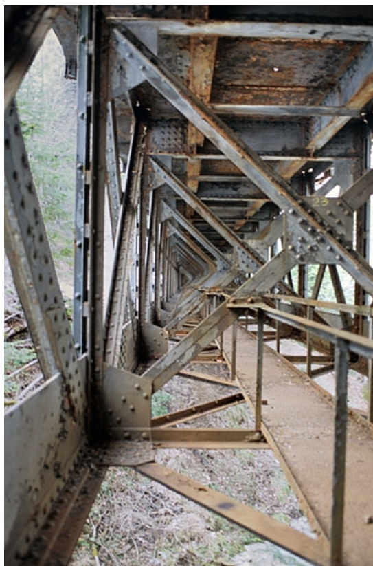
Viaduc : passerelle sous le tablier (vue désaxée à gauche).
