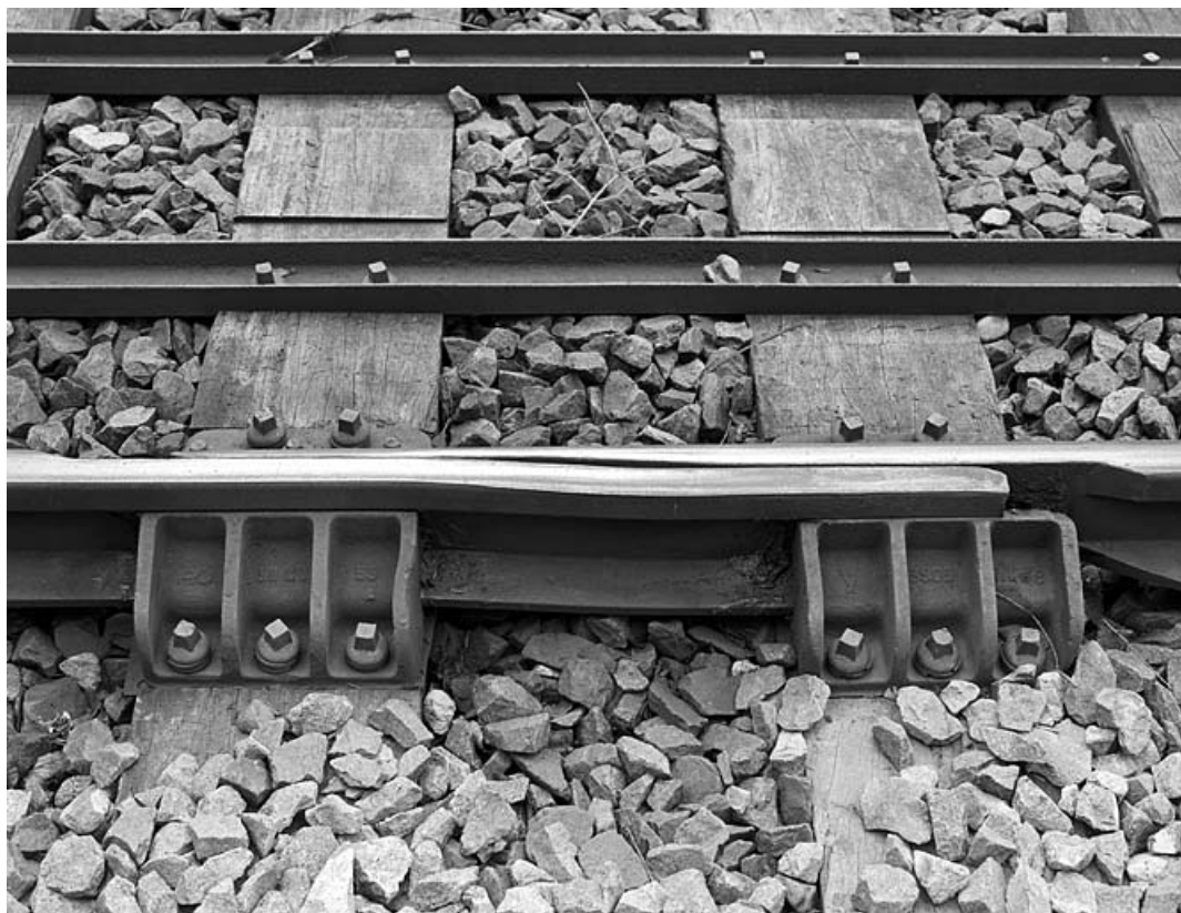
Viaduc : appareil de dilatation. Les extrémités des rails, amincies et guidées dans des coussinets, peuvent glisser l'une contre l'autre lorsque les travées métalliques se dilatent.
