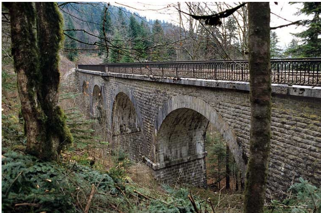
Viaduc : élévation sud (côté rocher).
