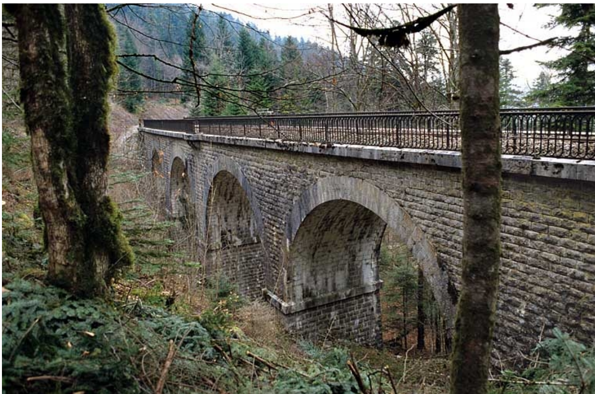
Viaduc : élévation sud (côté rocher).
