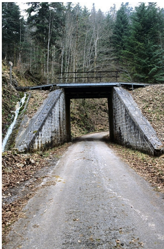
Pont, depuis la route côté vallée.
