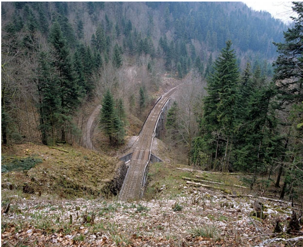
Vue d'ensemble plongeante, depuis la tête ouest du tunnel (côté Andelot-en-Montagne).
