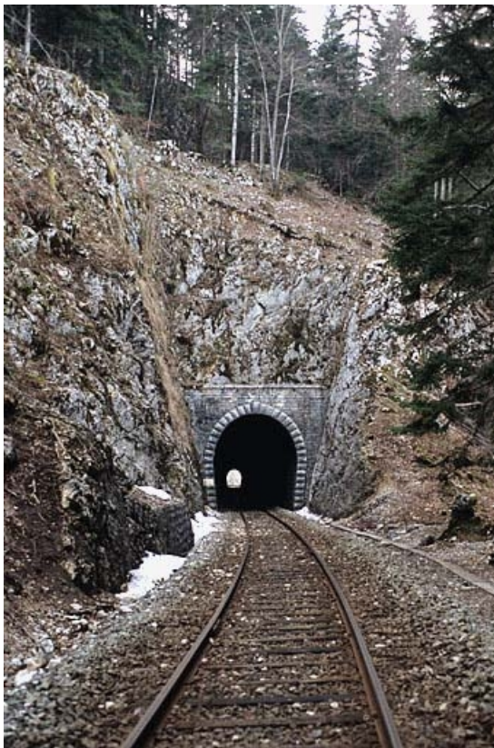
Tunnel : tête côté La Cluse.
