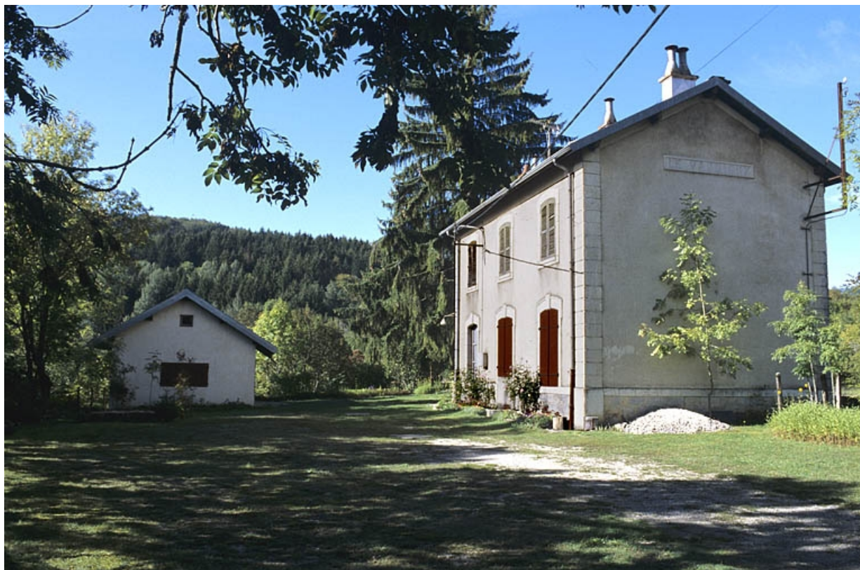
Façade antérieure du bâtiment des voyageurs, de trois quarts droite.
