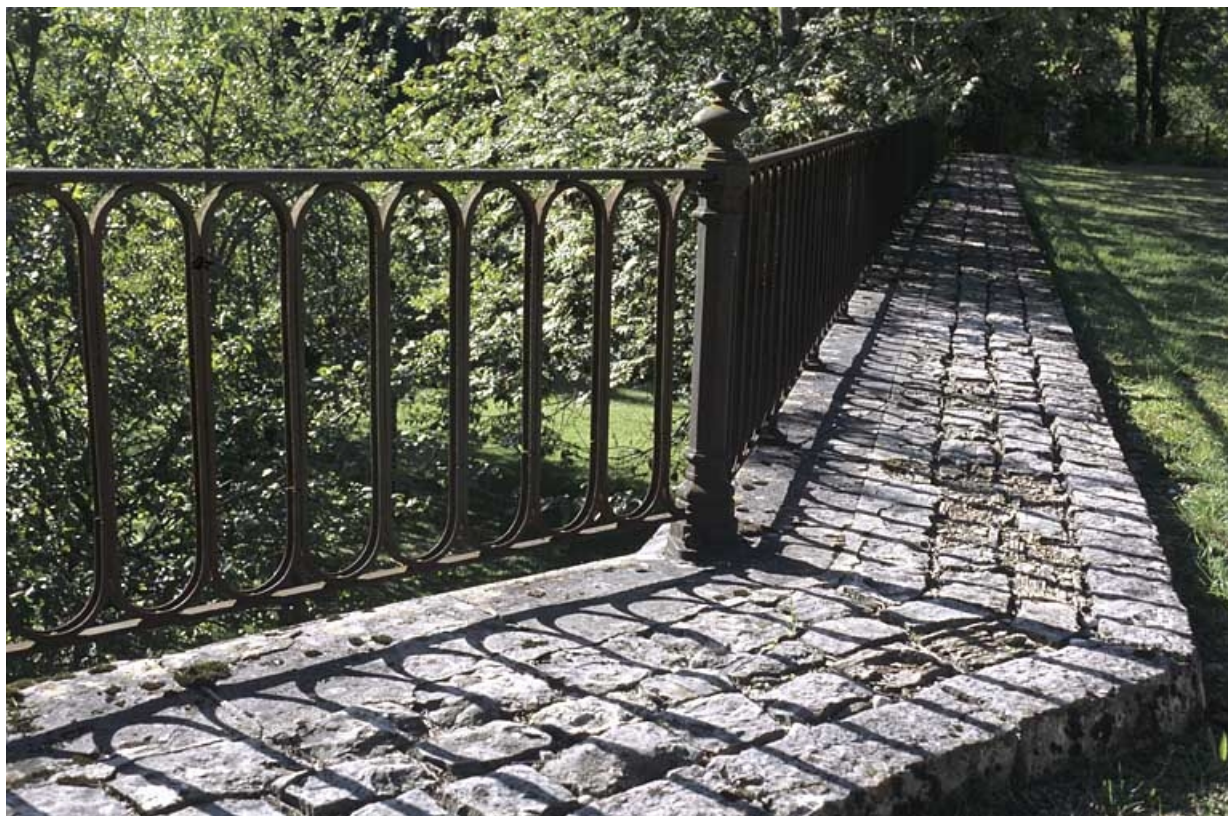
Garde-corps métallique de la cour des voyageurs.
