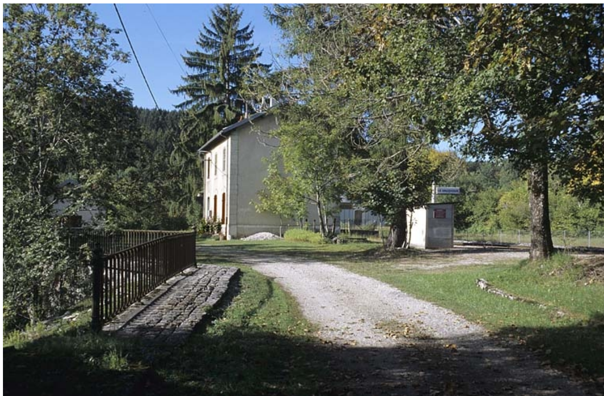
Bâtiment des voyageurs depuis le chemin d'accès, au nord-est.
