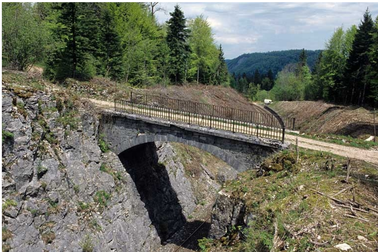
Vue plongeante, depuis le sud (côté La Cluse).
