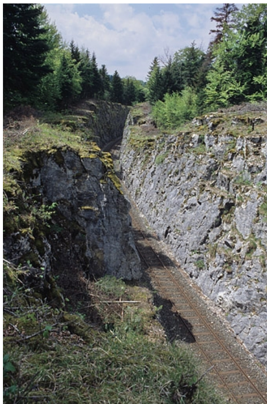
Tranchée côté Andelot-en-Montagne, vue du pont.
