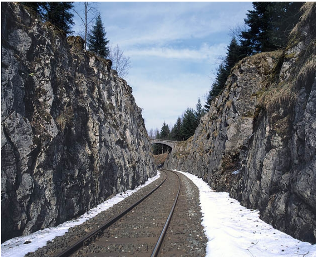
Vue d'ensemble du pont et de la tranchée, depuis la voie (côté Andelot-en-Montagne).
