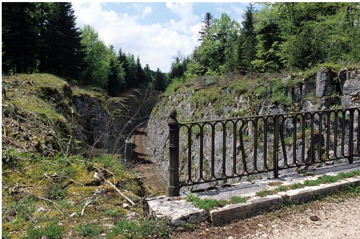
Tranchée côté Andelot-en-Montagne et détail du garde-corps.
