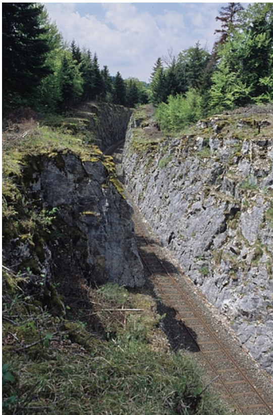
Tranchée côté Andelot-en-Montagne, vue du pont.
