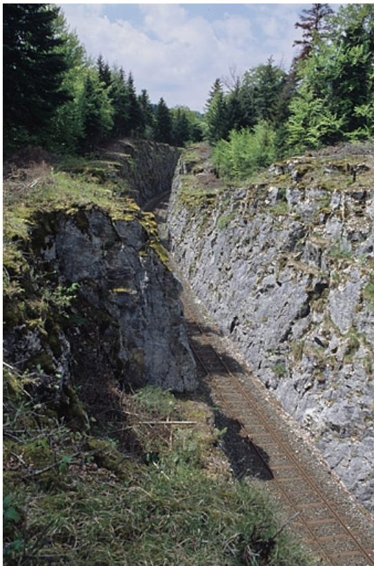
Tranchée côté Andelot-en-Montagne, vue du pont.
