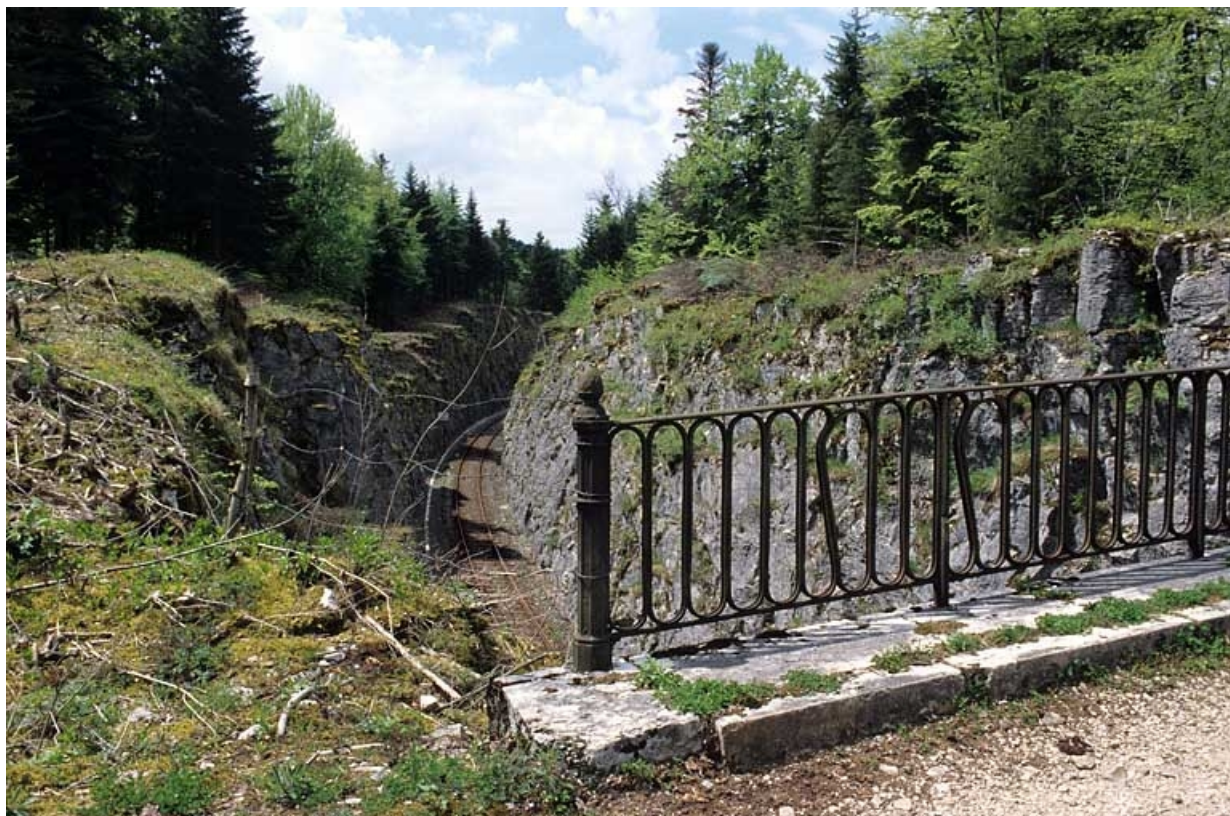
Tranchée côté Andelot-en-Montagne et détail du garde-corps.
