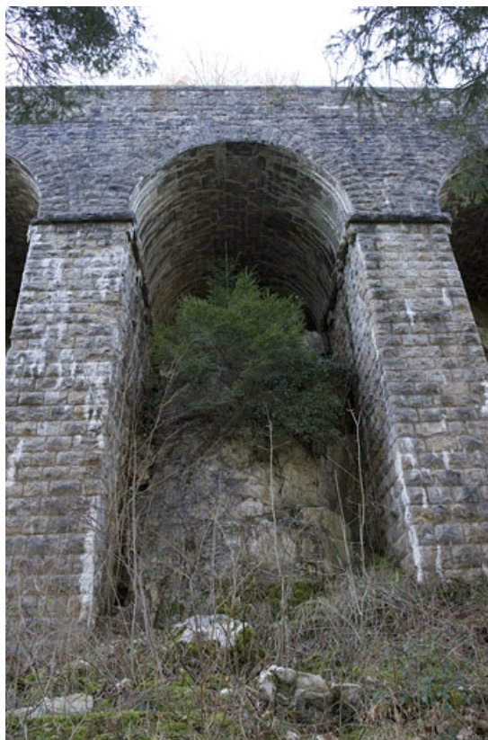
Deuxième mur à arcades : arche enjambant le rocher.
