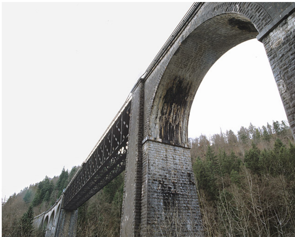
Troisième arche rive droite et travée métallique, vues par dessous.
