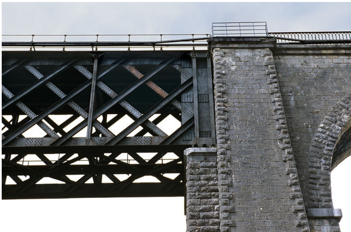
Détail de la jonction de la travée métallique et de l'arche en maçonnerie, rive droite.
