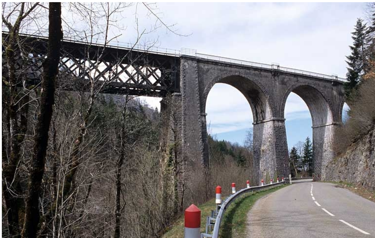
Partie en maçonnerie rive droite, depuis la route en amont.
