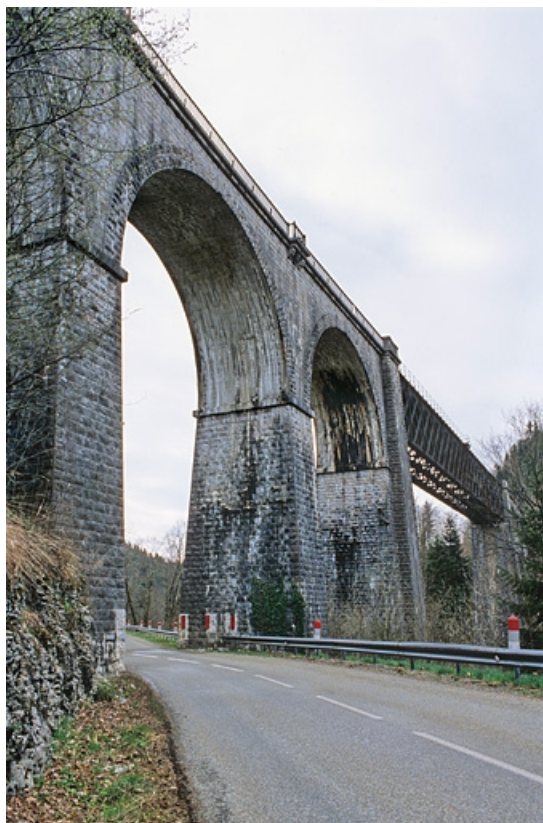
Partie en maçonnerie rive droite, depuis la route en aval.
