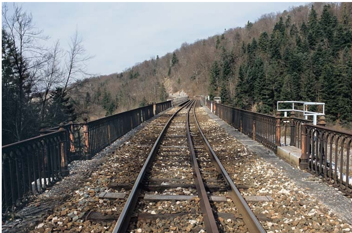
La voie, depuis la rive gauche (côté La Cluse).
