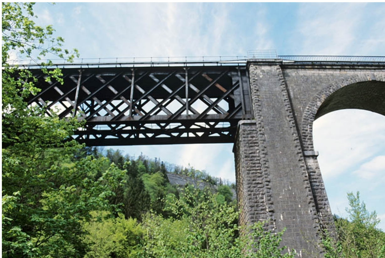
Jonction de la travée métallique et de l'arche en maçonnerie, rive droite.
