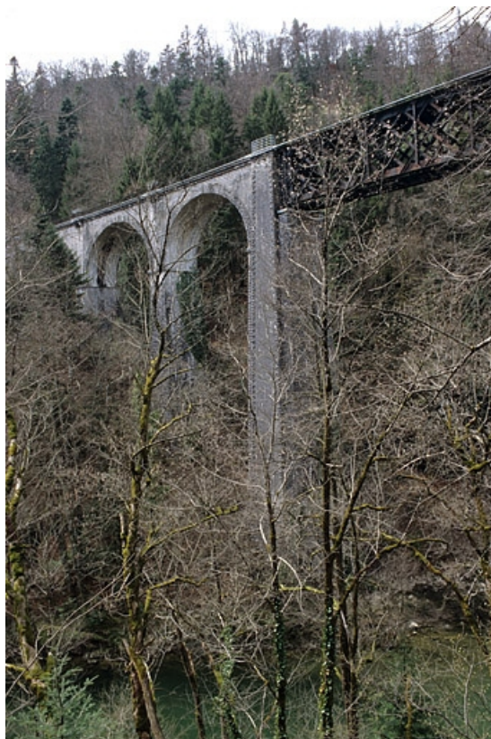
Partie en maçonnerie rive gauche et travée métallique, depuis la rive droite en amont. 39, Cize R.D. 127, lieudit : le Rocheret
