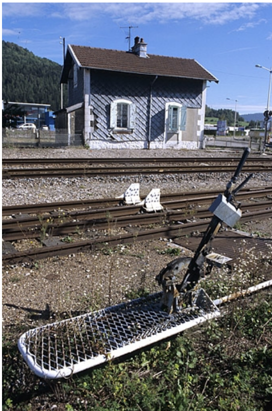
Au premier plan, levier de manoeuvre d'appareil de voie.
