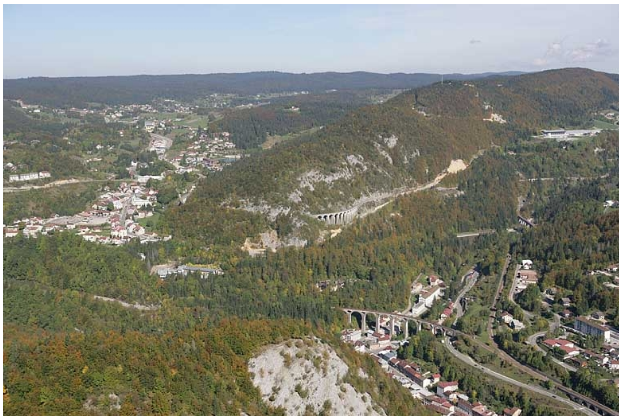
Vue aérienne du relief de la zone de Morbier - Morez, depuis le sud.
