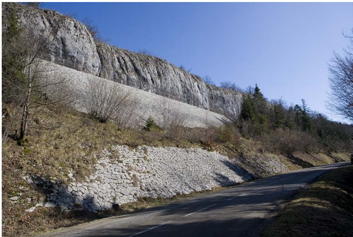
Murs de soutènement (commune de Champagnole), à droite de la voie avant le viaduc de Syam. Mur situé entre les PK 017.000 et 018.000, en contre-haut de la R.D. 127.
