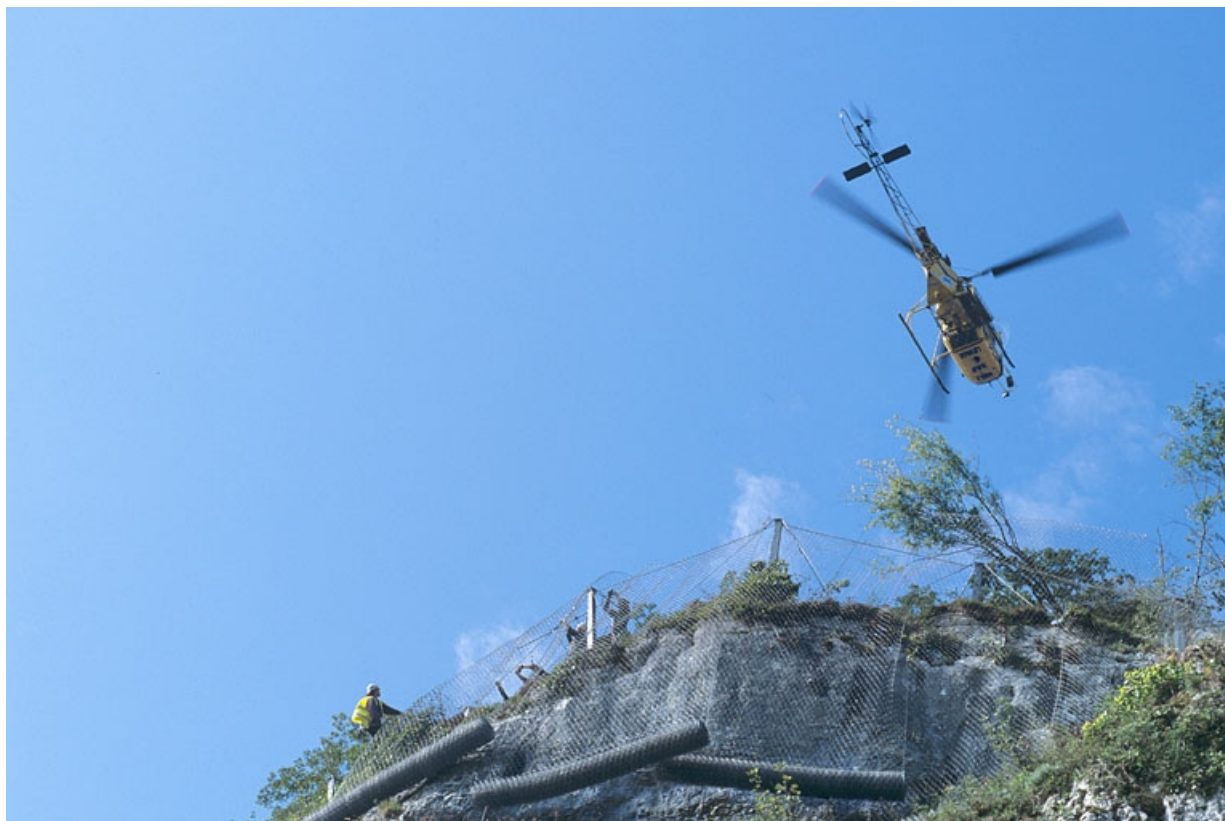
Sécurisation de paroi rocheuse à Syam : ancrage d'un rouleau de filet de protection.
