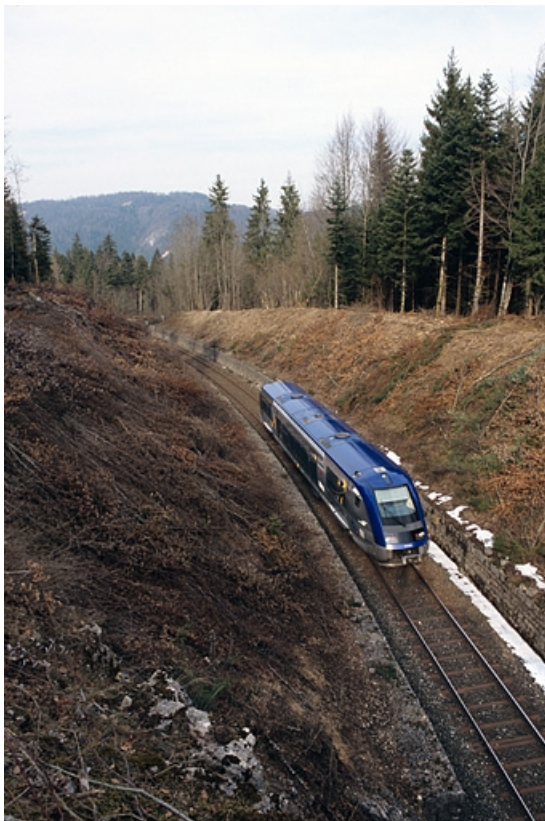
La voie vue du pont routier du Vaudioux (PK 021.507), au passage d'un autorail X 73500.
