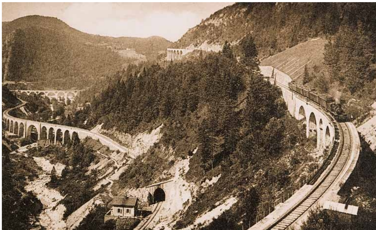
Morez - Les Quatre Viaducs. Ligne Morez - Andelot, milieu 20e siècle.
