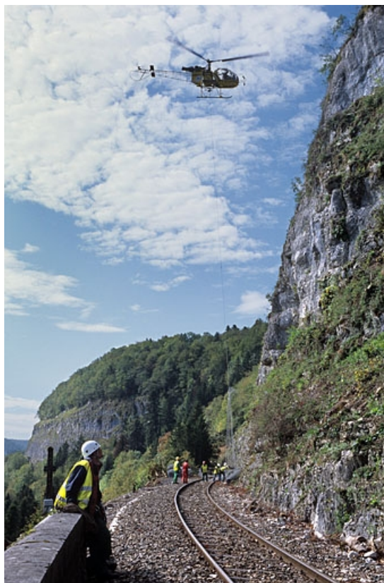
Sécurisation de paroi rocheuse à Syam : hélicoptère et rouleau de filet de protection en cours de levage.
