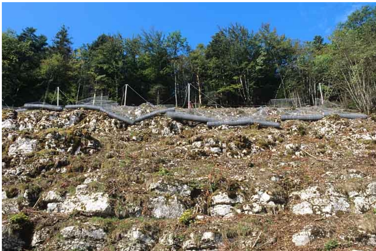
Sécurisation de paroi rocheuse à Syam : rouleaux de filet de protection en attente de déroulage.
