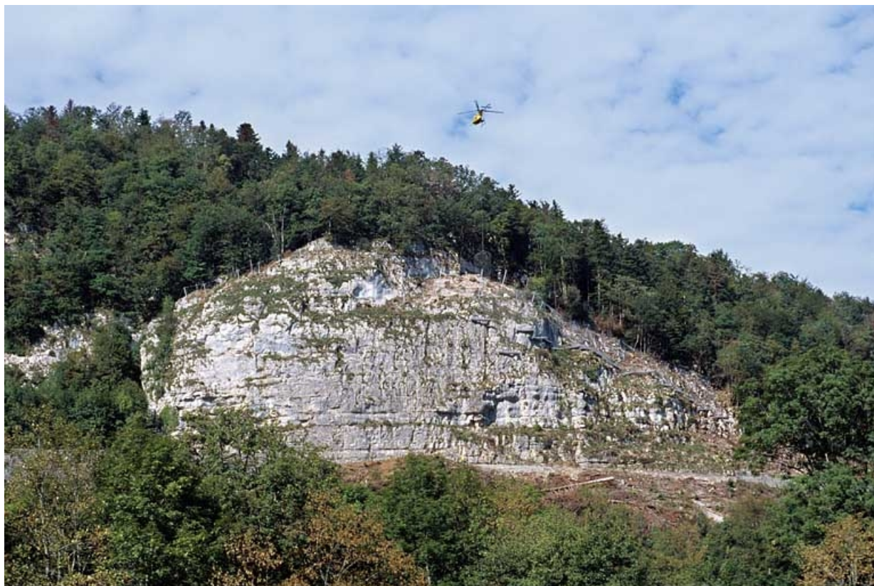
Sécurisation de paroi rocheuse à Syam : transport par hélicoptère d'un rouleau de filet de protection.
