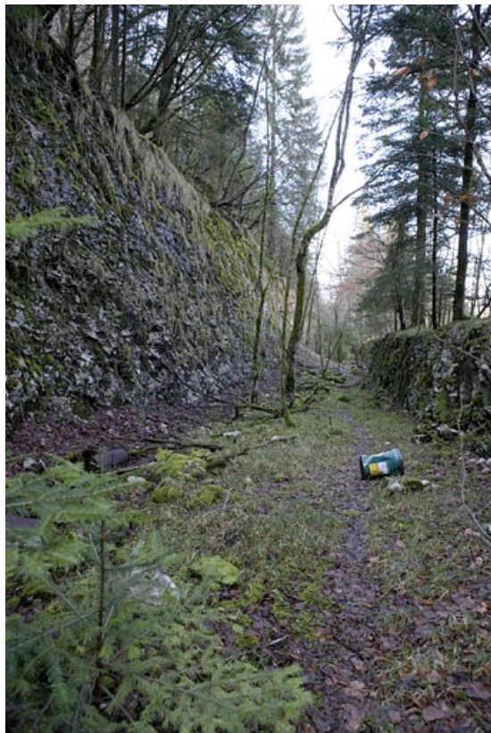
Tranchée du premier tracé abandonnée, rive gauche de l'Ain, à proximité du viaduc de Syam (commune de Cize).
