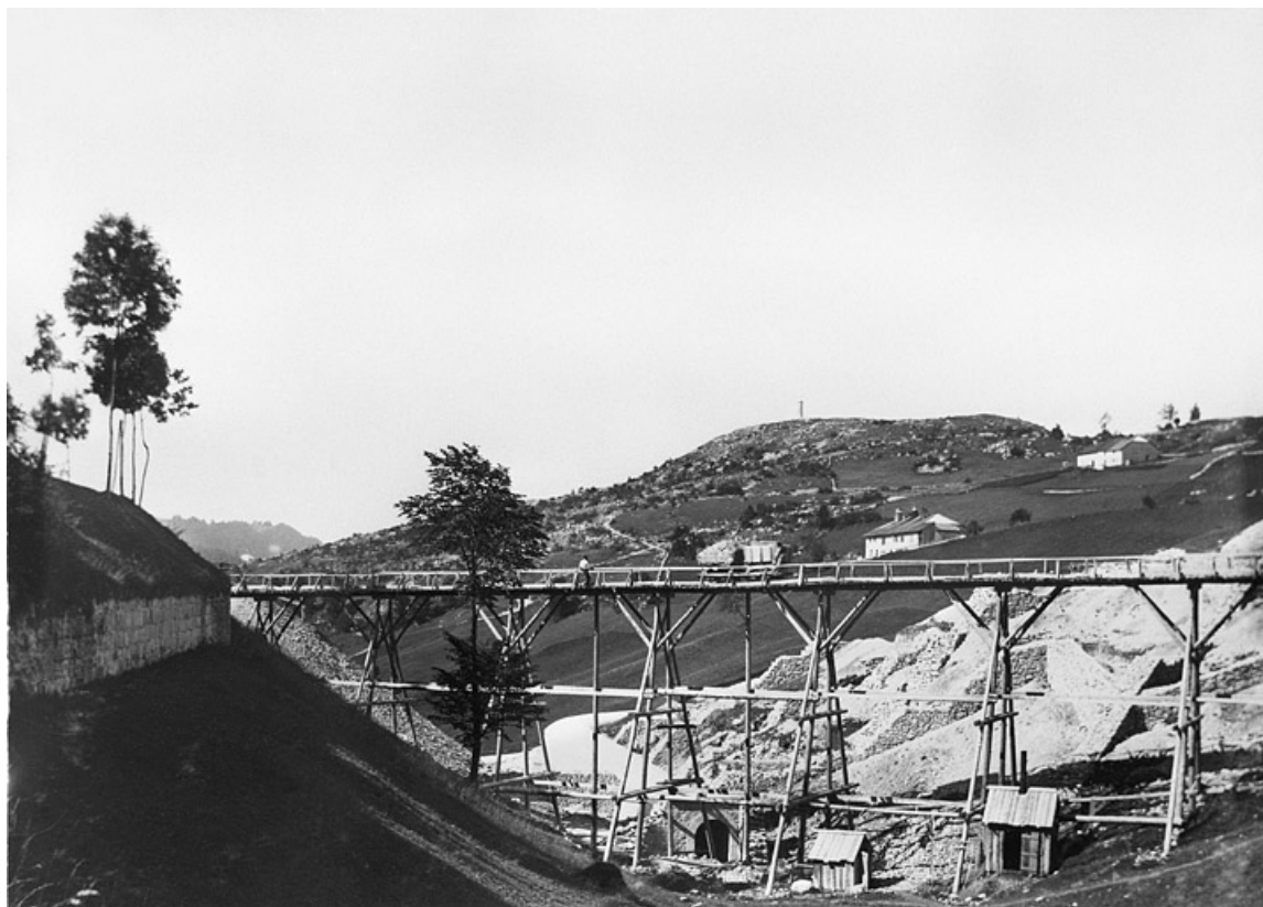
Travaux du chemin de fer : le commencement du remblai du vallon [en amont de la gare de Morbier].
