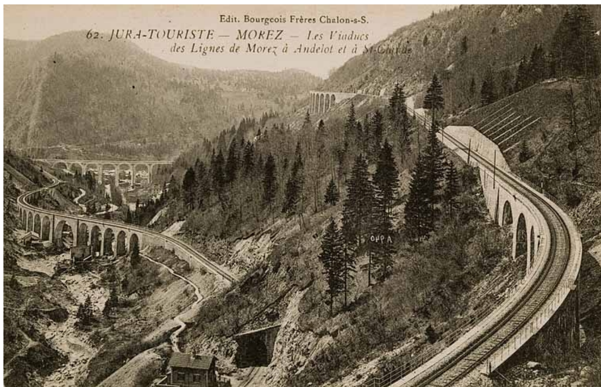
Jura - Touriste - Morez - Les Viaducs des Lignes de Morez à Andelot et à St-Claude, 1ère moitié 20e siècle.
