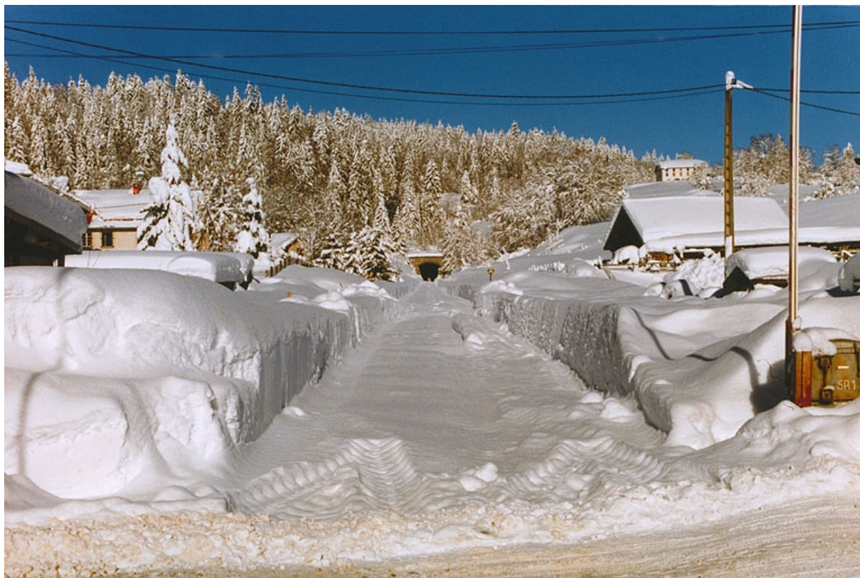
[Ligne droite enneigée à l'extrémité du tunnel de la Savine, côté La Cluse, en 2000].
