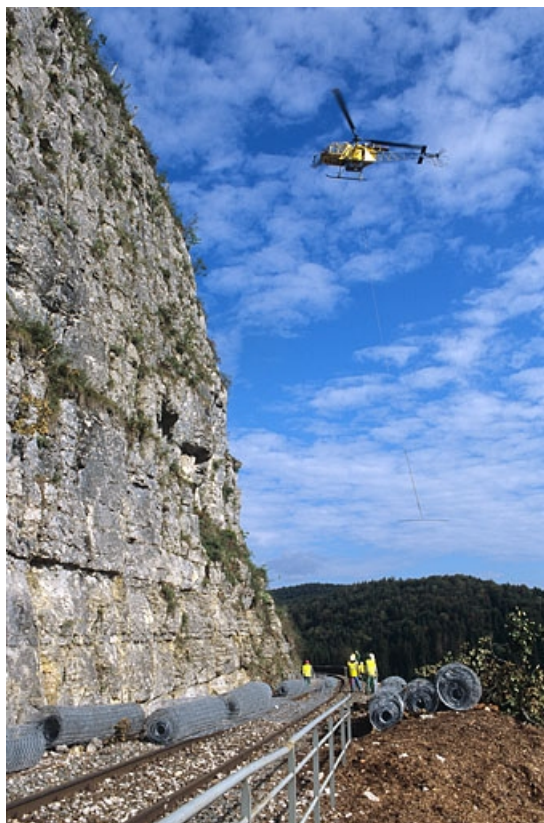
Sécurisation de paroi rocheuse à Syam : hélicoptère venant chercher un rouleau de filet de protection.
