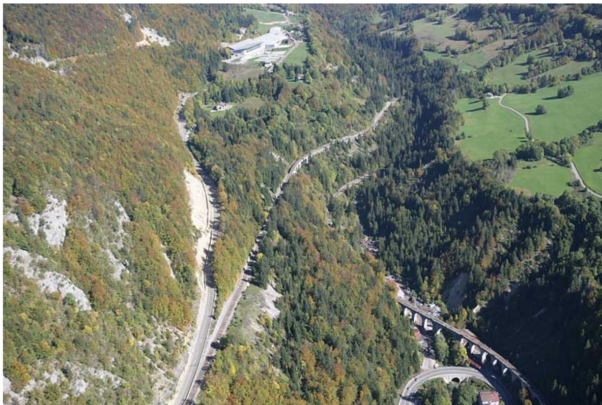
Vue aérienne des ouvrages situés entre les viaducs des Crottes et de la Source, depuis le sud-ouest.
