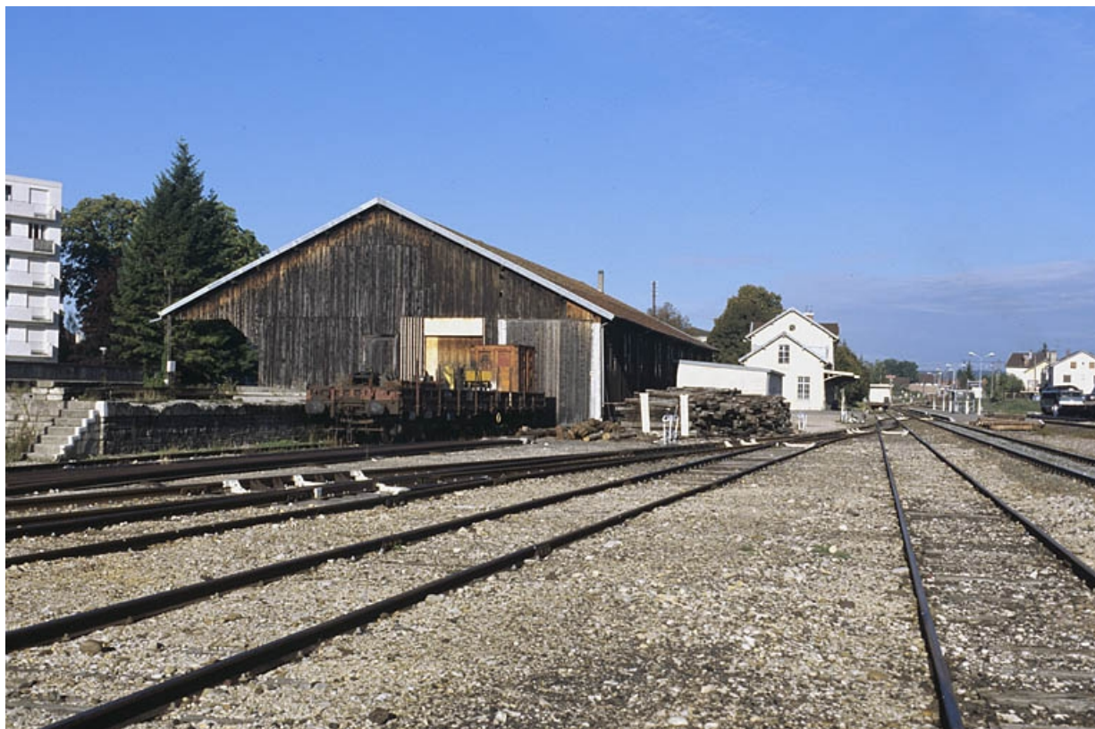
Entrepôt : vue d'ensemble, depuis le sud-est.
