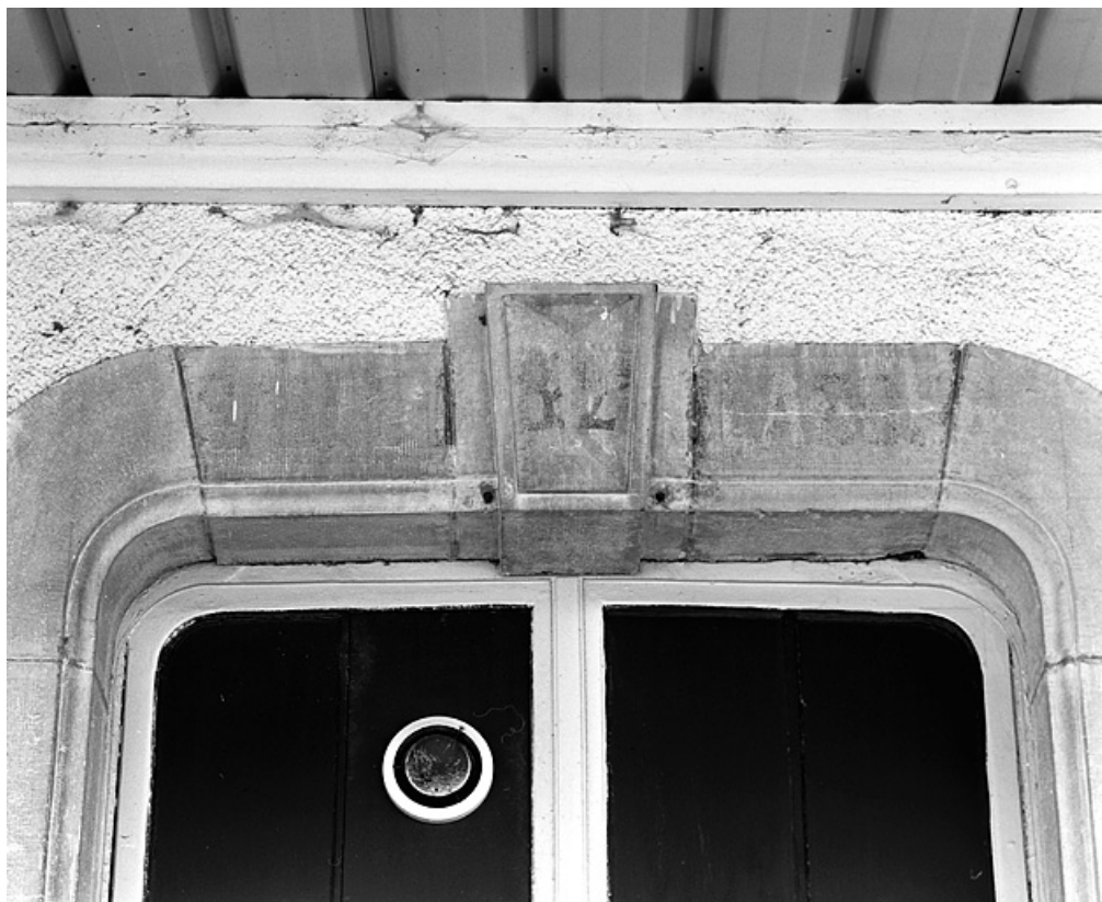
Bâtiment des voyageurs : plate-bande d'une fenêtre.
