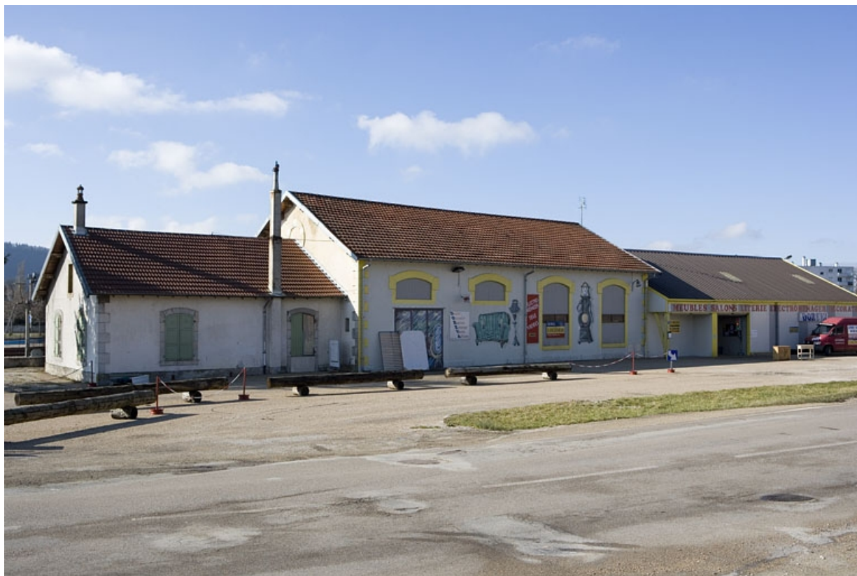
Remise ferroviaire et bureau (actuellement magasin de commerce), vus depuis l'est.
