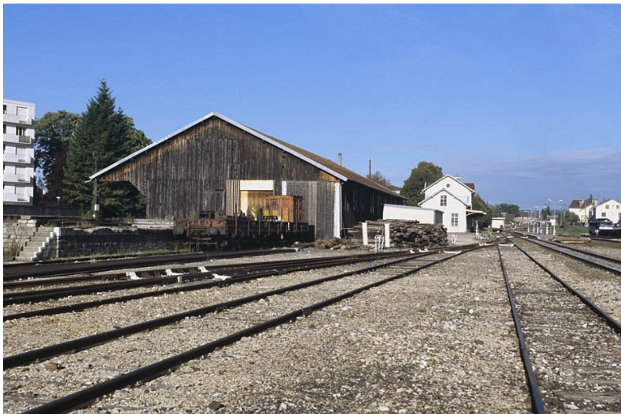
Entrepôt : vue d'ensemble, depuis le sud-est.
