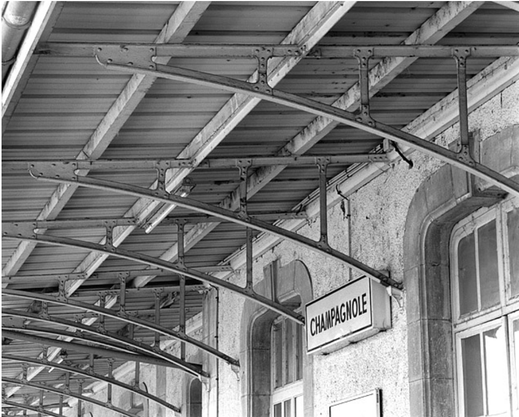
Bâtiment des voyageurs : consoles métalliques soutenant l'auvent.
