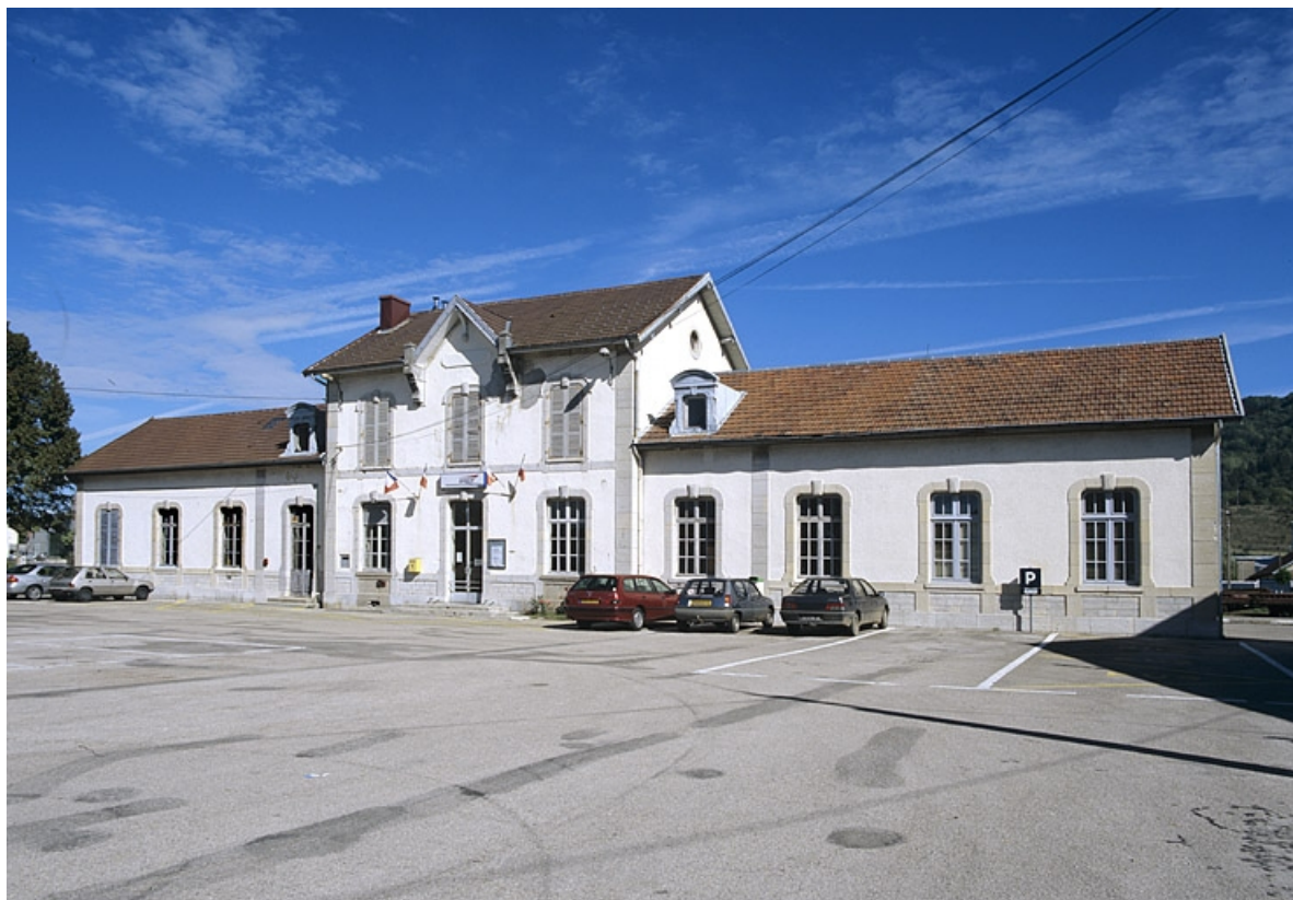
Bâtiment des voyageurs : vue d'ensemble, de trois quarts droite.
