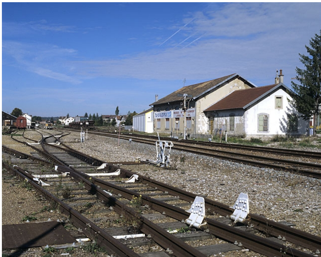
Vue d'ensemble de la remise ferroviaire (actuellement magasin de commerce), depuis le sud. 39, Champagnole, 13 avenue de la Gare
