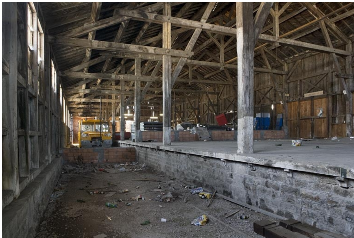
Entrepôt : intérieur, depuis l'angle nord-ouest.
