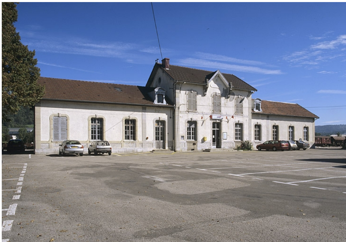
Bâtiment des voyageurs : vue d'ensemble, de trois quarts gauche.
