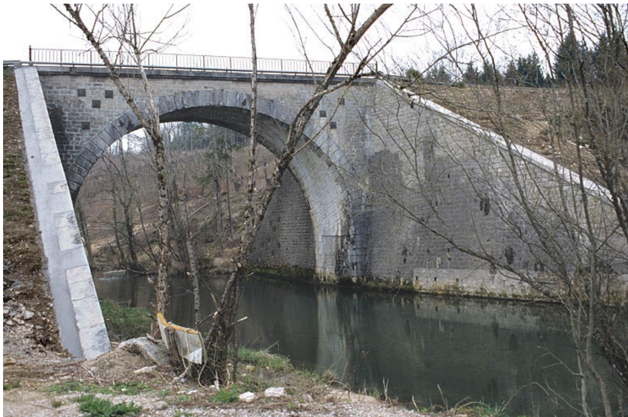
Pont sur l'Angillon : tête ouest (aval).
