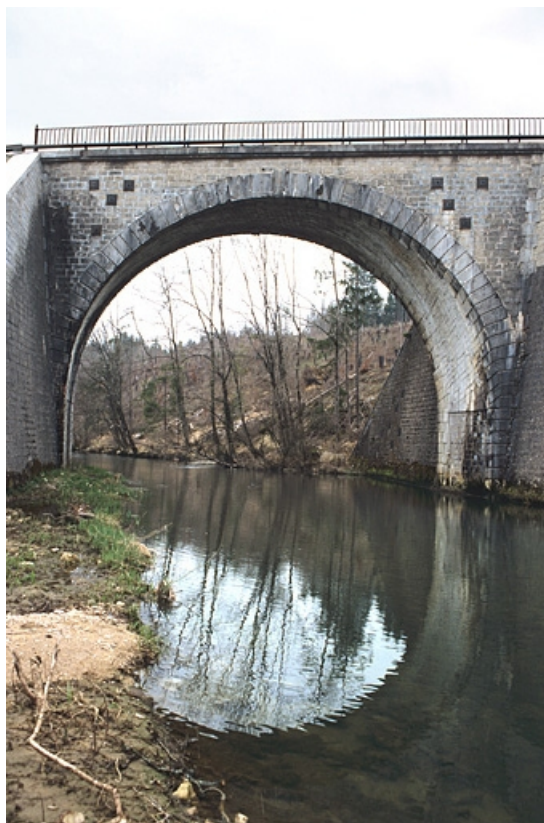
Pont sur l'Angillon : tête ouest (aval), appareil hélicoïdal. 39, Ardon R.D. 27
