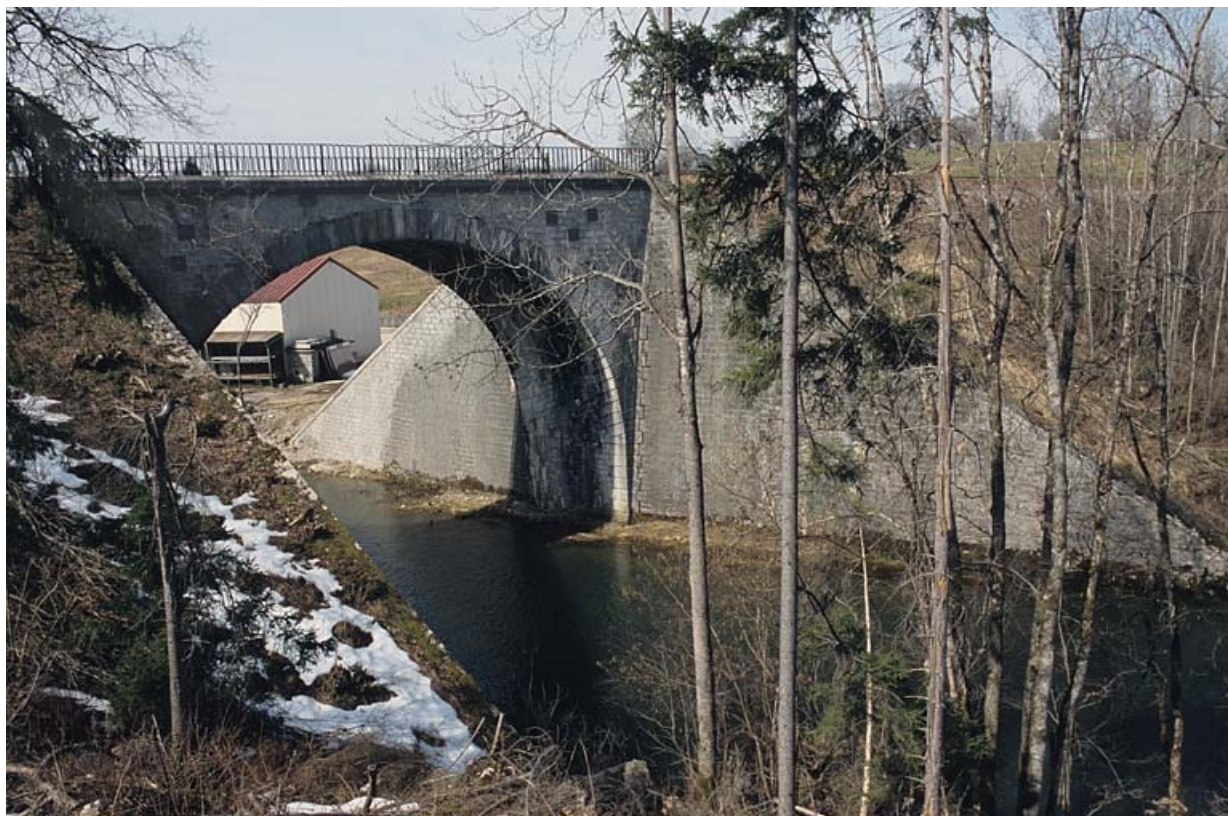
Pont sur l'Angillon : vue d'ensemble, depuis l'est (amont, rive gauche). 39, Ardon R.D. 27
