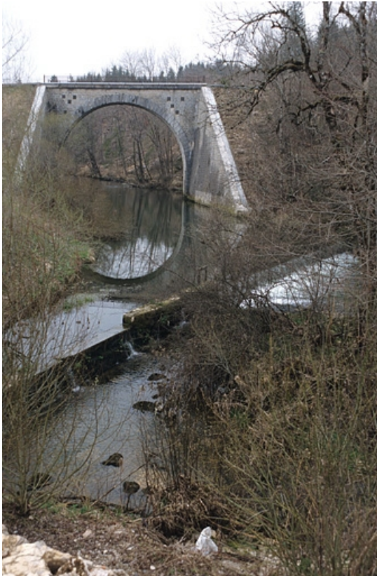
Au premier plan, le barrage de l'ancienne usine de menuiserie de la société des Constructions métalliques Fillod. 39, Ardon R.D. 27
